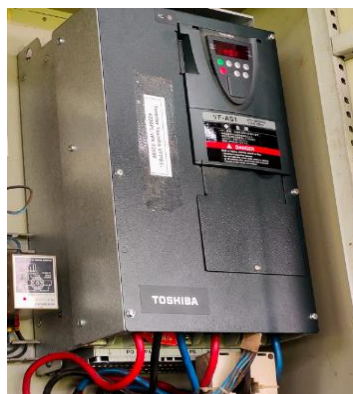
Gambar 2. 17 Install Inverter (Sumber: Dokumentasi, 2022)
