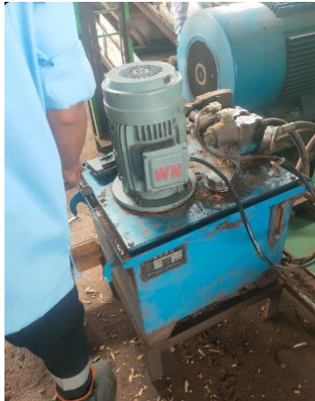
Gambar 2. 13 Install Motor 3 Phasa (Sumber: Dokumentasi, 2022)
