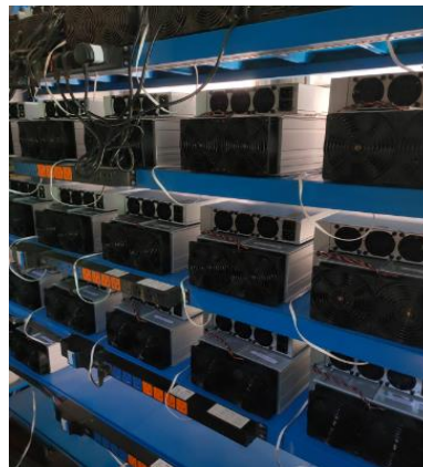
Gambar 2. 23 Install Data Center (Sumber: Dokumentasi, 2022)
