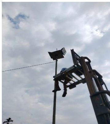
Gambar 2. 10 Install Lampu Sorot (Sumber: Dokumentasi, 2022)
