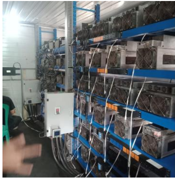
Gambar 2. 15 Install Visi Data Center (Sumber: Dokumentasi, 2022)
