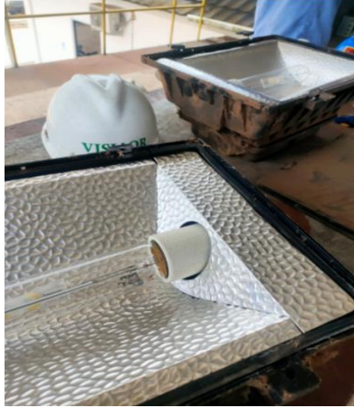
Gambar 2. 20 Maintenance Lampu Sorot (Sumber: Dokumentasi 2022)
