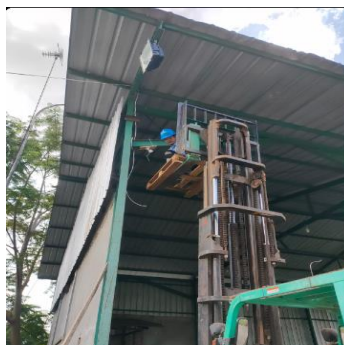
Gambar 2. 14 Install CCTV (Sumber: Dokumentasi, 2022)
