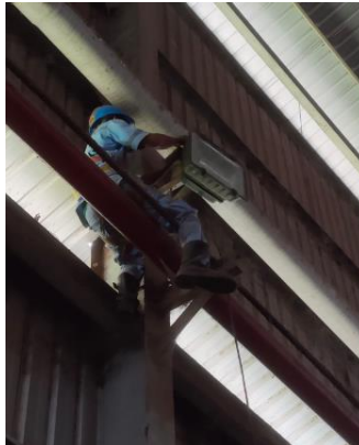
Gambar 2. 9 Installation Lampu Sorot (Sumber: Dokumentasi, 2022)
