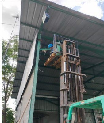
Gambar 2.13 Installation CCTV (Sumber: dokumentasi, 2022)
