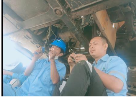
Gambar 2.18 Maintenance kabel excapator mini (Sumber:dokumentasi, 2022)
