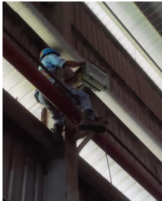
Gambar 2.9 Installation lampu sorot (Sumber: dokumentasi, 2022)
