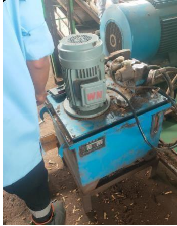
Gambar 2.12 Install motor 3 phasa (Sumber: dokumentasi, 2022)
