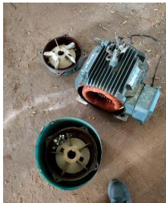
Gambar 2.5 Install motor 3 phasa (Sumber: dokumentasi, 2022)
