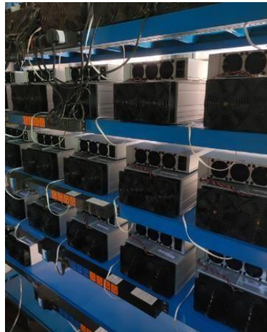
Gambar 2.19 Install data center (Sumber:dokumentasi, 2022)
