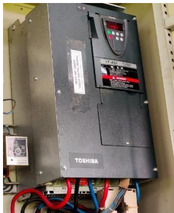
Gambar 2.16 Install inverter (Sumber: dokumentasi, 2022)
