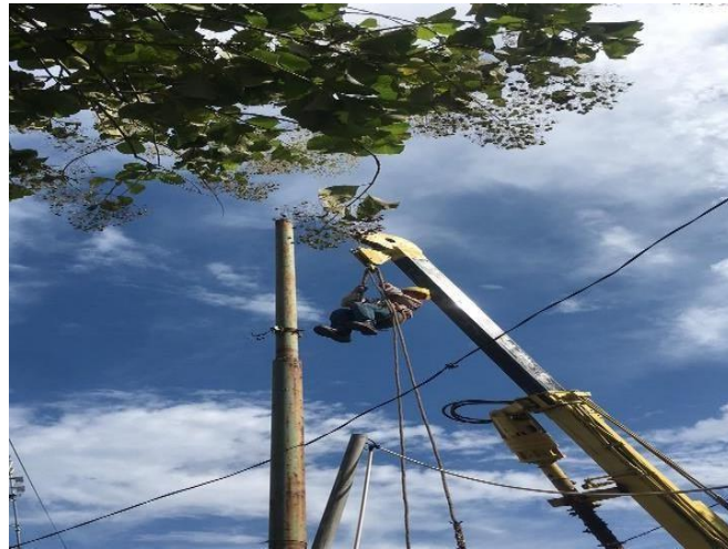
Gambar 2. 21 pemasangan kabel TM (Sumber: Dokumentasi 2022)
