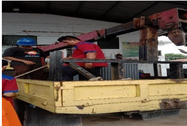
Gambar 2. 12 pembongkaran trapo (Sumber: Dokumentasi 2022)
