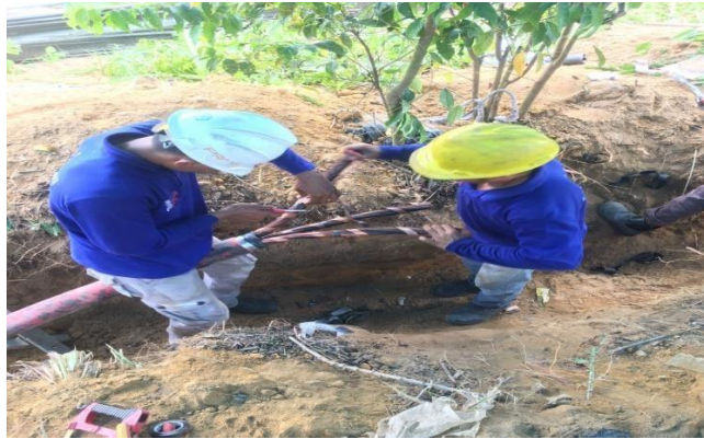
Gambar 3. 3 Jointing Kabel (Sumber: Dokumentasi 2022)
