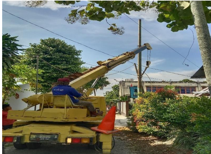
Gambar 2. 28 pemasangan tiang PLN (Sumber: Dokumentasi 2022)
