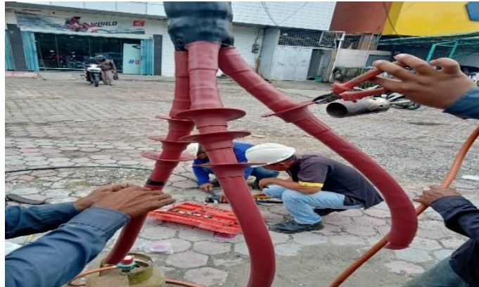
Gambar 2. 7 pemasangan scada (sumber: Dokumentasi 2022)
