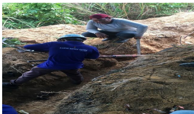
Gambar 2. 14 jointing kabel (Sumber: Dokumentasi 2022)
