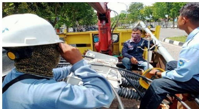
Gambar 2. 9 Pemindahan LBS (sumber: Dokumentasi 2022)
