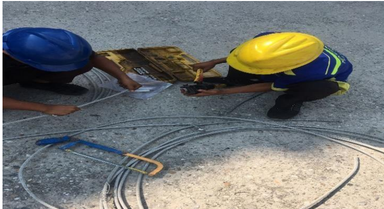
Gambar 2. 18 pemotongan kabel konduktor tembaga (Sumber: Dokumentasi 2022)
