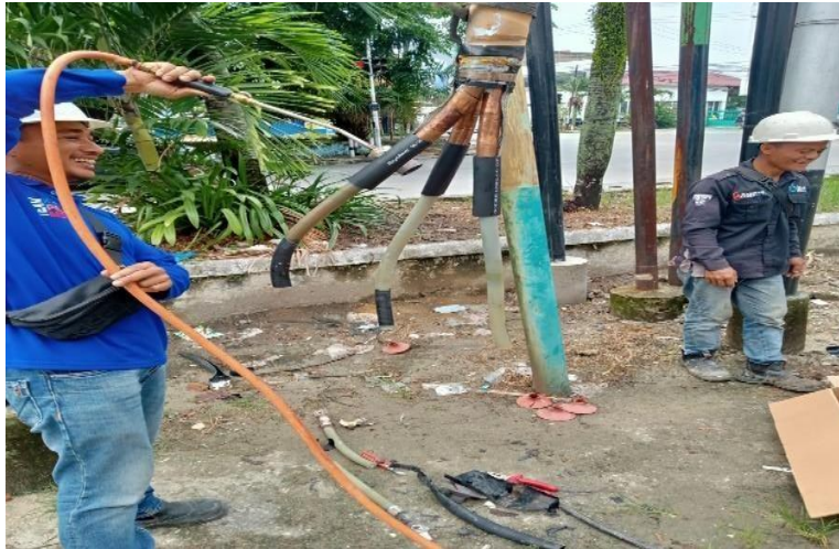
Gambar 2. 32 jointing kabel (Sumber: Dokumentasi 2022)
