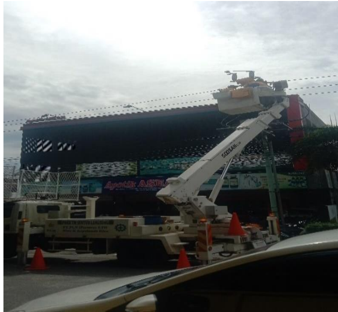
Gambar 2. 34 pesangan LBS (Sumber: Dokumentasi 2022)
