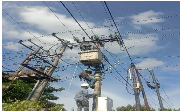
Gambar 2. 10 penggantian trapo (Sumber: Dokumentasi 2022)
