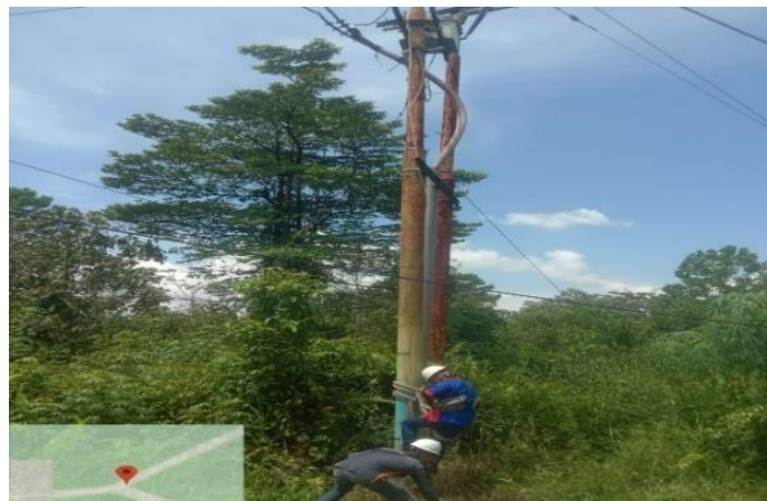
Gambar 2. 6 gangguan kabel TM (Sumber: Dokumentasi 2022)
