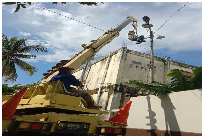
Gambar 2. 47 mobil crane (Sumber: Dokumentasi 2022)
