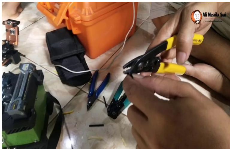
Gambar 3.4 Mengupas Kabel FO Sumber :(Dokumentasi,2022)
