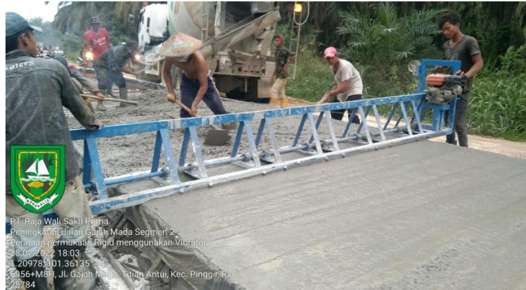
Gambar 3. 28 Pemadatan beton fs 45
