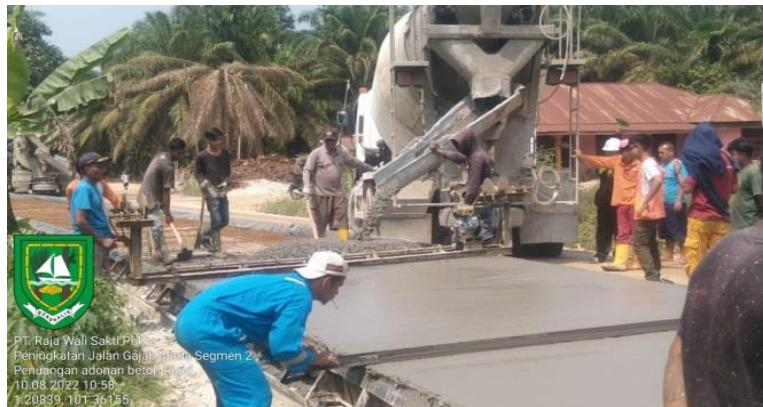
Gambar 3. 27 Pengecoran fs 45
