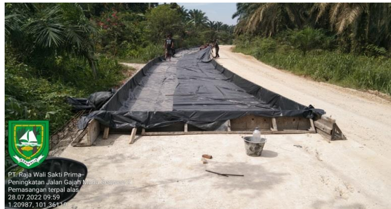
Gambar 3. 22 Pemasangan Plastik alas
