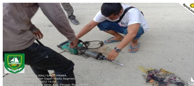
Gambar 3. 9 Jack Hammer Sumber : Dokumentasi Lapangan, 2022
