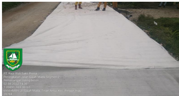
Gambar 3. 31 Pemasangan Geotextile non woven
