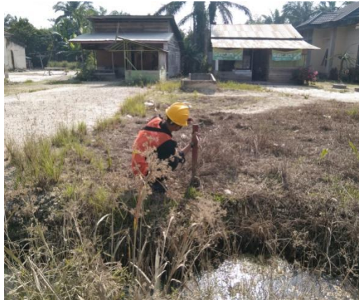
Gambar 3. 36 Pengecekan Patok Per STA Sumber : Dokumentasi Lapangan, 2022
