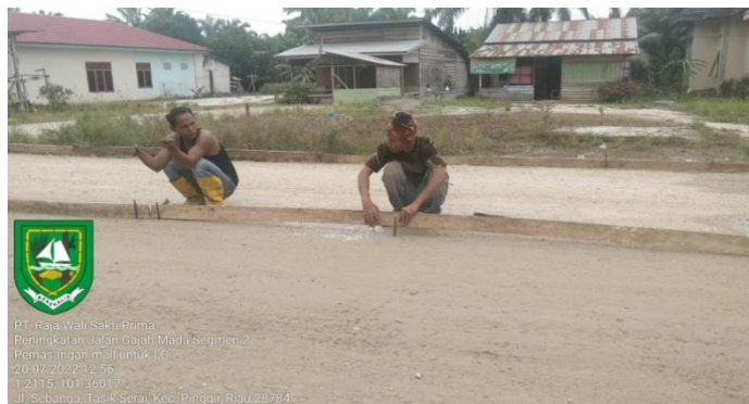
Gambar 3. 14 Pemasangan bekisting
