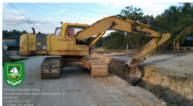
Gambar 3. 3 Excavator Sumber : Dokumentasi Lapangan, 2022
