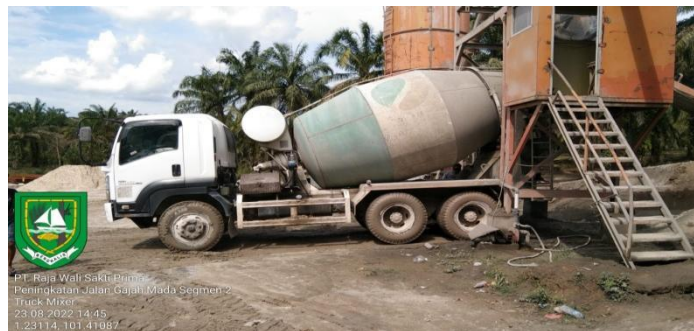
Gambar 3. 15 Pembuatan Beton Ready Mix
