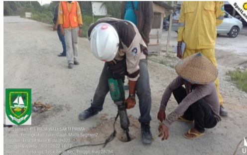
Gambar 3. 40 Pengujian Test Pit Sumber : Dokumentasi Lapangan, 2022
