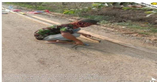
Gambar 3.18. Pekerjaan Pemasangan Mal LC Sumber : Dokumentasi Lapangan, 2022
