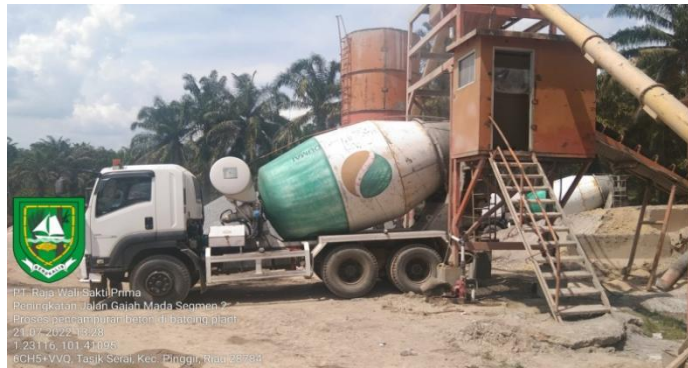
Gambar 3. 24 Pembuatan beton Ready mix
