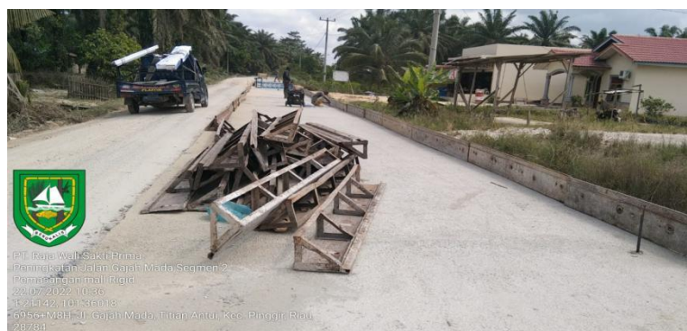
Gambar 3. 21 pemasangan bekisting rigid
