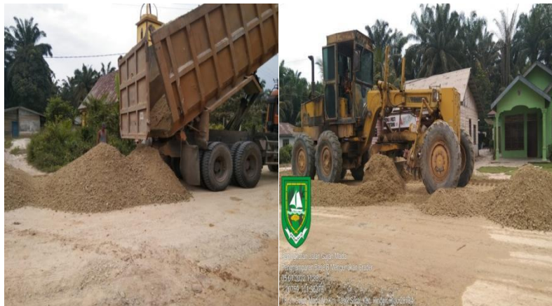
Gambar 3. 37 Pekerjaan penghamparan Base B oleh Truk dan Motor Grader Sumber : Dokumentasi Lapangan, 2022
