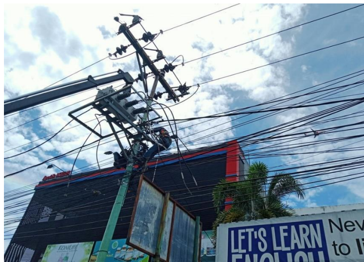
Gambar 2. 2 Pemasangan LBS oleh PT. Karya Satria Putra (Sumber : Dokumentasi, 2022)
