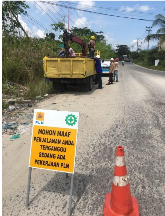
Gambar 2. 12 Pemasangan Trafo (Sumber : Dokumentasi, 2022)
