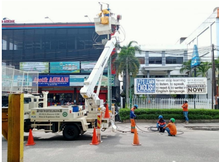
Gambar 2. 1 Pelepasan LBS oleh tim PDKB (Sumber : Dokumentasi, 2022)
