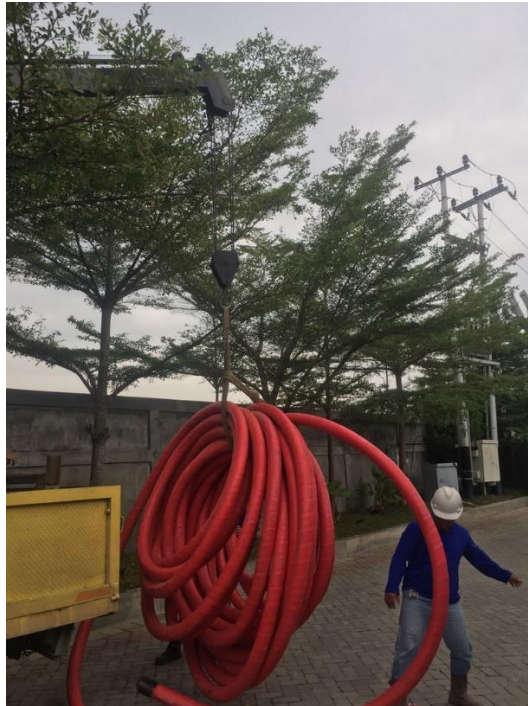
Gambar 2. 16 Pengantaran kabel tanah (Sumber : Dokumentasi, 2022)
