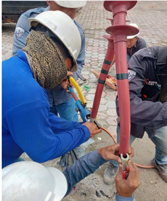
Gambar 2. 19 Terminating kabel tanah (Sumber : Dokumentasi, 2022)
