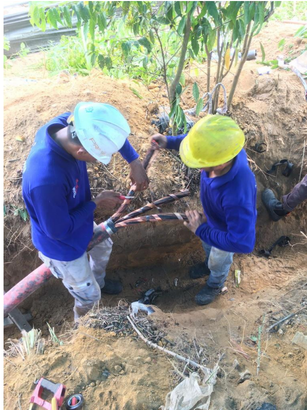
Gambar 2. 24 Jointing kabel tanah (Sumber : Dokumentasi, 2022)
