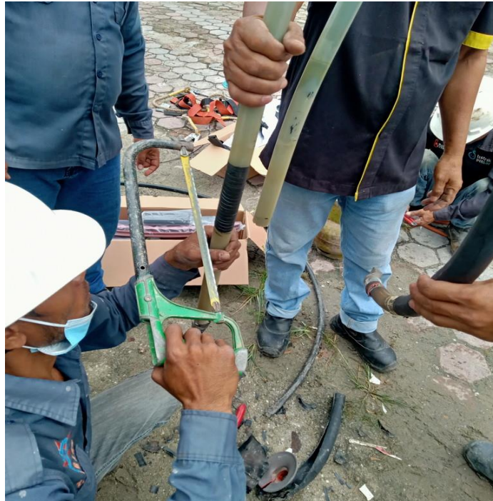
Gambar 2. 4 Terminating kabel tanah (Sumber : Dokumentasi, 2022)
