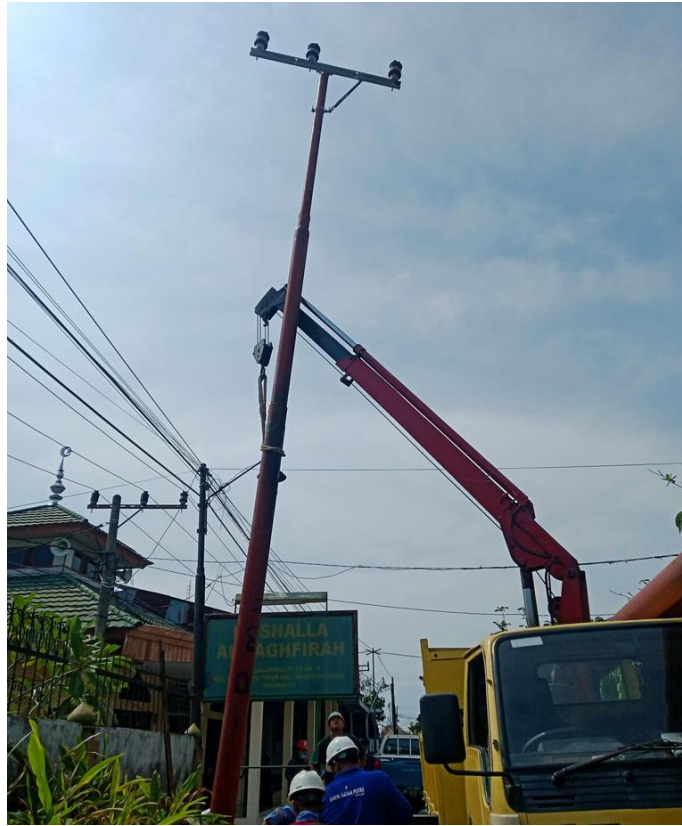
Gambar 2. 9 Pendirian tiang listrik (Sumber : Dokumentasi, 2022)
