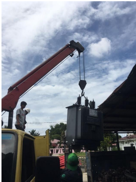
Gambar 2. 23 Pengantaran Trafo ke gudang Trafo (Sumber : Dokumentasi, 2022)
