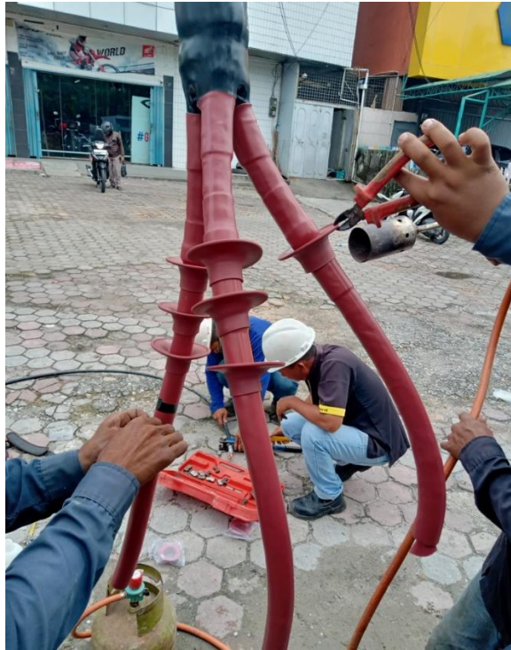
Gambar 2. 13 Terminating kabel tanah (Sumber : Dokumentasi, 2022)
