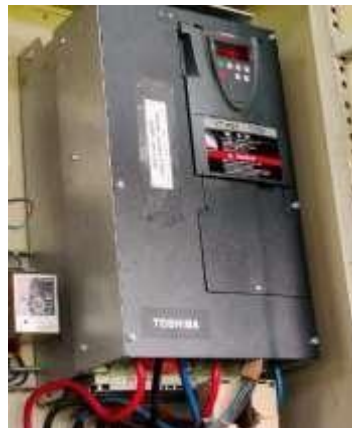
Gambar 2.16 Photo install inverter (Sumber: dokumentasi, 2022)
