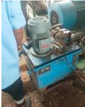
Gambar 2.12 Photo install motor 3 phasa (Sumber:dokumentasi, 2022)
