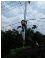
Gambar 2.46 perbaikan kabel SR pelanggan yang kendur
