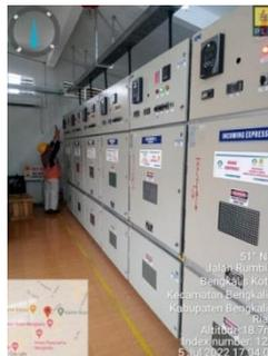
Gambar 2.24 pengecekan beban *fedder*
