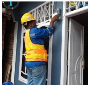
Gambar 2.52 penggantian MCB (*Miniatur Circuit Breaker*)
