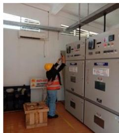
Gambar 2.5 pengecekan eviden beban *feeder*.
