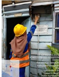
Gambar 2.31 input KCT di kWh pelanggan
