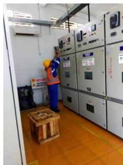
Gambar 2.34 pengecekan eviden beban *feeder*
