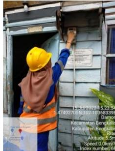
Gambar 2.31 input KCT di kWh pelanggan
