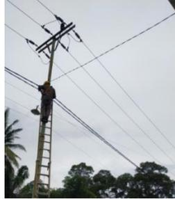
Gambar 3.6 Perbaikan los kontak Nol/Nertal
