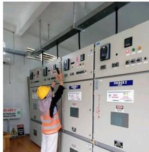
Gambar 2.8 pengecekan eviden beban *fedeer*
