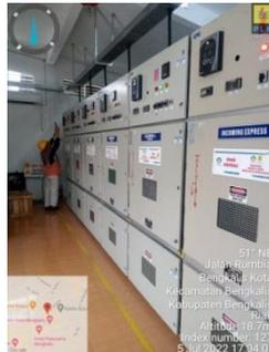
Gambar 2.24 pengecekan beban *fedder*
