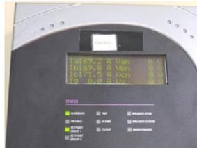
Gambar 2.54 pengecekan eviden beban *fedeer*
