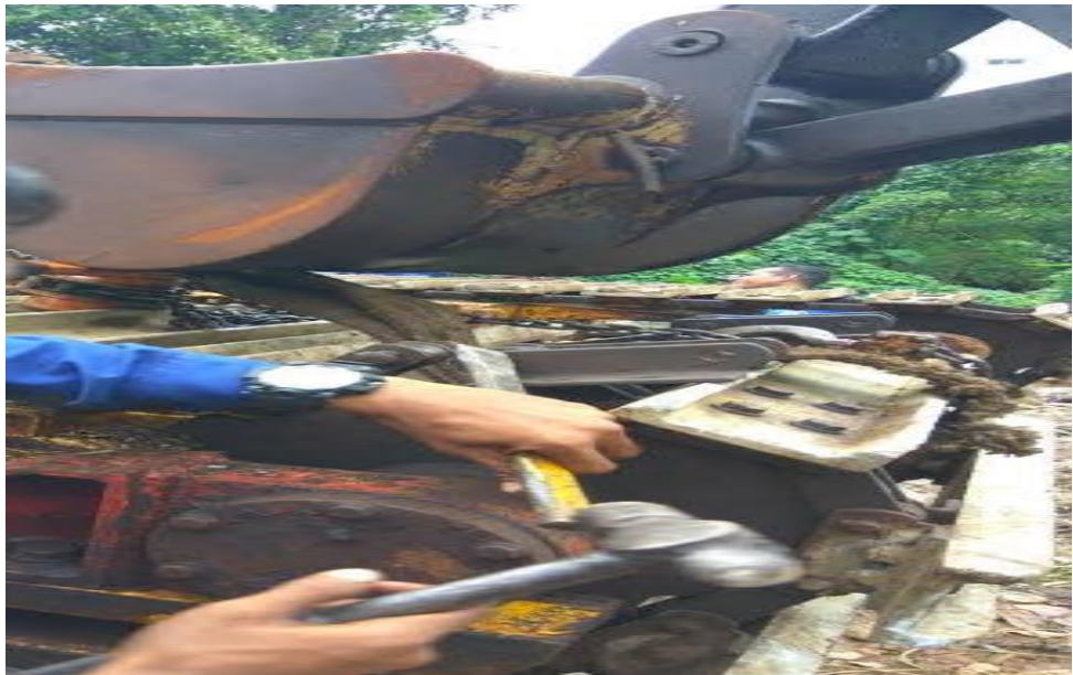
Gambar 4.3 Memeriksa kondisi semua baut-baut (sumber. Dokumentasi pribadi penulis,2021)
