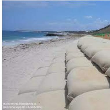
Gambar 1.1 Turap Karung Pasir dengan Metode Kering
