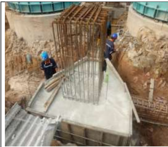
Gambar 3. 42 Pembongkaran Bekisting Pada Pc 3
