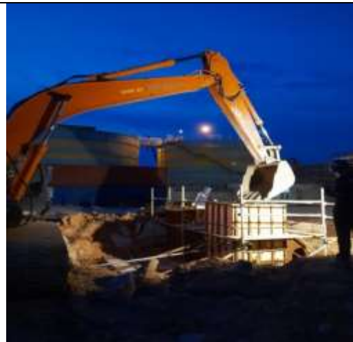
Gambar 3. 47 Pengecoran Pada Pedestal
