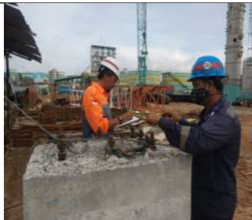
Gambar 3. 37 Pengambilan Data After Cor Pada Pipe Rack
