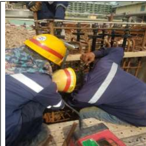
Gambar 3. 34 Proses Pemasangan Anchor Pada Pipe Rack
