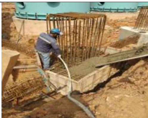
Gambar 3. 40 Pengecoran Pada Pc3
