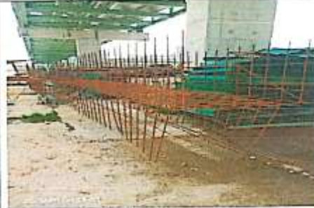
Tulangan / Rebar Drainase
