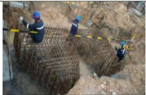
Gambar 3. 29 Proses Rebar Pada Pc3
