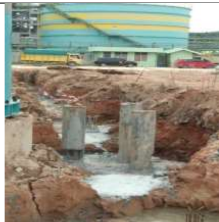
Gambar 3. 15 Pembobokan Pile Cap
