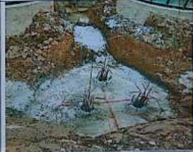
Proses marking survey untuk menentukan centre line sebelum instal rebar
