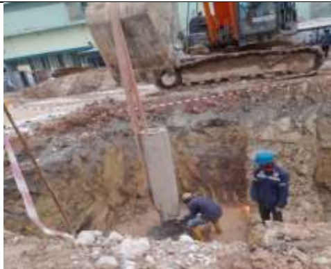
Gambar 3. 12 Pengikatan Sling Pada Pile Cap
