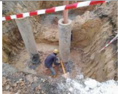
Gambar 3. 13 Pemotongan Pile Cap
