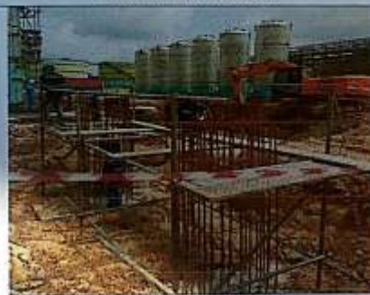
Pemasangan Scaffolding untuk pemasangan angkur pedestal
