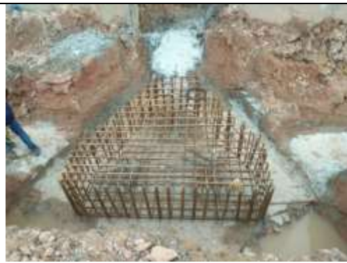
Gambar 3. 26 Proses Rebar Pada Pc3
