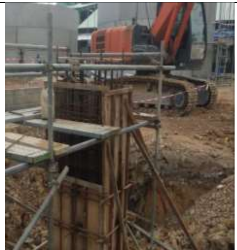
Gambar 3. 35 Proses Pemasangan Anchor Pada Pipe Rack
