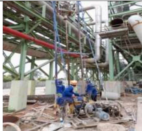
Gambar 3. 1 Proses pemancangan Pilling cape oleh PT.TKM
