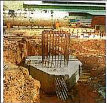
Tampak pile cap tiga yang sudah di cor
