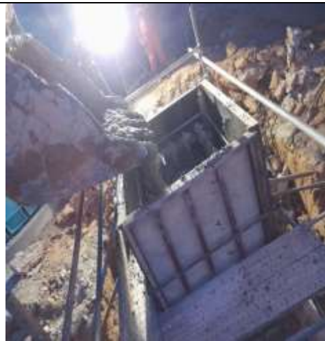
Gambar 3. 46 Pengecoran Pada Pedestal
