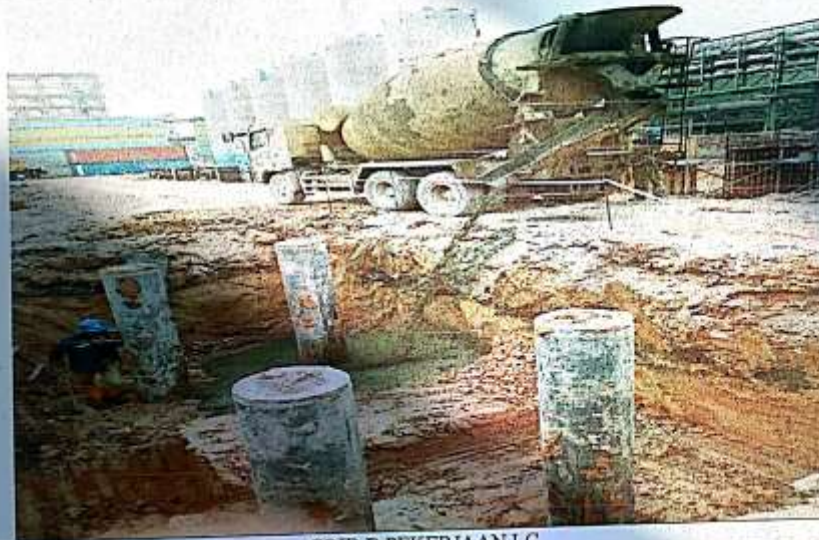
GRID B PEKERJAAN LC
