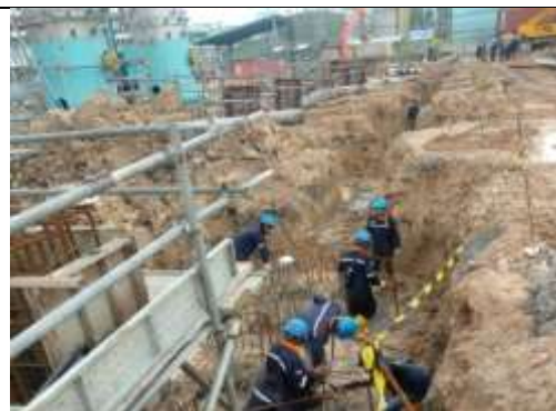
Gambar 3. 18 Proses pemasangan rebar PHT
