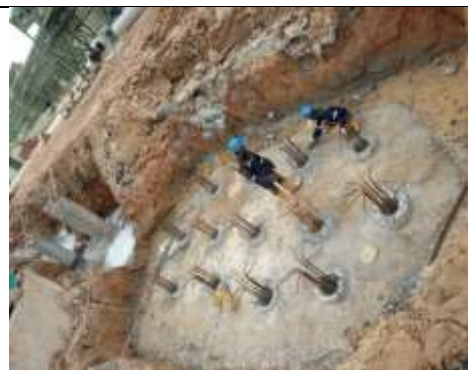
Gambar 3. 19 Proses pemasangan rebar PHT
