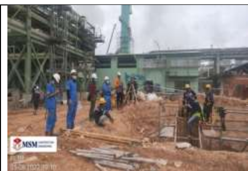
Gambar 3. 39 Pengambilan Data Before Cor Pada Pipe Rack
