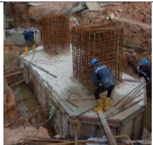
Gambar 3. 43 Pembongkaran Bekisting Pada Pc 13
