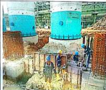
Pembuatan bekisting ground beam
