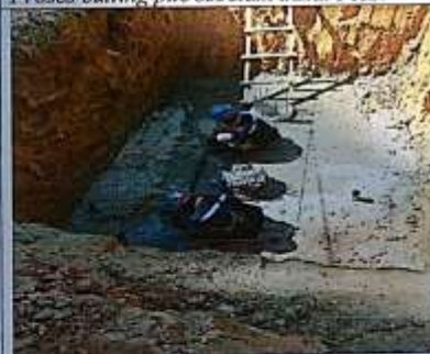
Proses marking survey untuk menentukan centre line sebelum instal rebar
