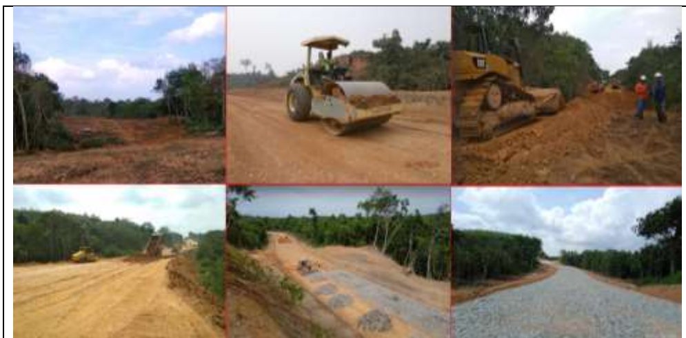
Gambar 1. 14 Sumber: PT.MSM Konstruksi Jalan
