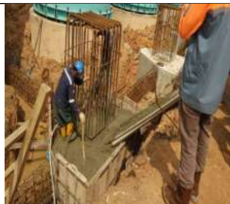
Gambar 3. 41 Pengecoran Pada Pc3
