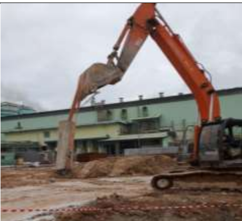
Gambar 3. 14 Pengangkatan Pile Cap Yang Sudah Di Bobok
