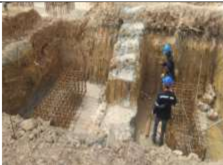
Gambar 3. 28 Proses Rebar Pada Pipe Rack
