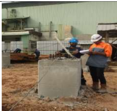
Gambar 3. 36 Pengambilan Data After Cor Pada Pipe Rack
