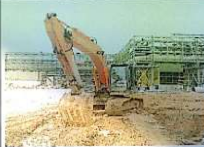
Salah satu alat berat yang digunakan yaitu excavator
