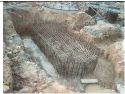
Gambar 3. 27 Proses Rebar Pada Pc13
