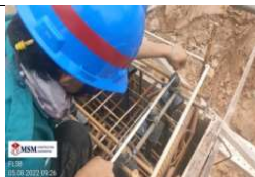
Gambar 3. 38 Pengambilan Data Before Cor Pada Pipe Rack
