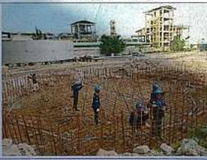
Proses rebar pada hp tank
