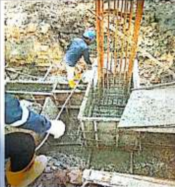
Proses vibrator concrete, upaya untuk mengatasi beton keropos
