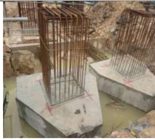
Gambar 3. 45 Pembuatan Center Line
