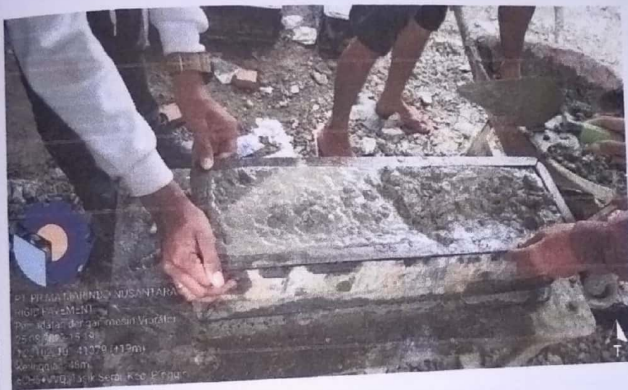
Membuat Sampel Beton Balok Rigid Pavement (Pemadatan menggunakan Mesin Vibrator)
