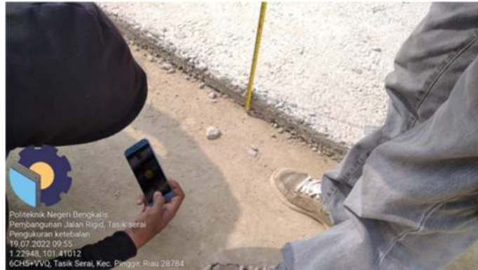
Gambar 3. 15 Pekerjaan pengukuran Opname (Sumber : Dokumentasi Lapangan, 2022)
