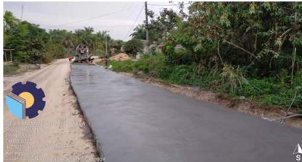
Gambar 3.9 Pekerjaan Lean Concrete (Sumber : Dokumentasi Lapangan, 2022)
