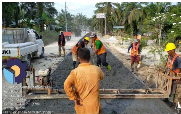
Gambar 3. 14 Pekerjaan Concrete paver (Sumber : Dokumentasi Lapangan, 2022)
