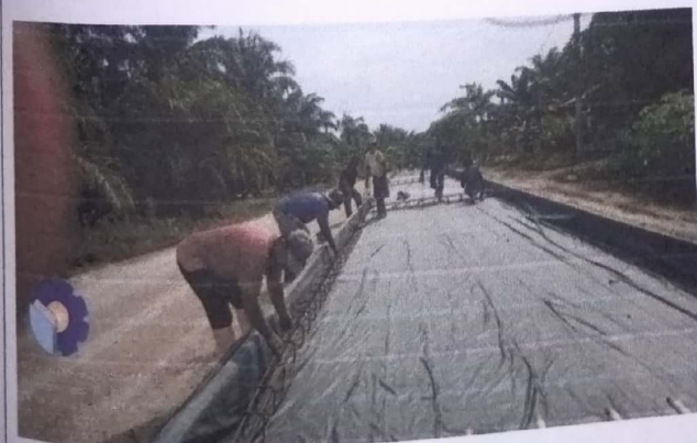
Pembesian dudukan TieBars STA 0+800 – 1+000
