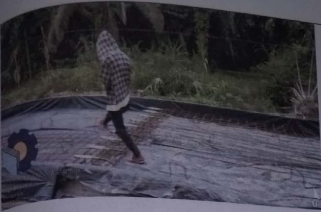
Pekerjaan Pembesian STA 0+600 – 0+700
