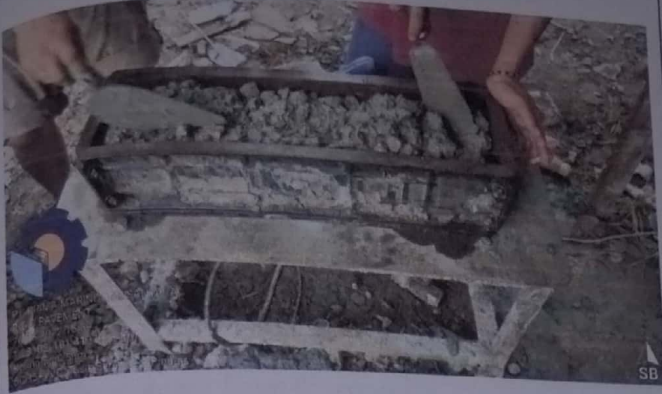
Pembuatan sampel beton Balok Rigid Pavement
