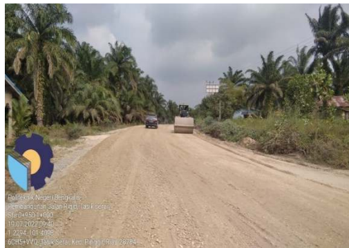
Gambar 3.5 Lapis Pondasi atau Agregat Kelas B (Sumber : Dokumentasi Lapangan, 2022)
