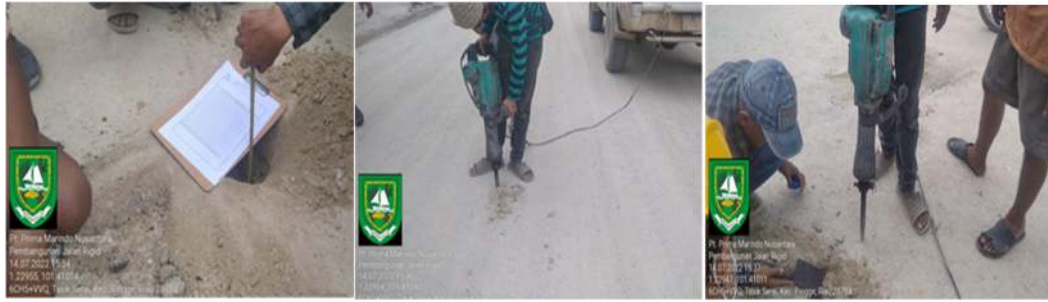
Gambar 3. 11 Pekerjaan Core Base (Sumber : Dokumentasi Lapangan, 2022)
