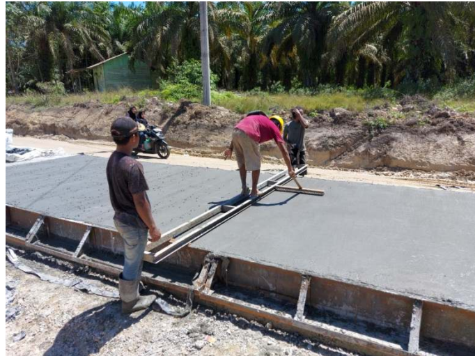
Gambar 3. 26 Proses Pembuatan Grooving (Sumber : Dokumentasi Lapangan, 2022)
