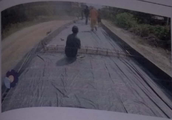
Pembesian dudukan Dowel STA 0+800 – 1+000
