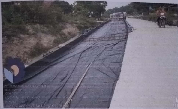
Pekerjaan pembesian STA 1+500 – 1+600
