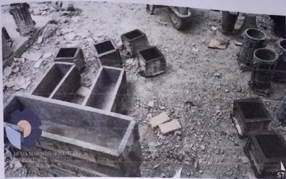
Menyiapkan cetakan sampel beton
