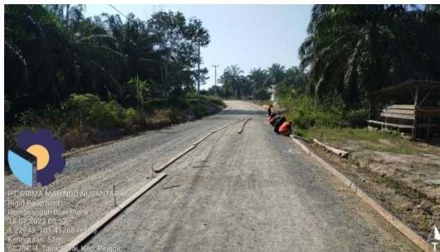
3.12 Pekerjaan Bowplank (Sumber : Dokumentasi Lapangan, 2022)
