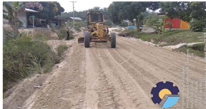
Gambar 3.7 Pekerjaan Penghamparan dan Pemerataan Base B (Sumber : Dokumentasi Lapangan, 2022)
