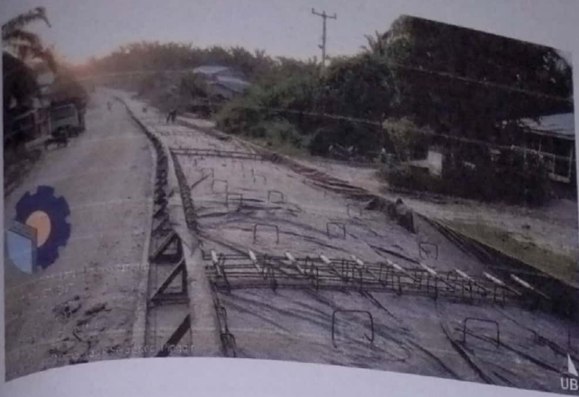
Kegiatan Pembesian Dowel dan Dudukan Dowel pada STA 0+500 - 0+600
