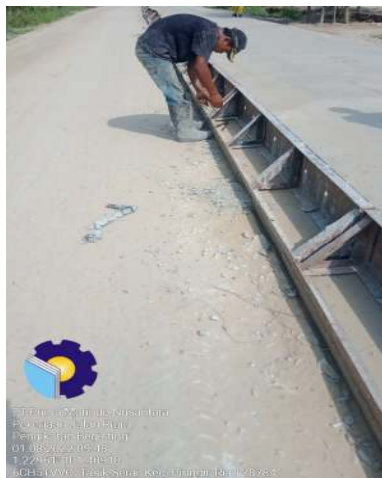
Gambar 3. 21 Pekerjaan Pemasangan Tiebar (Sumber : Dokumentasi Lapangan, 2022)
