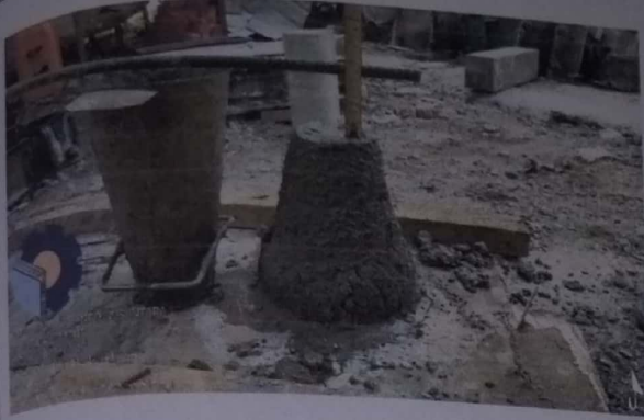
Membuat slump Lean Concrete
