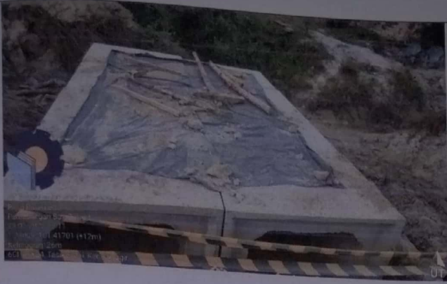
Pemasangan Box Culvert pada STA 1+850
