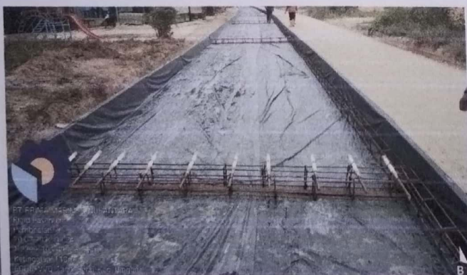
Pemasangan Besi Dowel STA 1+064 – 1+200
