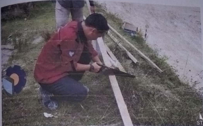
Pembuatan Posko jalan
