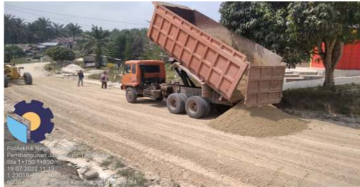
Gambar 3.6 Penghamparan lapisan pondasi atau Agregat Kelas B (Sumber : Dokumentasi Lapangan, 2022)
