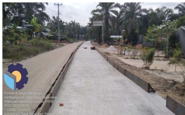
Gambar 3.10 Pekerjaan mal Bekisting diatas Lean Concrete (Sumber : Dokumentasi Lapangan, 2022)
