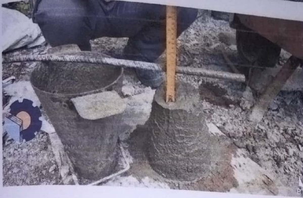
Pengujian dan nilai slump Lean Concrete
