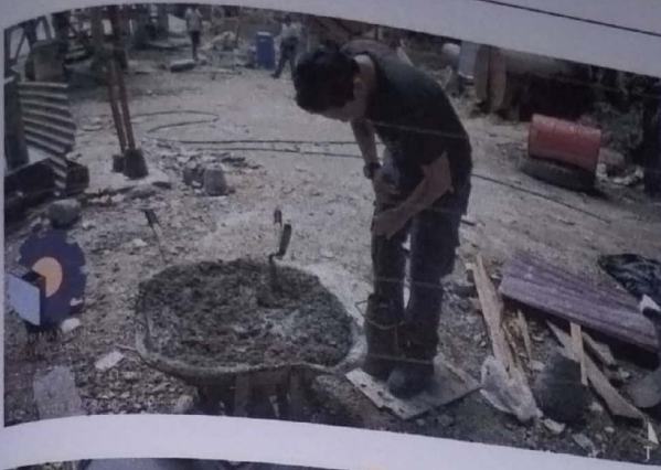
Proses pembuatan slump Lean Concrete
