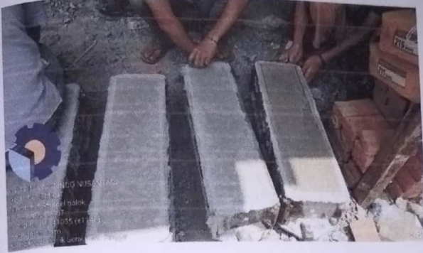
Membuka dan mengambil sampel beton balok rigid pavement
