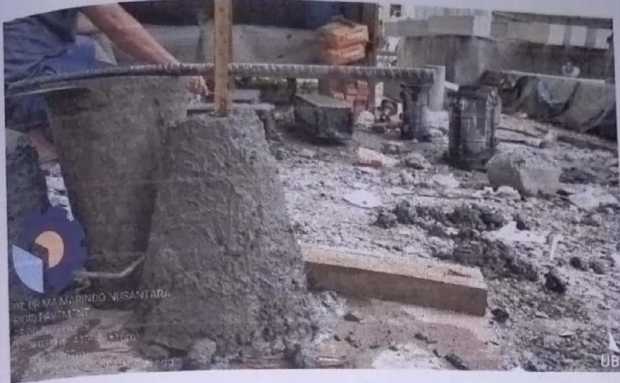
Melakukan proses pembuatan Uji Slump Rigid Pavement dengan syarat 8 cm
