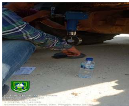
Gambar 3.3. Menentukan Nilai CBR (Sumber : Dokumentasi Lapangan, 2022)
