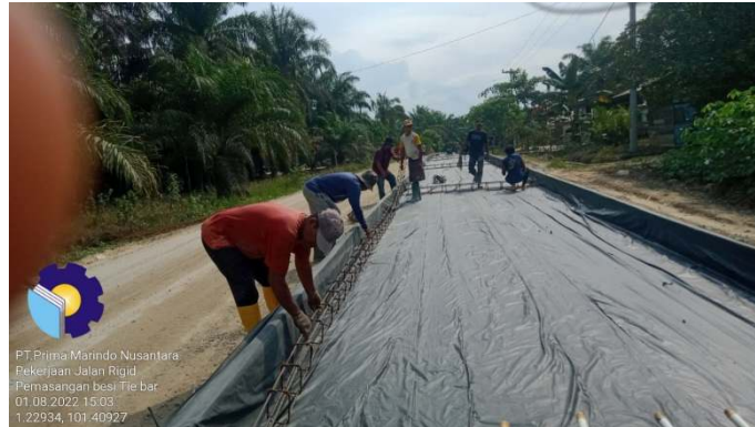
Gambar 3. 22 Pekerjaan pemasangan Dudukan Tie bars (Sumber : Dokumentasi Lapangan, 2022)
