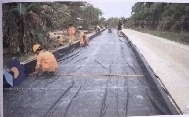
Pengukuran dan Memberi batas persegmen STA 0+800 – 1+000
