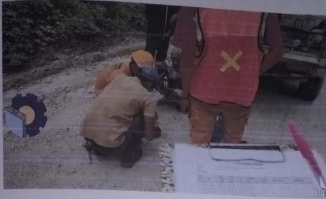
Kegiatan siang melakukan Pengukuran Core Base B untuk Lane Concrete pada STA 0+500 - 1+000
