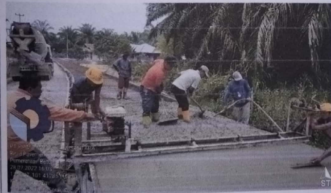
Pekerjaan Rigid Pavemant pada STA 1+400 - 1+500
