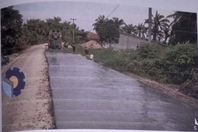
Kegiatan pengecoran Lane Concrete pada STA 0+300 - 0+400
