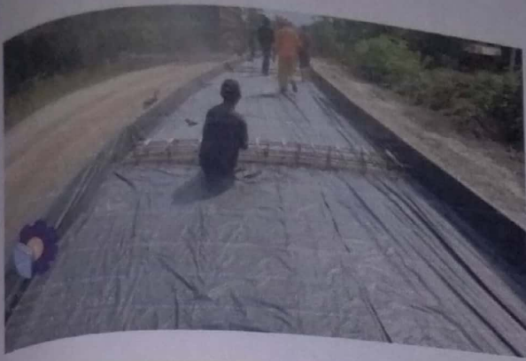
Pembesianudukan Dowel STA 0+800 – 1+000
