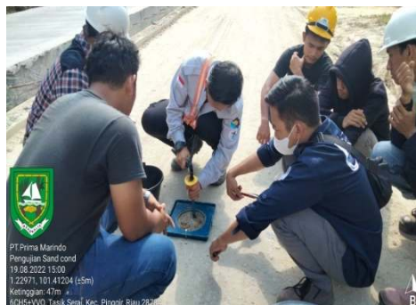
3.4 Pengujian Sand Cone (Sumber : Dokumentasi Lapangan, 2022)
