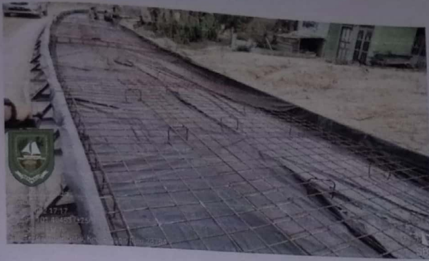
Pekerjaan pembesian pada STA 0+200 – 0+300
