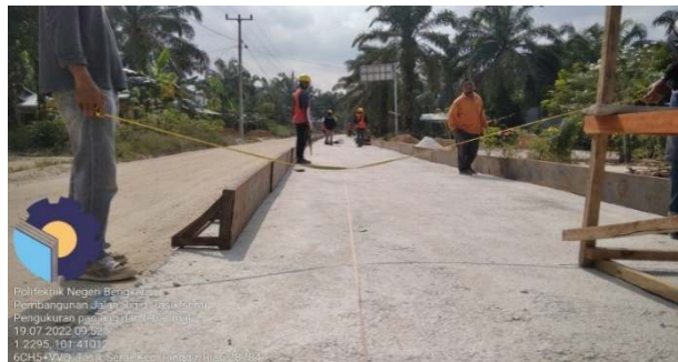
Gambar 3. 18 Pekerjaan persiapan lebar jalan yang akan di Rigid pavement (Sumber : Dokumentasi Lapangan, 2022)
