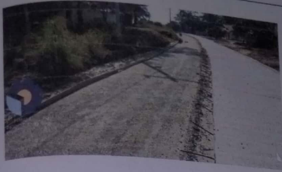
Pekerjaan Bow Plank STA 1+300 - 1+400
