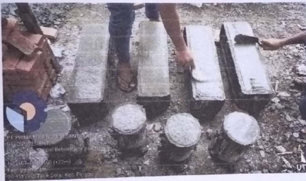
Pembuatan sampel balok dan silinder untuk pekerjaan Rigid Pavement
