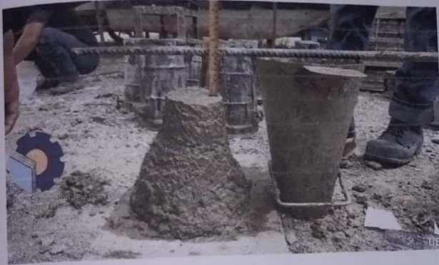
Pembuatan slump lean concrete untuk cek mutu LC
