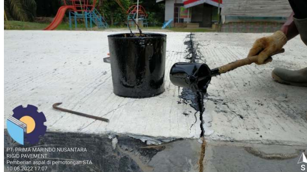
Gambar 3. 29 Proses pemberian Joint Sealent (Sumber : Dokumentasi Lapangan, 2022)
