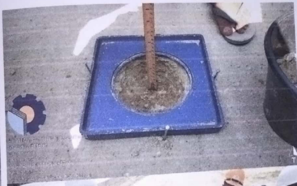
proses pekerjaan membuat lobang atau galian uji sandcone dengan tinggi yang di izinkan 10cm untuk mengambil sampel tanah
