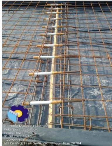
Gambar 3. 19 Pekerjaan pemasangan Dowel dan Dudukan Dowel (Sumber : Dokumentasi Lapangan, 2022)
