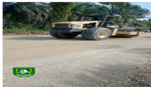
Gambar 3.8 Pekerjaan Pemadatan Base B (Sumber : Dokumentasi Lapangan, 2022)
