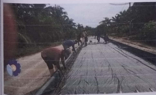
Pembesianudukan TieBars STA 0+800 – 1+000
