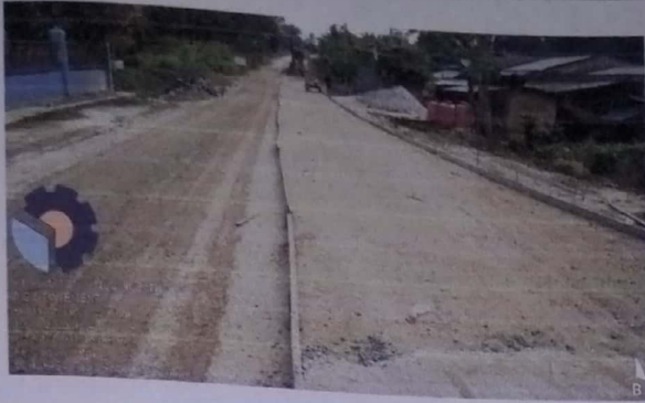
Pemasangan Bow Plank pada STA 0+250 – 0+300
