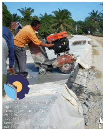
Gambar 3. 1 Proses Cutting (Sumber : Dokumentasi Lapangan, 2022)
