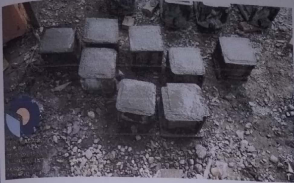
Membuat slump Kubus Lean Concrete
