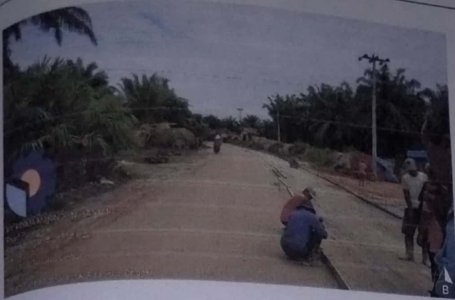
Pemasangan Bow plank STA 0+500 – 0+600
