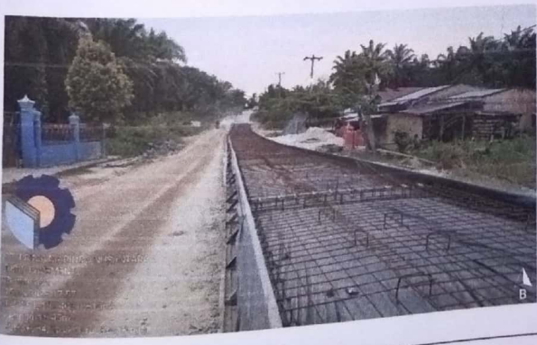
Pekerjaan lanjutan pembesian STA 0+000 - 0+100
