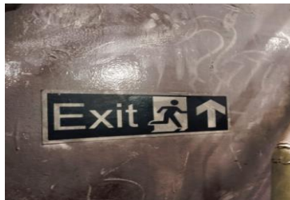
Gambar 2.88 kondisi kamar mesin
