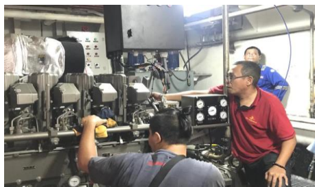
Gambar 2.60 proses pengecekan mesin
