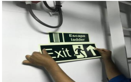
Gambar 2.29 Pemasangan stiker safety plan
