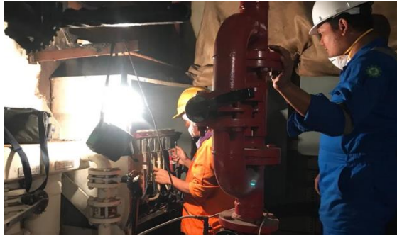
Gambar 2.63 proses pengecekan Trafo kapal repair
