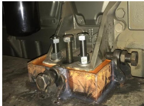
Gambar 2.58 hasil penunangan cairan chockfast
