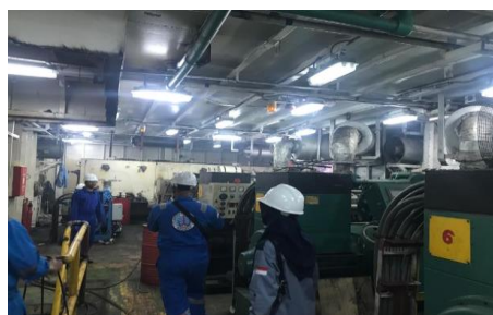
Gambar 2.4 Pengecekan Instalasi listrik
