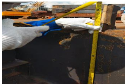
Gambar 2.34 hasil Fit Up check\
