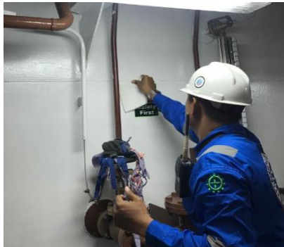
Gambar 2.64 Pemasangan Stiker Sefty Plan
