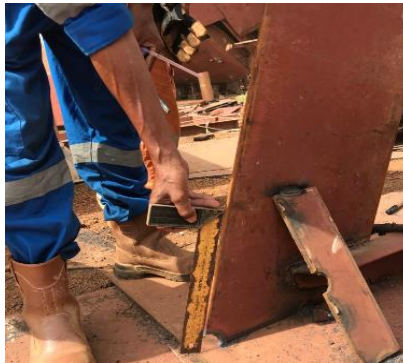
Gambar 2.47 proses Pengukuran Fit Up
