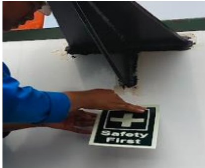
Gambar 2.55 pemasangan stiker sefty plan
