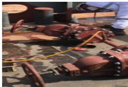
Gambar 2.25 hydro test Pada valve
