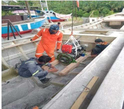
Gambar 2. 67 Pemasangan Mesin 48 PK
