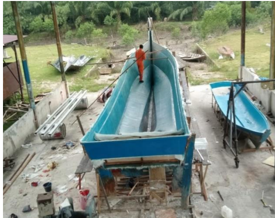
Gambar 2. 26 Pengerjaan lanjutan Laminassi Kapal
