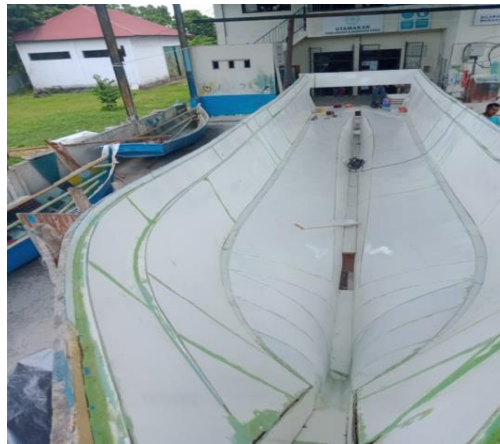
Gambar 2. 18 Repair Cetakan Kapal 5 GT
