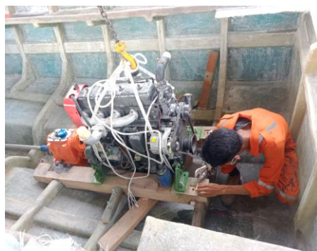
Gambar 2. 61 Pemasangan mesin 48 PK
