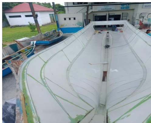
Gambar 2. 17 Repair Cetakan Kapal 5 GT
