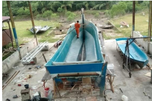
Gambar 2. 36 Pengerjaan Laminasi Lambung Kapal 5 GT yang Kedua
