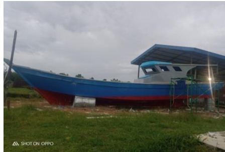
Gambar 2. 72 Pengecatan bangunan atas Kapal 4 GT
