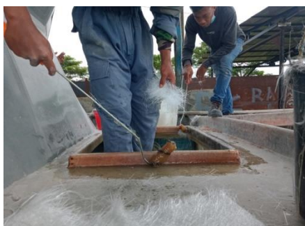
Gambar 2. 52 Pembuatan Chain Locker
