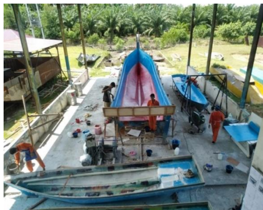
Gambar 2.11 Pelapisan Gelcoat
