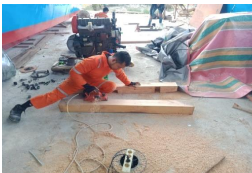
Gambar 2. 64 Pembuatan tapak/pondasi Mesin
