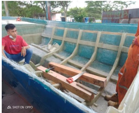
Gambar 2. 33 Pemasangan Tapaak Mesin Kapal 4 GT
