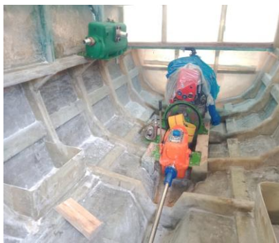
Gambar 3. 5 Pemasangan Cooler Pendingin Mesin
