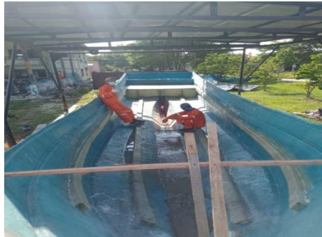
Gambar 2. 39 Pekerjaan Laminasi Gading 5 GT
