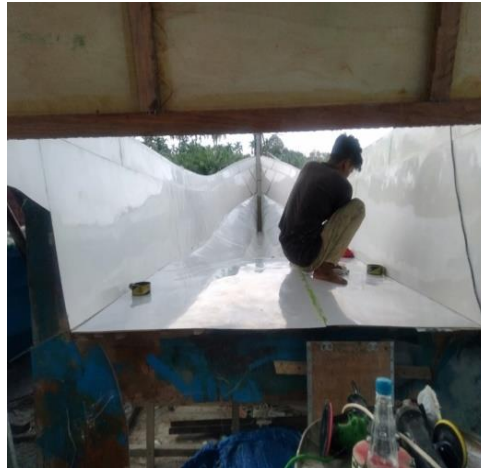
Gambar 2. 8 Pekerjaan mirror glase
