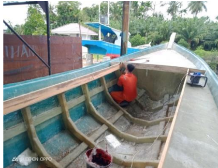
Gambar 2. 44 Pekerjaan Laminasi Tong Haluan kapal 5 GT
