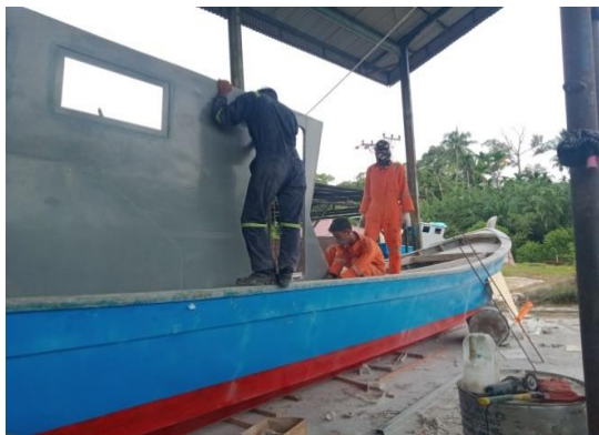
Gambar 2. 66 Perakitan bangunan atas
