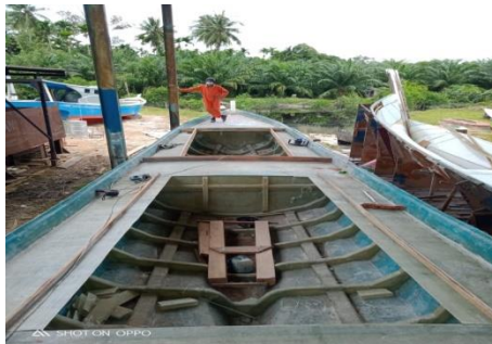
Gambar 2. 43 Pembuatan Deck Kapal 5 GT
