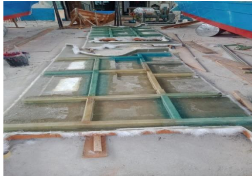
Gambar 2. 55 Pekerjaan Laminasi Gading Penguat Bangunan Atas
