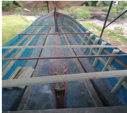
Gambar 2. 14 Pembuatan Gading Memanjang
