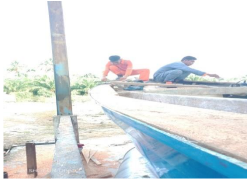
Gambar 2. 57 Pekerjaan Pembuatan Fender
