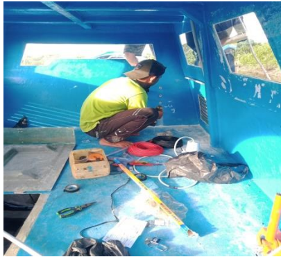
Gambar 2. 80 Pemasangan Alat Navigasi
