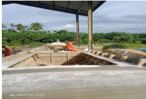
Gambar 2. 50 Pembuatan Deck Kapal 5 GT
