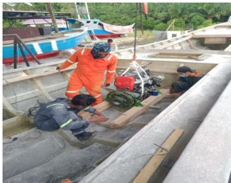
Gambar 3. 4 Pemasangan mesin 48 PK
