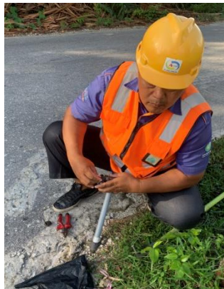
Gambar 2.17 Mengganti fuse link (Sumber: PLN. Rayon Bengkalis PT. Adra gemilang. 2022)
