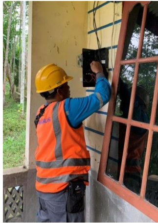
Gambar 2.14 Loss Kontak (Sumber: PLN. Rayon bengkalis PT. Adra gemilang. 2022)
