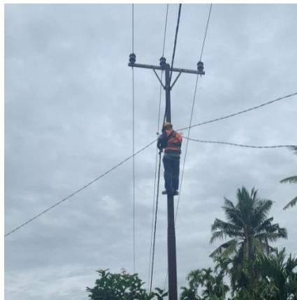
Gambar 2.19 Penyambungan kabel SR (Sumber: PLN. Rayon bengkalis PT. Adra gemilang. 2022)
