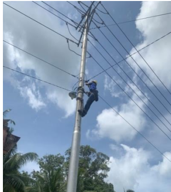
Gambar 2.5 Mengganti Perching (Sumber: PLN. Rayon bengkalis PT. Adra gemilang. 2022)
