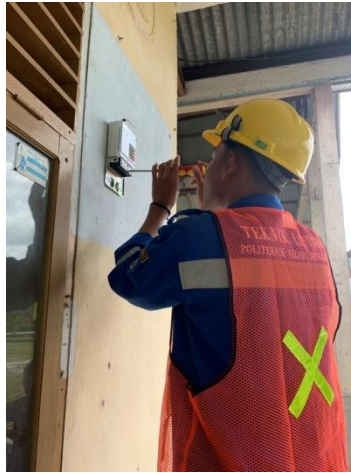
Gambar 2.7 Memasang KWH Meter baru (Sumber: PLN. Rayon bengkalis PT. Adra gemilang. 2022)
