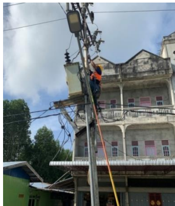
Gambar 2.6 Mengambil kabel SR (Sumber: PLN. Rayon bengkalis PT. Adra gemilang. 2022)
