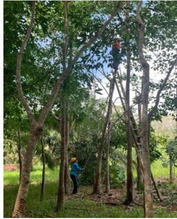
Gambar 2.11 ROW (Sumber: PLN. Rayon bengkalis PT. Adra gemilang. 2022)
