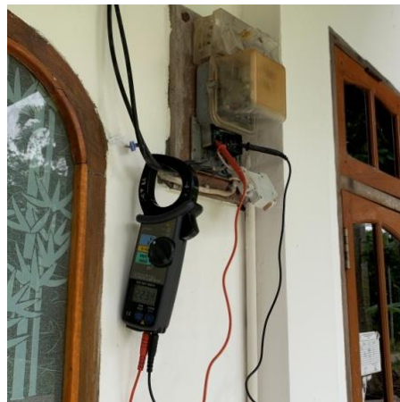
Gambar 2.15 Pengecekan Tegangan (Sumber: PLN. Rayon bengkalis PT. Adra gemilang. 2022)
