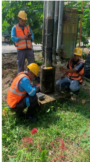
Gambar 2.18 Pemasangan Grounding (Sumber: PLN. Rayon bengkalis PT. Adra gemilang. 2022)
