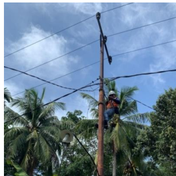
Gambar 2.10 Penyambungan kabel SR (Sumber: PLN. Rayon bengkalis PT. Adra gemilang. 2022)
