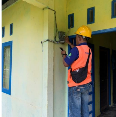
Gambar 2.16 kWh meter periksa (Sumber: PLN. Rayon bengkalis PT. Adra gemilang. 2022)
