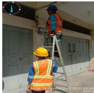
Gambar 2.54 Mengganti percing yang terbakar Sumber: PLN. Rayon Bengkalis PT. Adra Gemilang 2022
