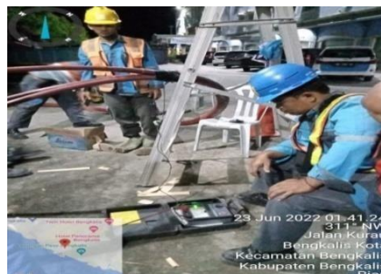
Gambar 2.15 Mengukur tahanan kabel menggunakan alat magger Sumber: PLN. Rayon Bengkalis PT. Adra Gemilang 2022
