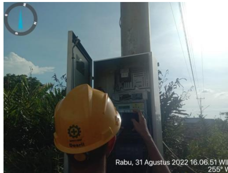
Gambar 2.62 Mengatasi RC ( recloser )
