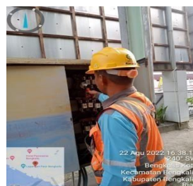
Gambar 2.55 Penggantian NH fuse terbakar Sumber: PLN. Rayon Bengkalis PT. Adra Gemilang 2022
