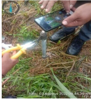
Gambar 2.42 Mengganti fuse link Fco ( fuse cut out ) yang terputus Sumber: PLN. Rayon Bengkulu PT. Adra Gemilang 2022
