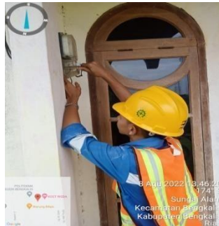
Gambar 2.45 Penggantian MCB ( miniature circuit breaker ) rusak Sumber: PLN. Rayon Bengkalis PT. Adra Gemilang 2022
