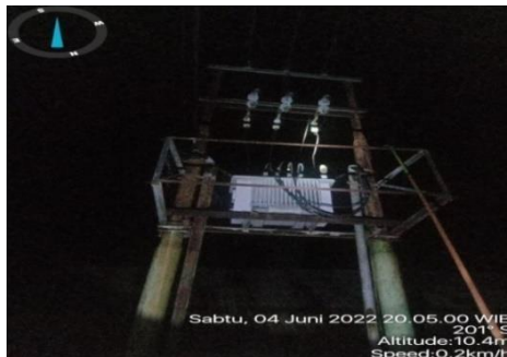
Gambar 2.3 Mengganti FCO (fuse cut out) yang terbakar ( Holder FCO ) Sumber: PLN. Rayon Bengkalis PT. Adra Gemilang 2022
