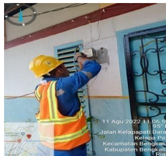
Gambar 2.48 Memperbaiki tapak Kwh yang terbuka Sumber: PLN. Rayon Bengkalis PT. Adra Gemilang 2022
