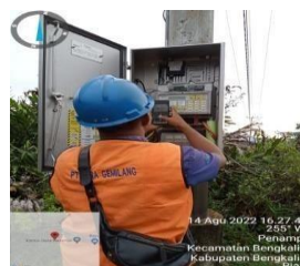
Gambar 2.49 Mengatasi Rc ( recloser ) trip Sumber: PLN. Rayon Bengkalis PT. Adra Gemilang 2022
