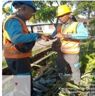
Gambar 2.17 Penyambungan kabel Sr pelanggan yang terputus
