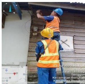
Gambar 2.35 Pengalihan Kwh meter
