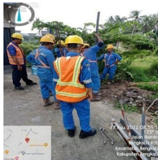
Gambar 2.60 Pemasangan tiang TM ( tegangan menengah ) yang baru
