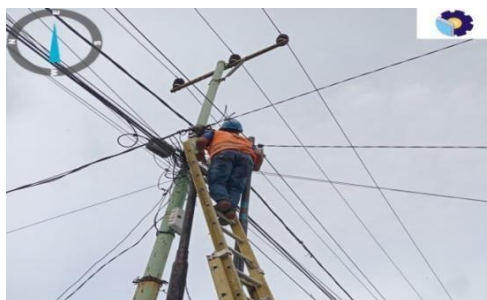
Gambar 2.4 Pemindahan phasa pelanggan yang besar ke kecil Sumber: PLN. Rayon Bengkalis PT. Adra Gemilang 2022
