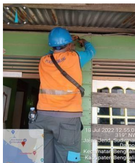
Gambar 2.32 Mengganti Mcb( miniature circuit breaker ) yang terbakar Sumber: PLN. Rayon Bengkulu PT. Adra Gemilang 2022
