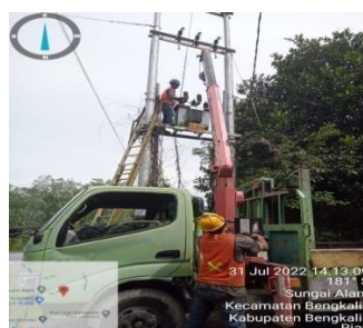
Gambar 2.41 Penggantian trafo yang rusak Sumber: PLN. Rayon Bengkalis PT. Adra Gemilang 2022
