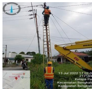
Gambar 2.27 Penarikan kabel SR yang kendor Sumber: PLN. Rayon Bengkalis PT. Adra Gemilang 2022
