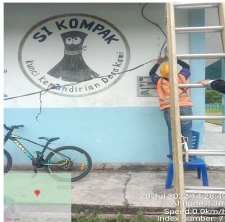
Gambar 2.16 Penanganan Gangguan Kabel SR(Saluran Rumah) (Sumber: Dokumentasi, 2022)
