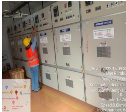
Gambar 2.14 Evident Beban Feeder (Sumber: Dokumentasi, 2022)
