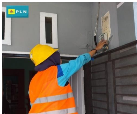
Gambar 2.40 Memasukkan Clear Tamper (CT) (Sumber: Dokumentasi, 2022)
