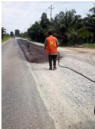
Gambar 3.18 Penuangan base A
