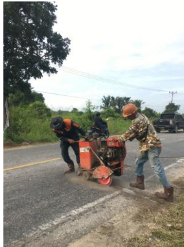
Gambar 3.13 Pemotongan permukaan aspal
