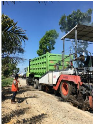
Gambar 4.3 Pengangkutan material campuran aspal
