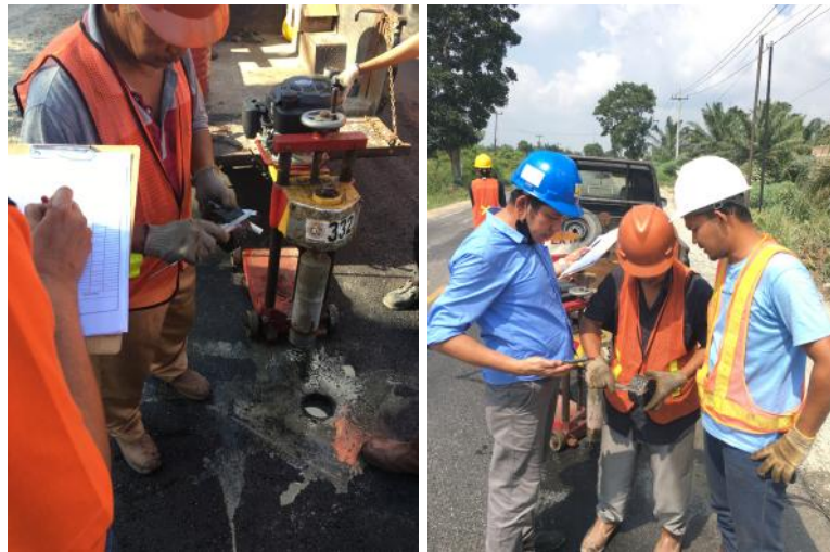
Gambar 3.22 Pengujian Core drill
