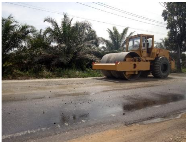
Gambar 3.17 Pemasatan material base A
