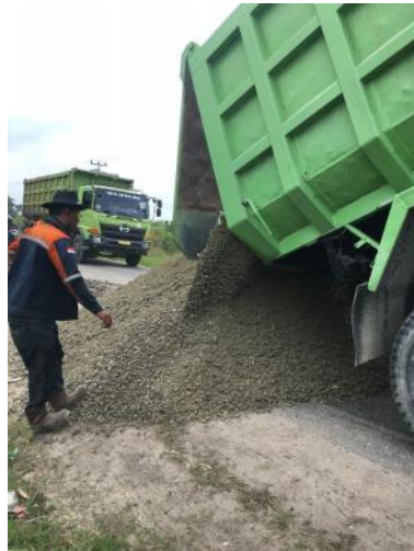
Gambar 3.15 Penuangan base A
