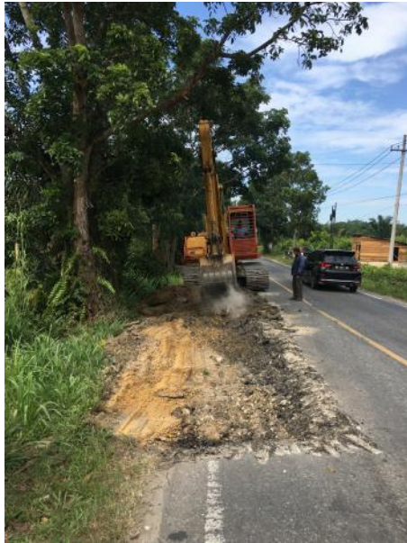
Gambar 3.14 Pembongkaran permukaan aspal
