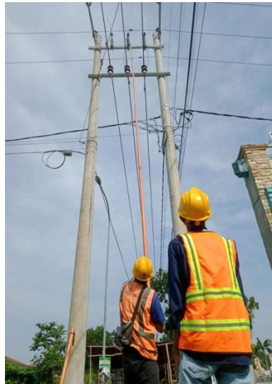
Gambar 2. 44 memperbaiki fco ( fuse cut out ) yang putus ( Sumber :PLN. Rayon bengkalis PT. Adra gemilang.2022)
