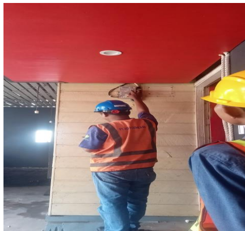
Gambar 2. 30 Memasukkan pulsa ke kwh meter pelanggan ( Sumber :PLN. Rayon bengkalis PT. Adra gemilang.2022)
