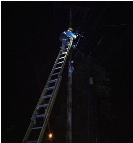
Gambar 2. 13 Mengatasi lost kontak netral pada jtr. (Sumber :PLN. Rayon bengkalis PT. Adra gemilang.2022)
