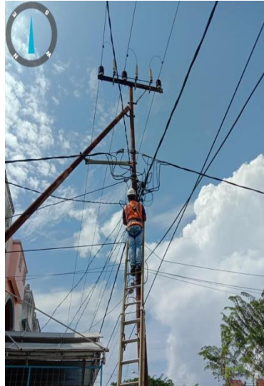
Gambar 2. 69 Memperbaiki kabel SR yang terbakar ( Sumber :PLN. Rayon bengkalis PT. Adra gemilang.2022)
