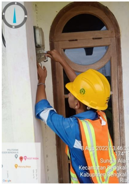
Gambar 2. 40 Mengganti mcb yang banting atau trip ( Sumber :PLN. Rayon bengkalis PT. Adra gemilang.2022)
