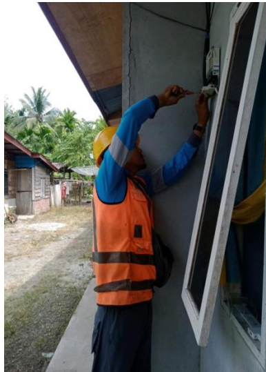
Gambar 2. 22 Pemindahan kwh meter pelanggan ( Sumber :PLN. Rayon bengkalis PT. Adra gemilang. 2022)
