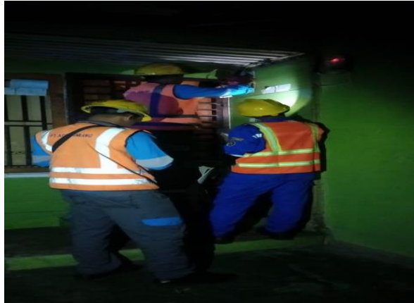
Gambar 2. 62 Memperbaiki instalasi dirumah pelanggan ( Sumber :PLN. Rayon bengkalis PT. Adra gemilang.2022)
