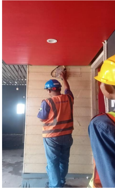
Gambar 2. 66 Memasukkan pulsa kekwh meter pelanggan ( Sumber :PLN. Rayon bengkalis PT. Adra gemilang.2022)
