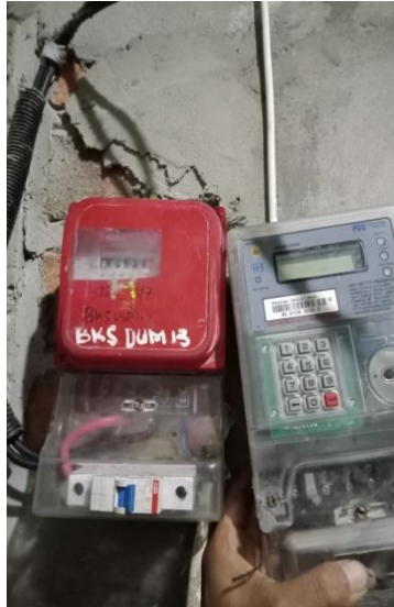
Gambar 2. 41 menganti kwh meter sementara (dumi) ( Sumber :PLN. Rayon bengkalis PT. Adra gemilang.2022)
