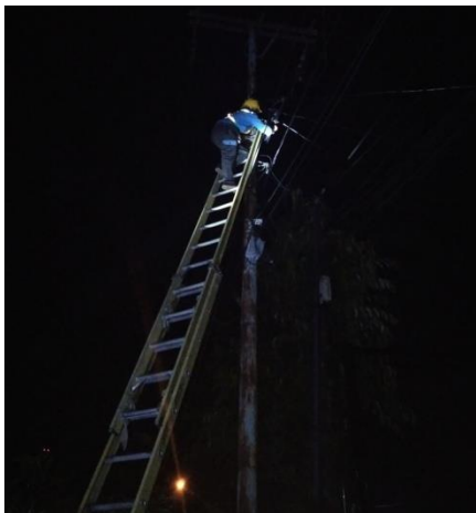
Gambar 2. 61 Mengatasi lost kontak netral pada jtr. (Sumber :PLN. Rayon bengkalis PT. Adra gemilang.2022)
