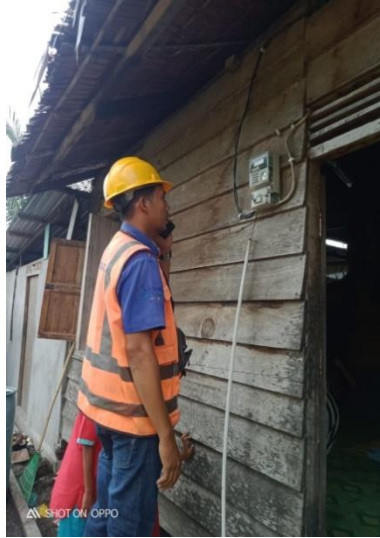
Gambar 2. 18Pengecekan kwh meter satu rumah padam ( Sumber :PLN. Rayon bengkalis PT. Adra gemilang.2022)
