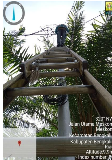
Gambar 2. 20 mengatasi tiang jtm los kontak netral ( Sumber :PLN. Rayon bengkalis PT. Adra gemilang.2022)
