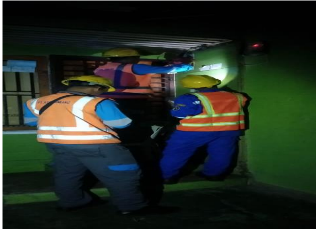
Gambar 2. 14 Memperbaiki instalasi dirumah pelanggan ( Sumber :PLN. Rayon bengkalis PT. Adra gemilang.2022)
