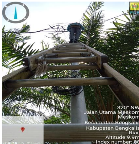
Gambar 2. 34 memperbaiki lost kontak ( Sumber :PLN. Rayon bengkalis PT. Adra gemilang.2022)
