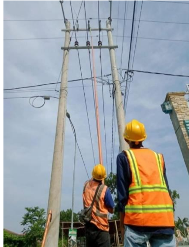
Gambar 2. 9 memperbaiki fco ( fuse cut out ) yang putus ( Sumber :PLN. Rayon bengkalis PT. Adra gemilang.2022)
