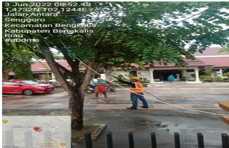
Gambar 2. 5 Melakukan pemangkasan atau pembersihan jaringan tegangan menengah (JTM) ( Sumber : Dokumentasi.2022)
