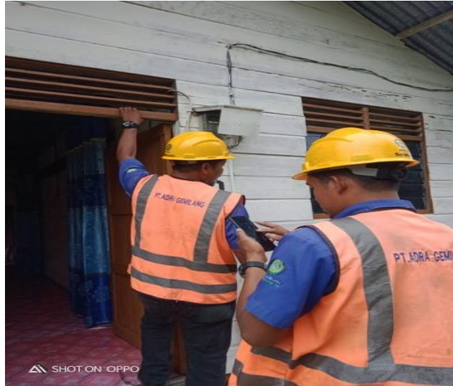
Gambar 2. 11 Memasukkan code CT (clear temper) ke kwh meter ( Sumber :PLN. Rayon bengkalis PT. Adra gemilang.2022)
