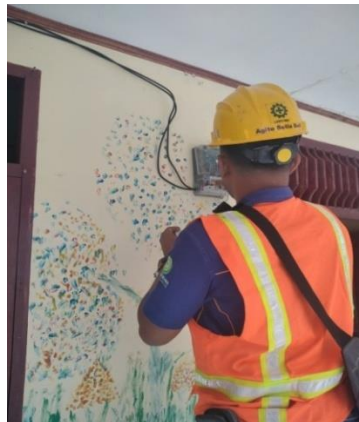
Gambar 2. 10 Mengatasi gangguan kwh meter periksa di tempat Pelanggan ( Sumber :PLN. Rayon bengkalis PT. Adra gemilang.2022)
