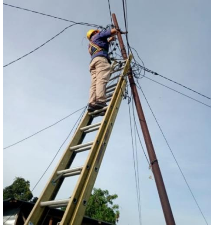
Gambar 2.64 Mengunci piringan di jtr ( Sumber :PLN. Rayon bengkalis PT. Adra gemilan.2022)
