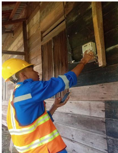
Gambar 2. 47 Kwh meter tidak bisa diisi pulsa ( Sumber :PLN. Rayon bengkalis PT. Adra gemilang.2022)
