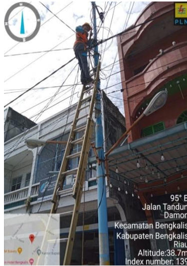
Gambar 2. 48 penyambungan kabel SR ke SKU ( Sumber :PLN. Rayon bengkalis PT. Adra gemilang.2022)
