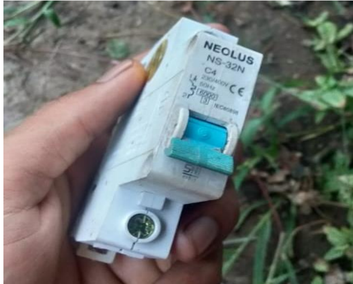
Gambar 2. 7 Mengganti MSB Yang Rusak ( Sumber : Dokumentasi, 2022)
