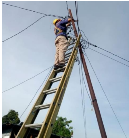
Gambar 2. 28 Mengunci piercing di jtr ( Sumber :PLN. Rayon bengkalis PT. Adra gemilan.2022)
