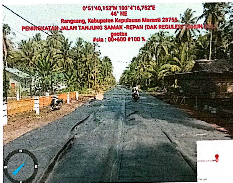
Gambar 3.2 Pemasangan Geotextiel Woven
