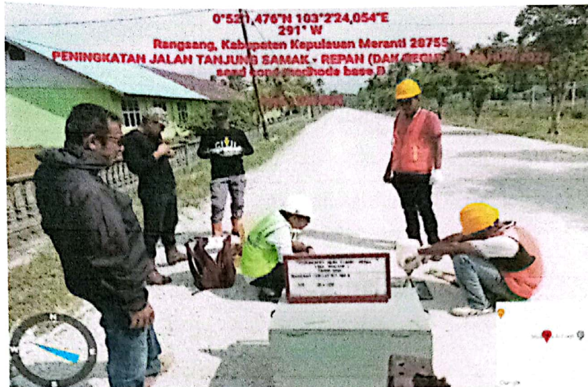
Gambar 4.9 pekerjaan pengujian send cone
