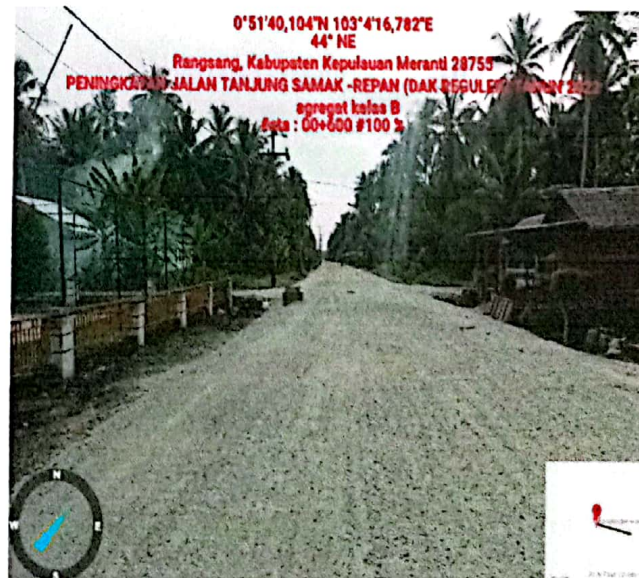
Gambar 3.4 Pekerjaan Agregat Kelas B
