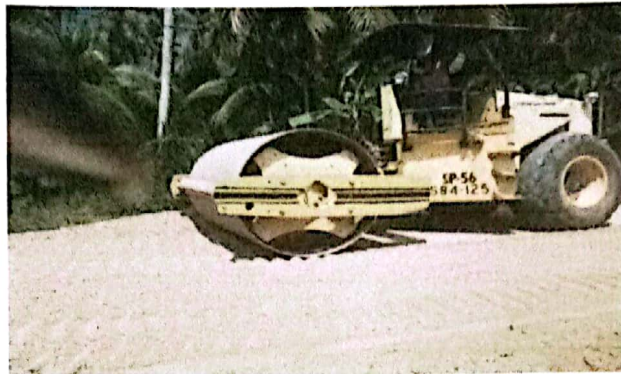
Gambar 4.8 Pemasatan Base B oleh Alat Berat Vibratory Roller
