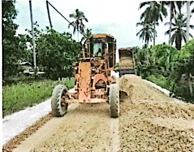
Gambar 3.5 Pekerjaan Agregat Kelas A
