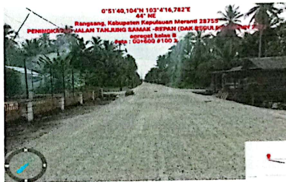
Gambar 4.6 Pekerjaan Penyiapan Badan Jalan
