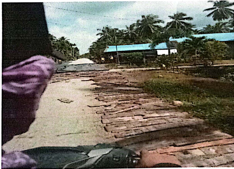
Gambar 3.1 Pekerjaan Penyusunan Gambangan (Uyung Sagu)
