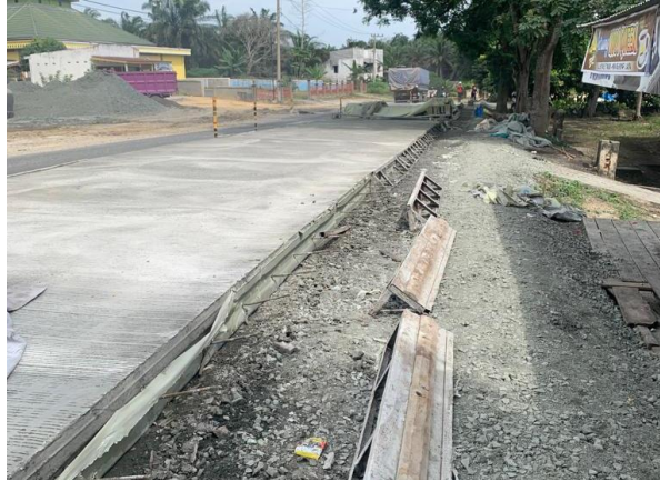
Gambar 4.15. Pembongkaran Bekisting
