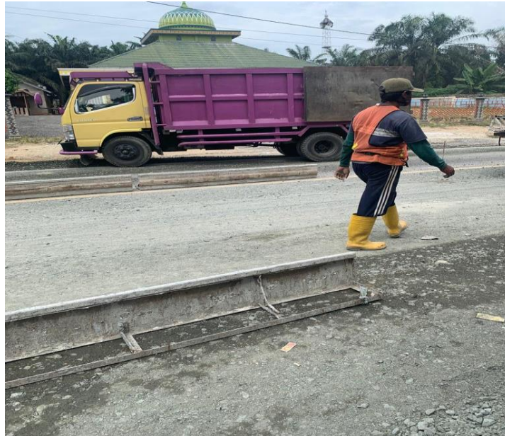
Gambar 3.11 Pekerjaan Pemasangan Bekisting Badan Jalan
