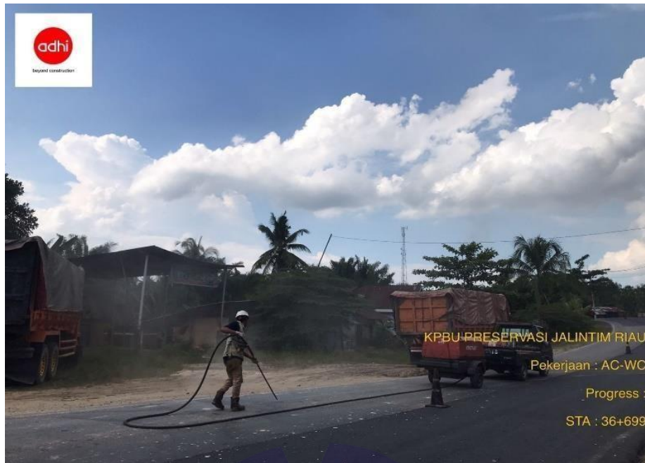
Gambar 3.5 Pembersihan lahan menggunakan Compressor Sumber : Dokumentasi Kerja Praktik, 2022
