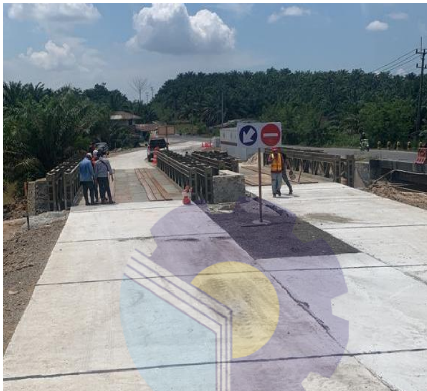
Gambar 3.17 Pekerjaan Rekonstruksi Jembatan Kerinci Kecil
