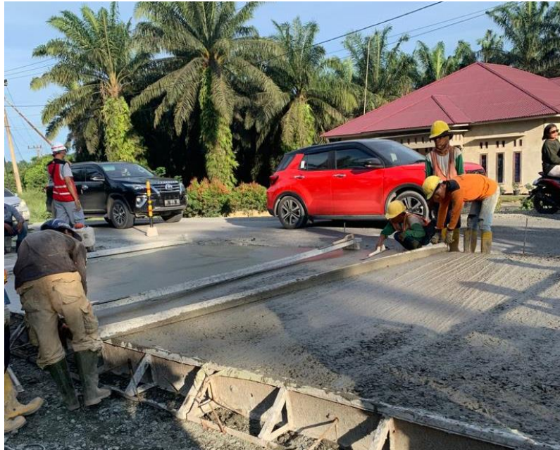
Gambar 4.13. Perataan Menggunakan Papan Perata
