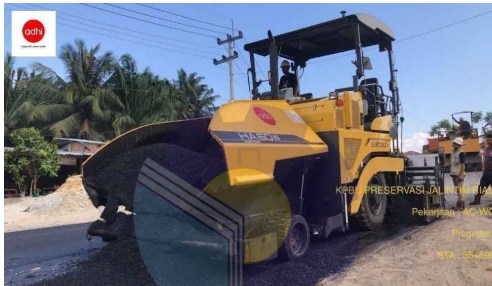
Gambar 3.7 Pekerjaan Penghamparan AC-WC
