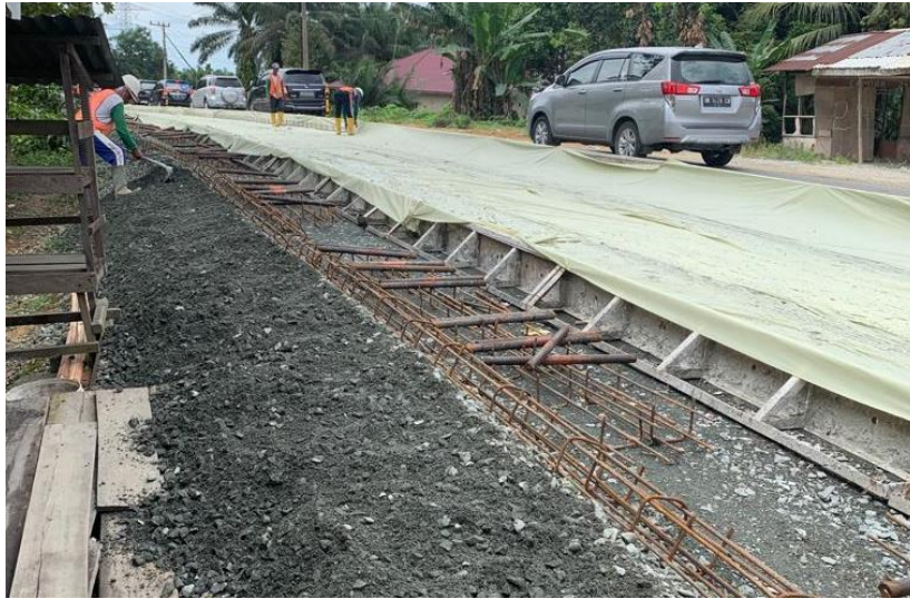
Gambar 4.7. Pemasangan Terpal Plastik
