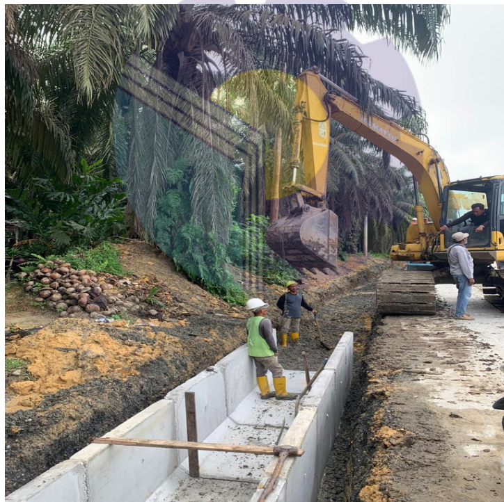
Gambar 3.16 Pekerjaan Saluran U-Ditch
