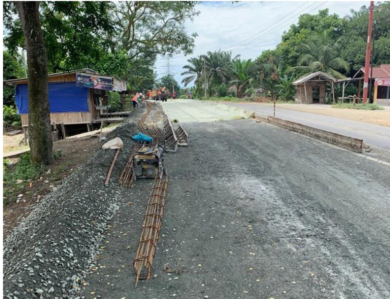
Gambar 4.6. Pemasangan Bekisting
