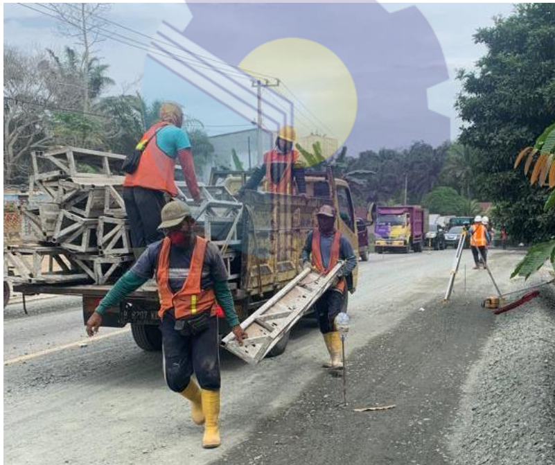
Gambar 4.5. Pemasangan Bekisting Sumber : Dokumen Kerja Praktek, 2022
