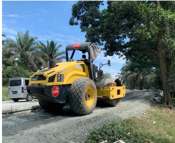
Gambar 4.4. Pemasangan Base
