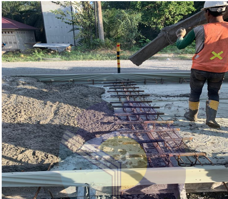
Gambar 4.10. Penghamparan Campuran Beton
