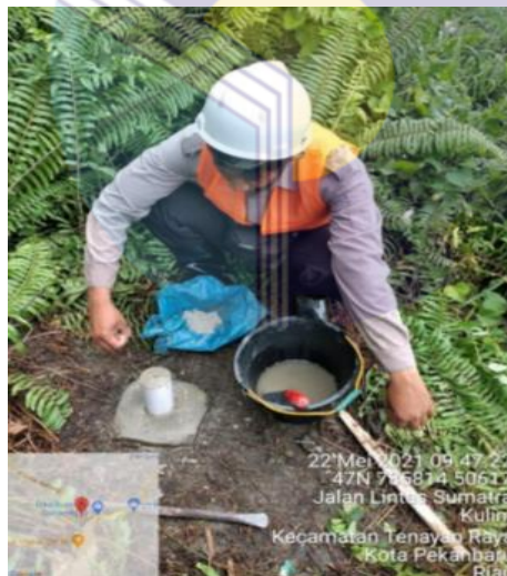
Gambar 4.1. Pembentukan Titik BM Pengukuran
