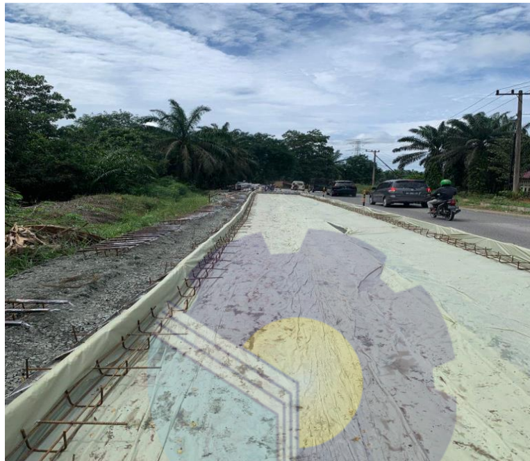
Gambar 3.13 Pekerjaan Pemasangan Terpal
