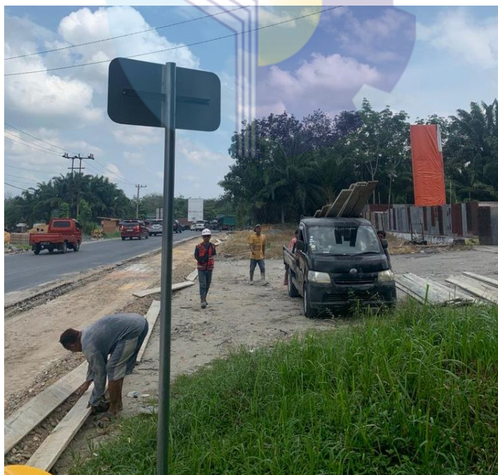
Gambar 3.12 Pekerjaan Pemasangan Bekisting Bahu Jalan
