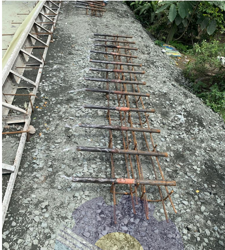
Gambar 3.14 Pekerjaan Pemasangan Tulangan Dowel
