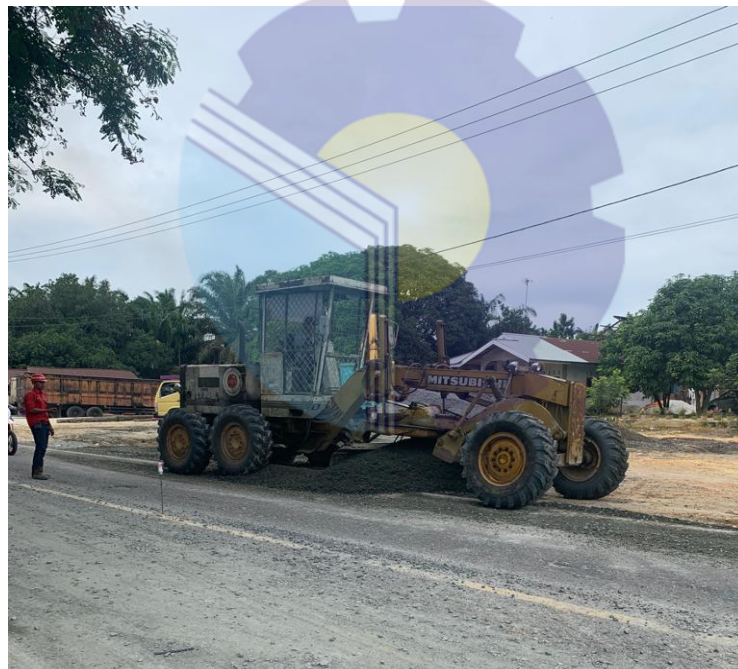
Gambar 3.9 Pekerjaan Penimbunan base
