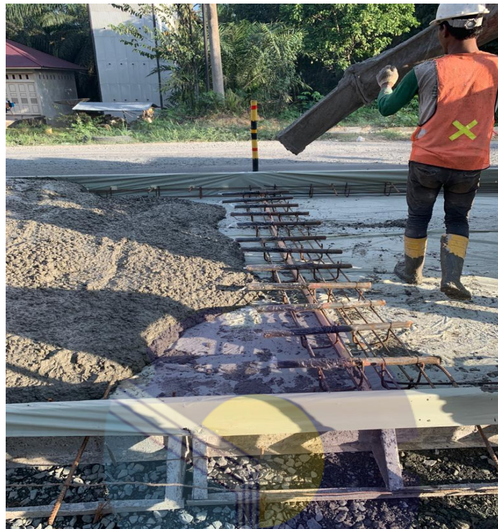
Gambar 3.15 Pekerjaan Pengecoran Beton
