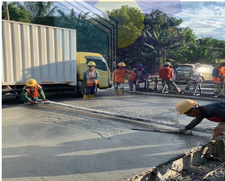
Gambar 4.14. Perataan Menggunakan Roskam Kayu
