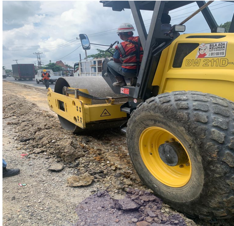
Gambar 3.10 Pekerjaan Pematatan Bahu Jalan
