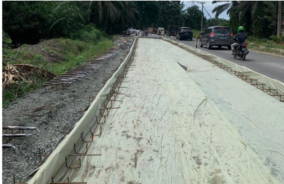
Gambar 4.9. Pemasangan Tulangan Tie Bar
