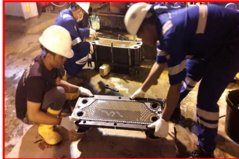
Gambar 4. 8 Mengeluarkan plat heat exchanger
