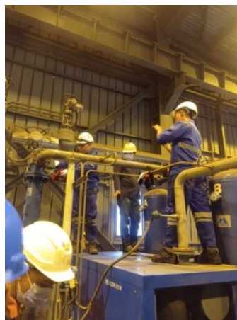
Gambar 3. 3 Preventive Maintenance di Area Kompresor (Sumber : Dokumentasi Pribadi)
