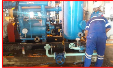
Gambar 4. 6 Melepaskan sight glass pada line Open cycle cooling water (Sumber : Dokumentasi Pribadi)
