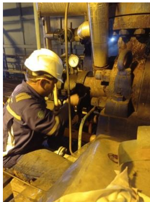
Gambar 3. 1 Preventive Maintenance di Area BFP (Sumber : Dokumentasi Pribadi)
