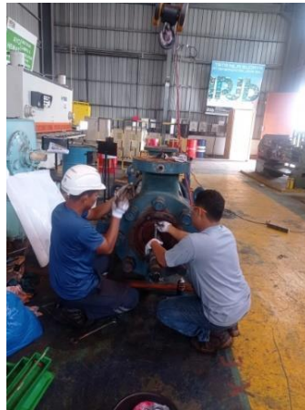
Gambar 3. 5 Pembongkaran Boiler Feed Water Pump ex 1A (Sumber : Dokumentasi Pribadi)
