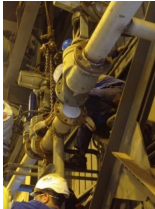
Gambar 3. 4 Penggantian spiral wound gasket pada Kompresor (Sumber : Dokumentasi Pribadi)
