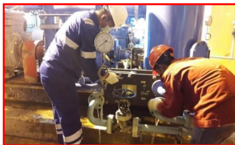
Gambar 4. 5 Melepaskan Baut Pengikat pada Flange Heat Exvhaner (Sumber : Dokumentasi Pribadi)
