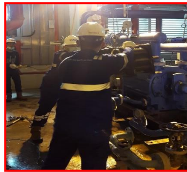
Gambar 4. 7 Melihat Kondisi Heat Exchanger (Sumber : Dokumentasi Pribadi)
