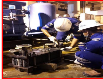
Gambar 4. 12 Mengencangkan Baut Perapat Pada Cover Heat Exchanger (Sumber : Dokumentasi Pribadi)
