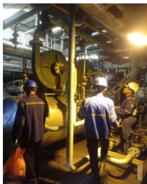
Gambar 2. 4 Preventive Maintenance pada Gland Steam Condensor (Sumber : Dokumentasi Pribadi)
