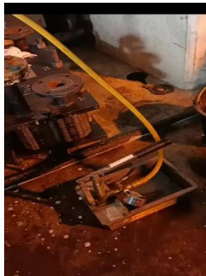
Gambar 4. 13 Leak Test (Sumber : Dokumentasi Pribadi)
