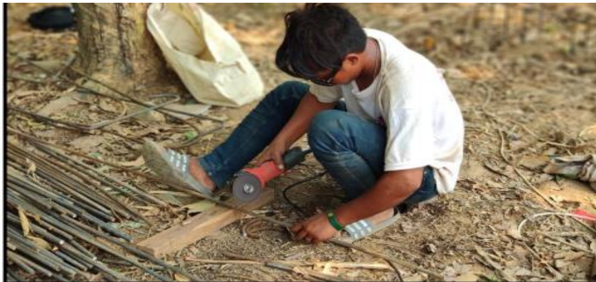
Gambar 4.8 Pemotongan Baja Tulangan
