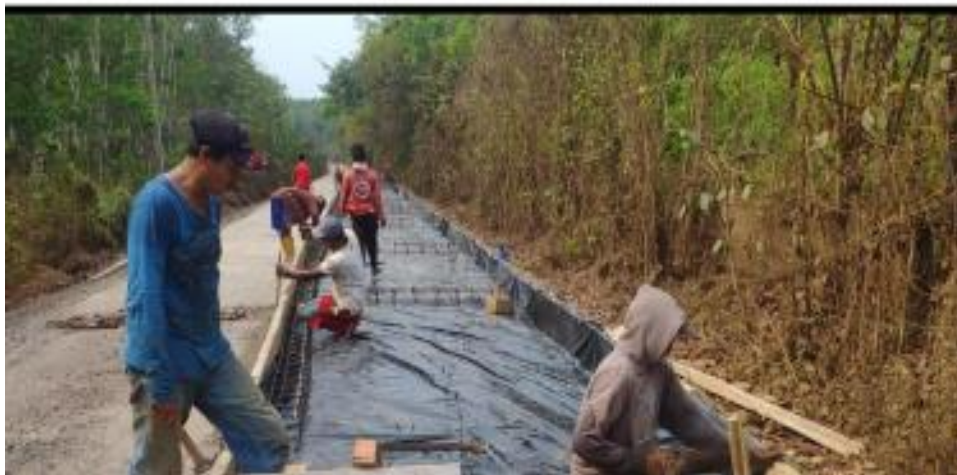
Gambar 4.9 Pemasangan Bekisting acuan diatas LC 10
