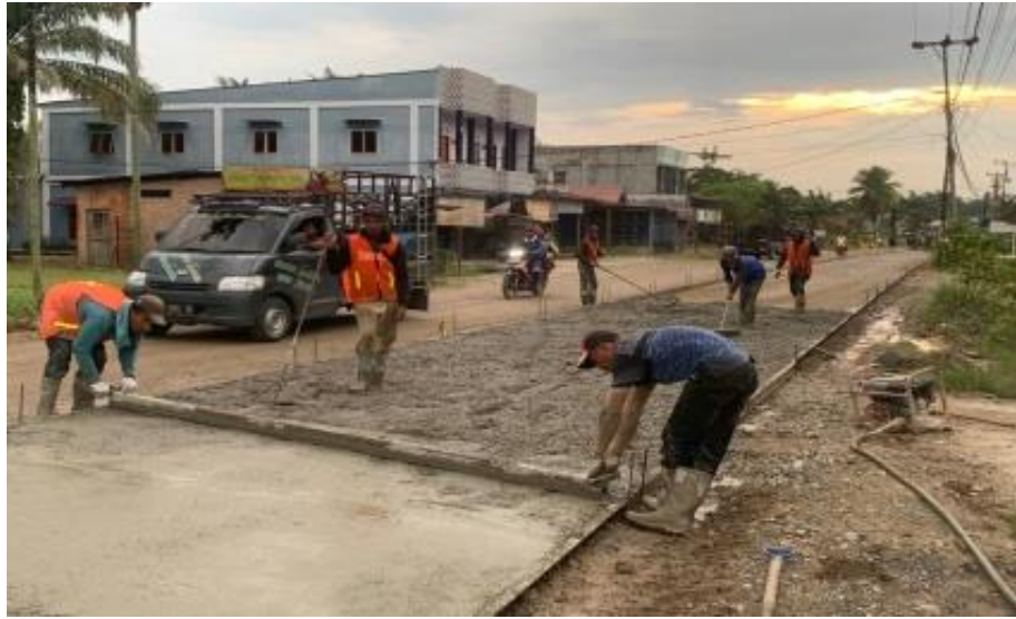
Gambar 4.7 Perataan Permukaan Beton LC 10
