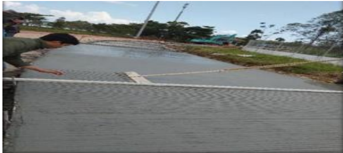
Gambar 4.12 Penggarisan Permukaan Beton
