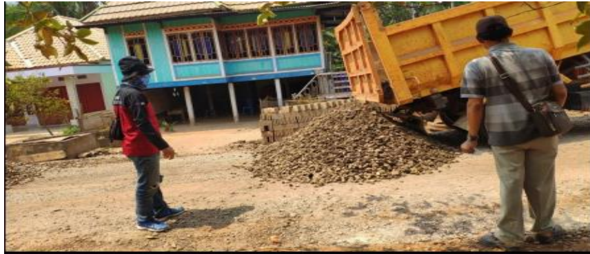
Gambar 4.1 Penghamparan Material Agregat Kelas
