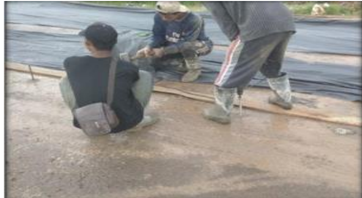
Gambar 4.4 Pemasangan Bekisting Lantai Kerja
