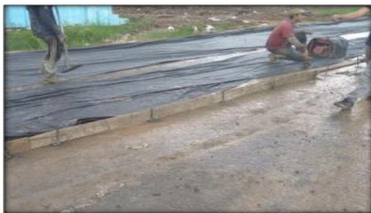
Gambar 4.5 Pemasangan Plastic Sheet
