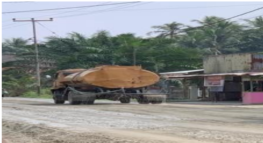
Gambar 4.2 Proses Penyiraman Air
