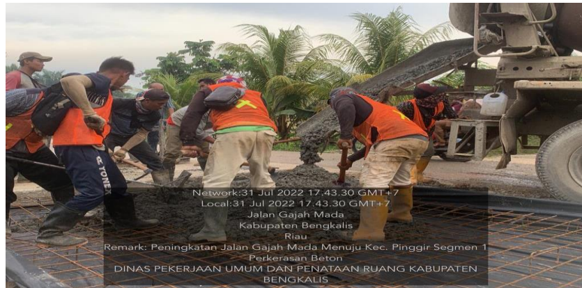
Gambar 4.10 Pekerjaan Pengecoran Beton fs' 45 Mpa
