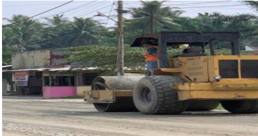
Gambar 4.3 Memadatkan Agregat Kelas B
