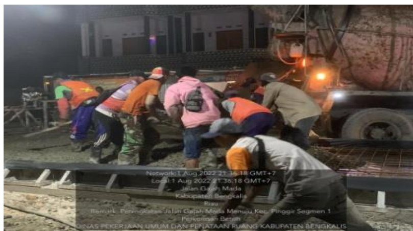
Gambar 4.11 Perataan Permukaan Beton Dengan Menggunakan Papan
