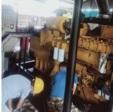
Gambar 2.23 Kegiatan pengantian filter oli pada unit lima (Sumber: PT. Megapower Makmur Tbk, 2022)
