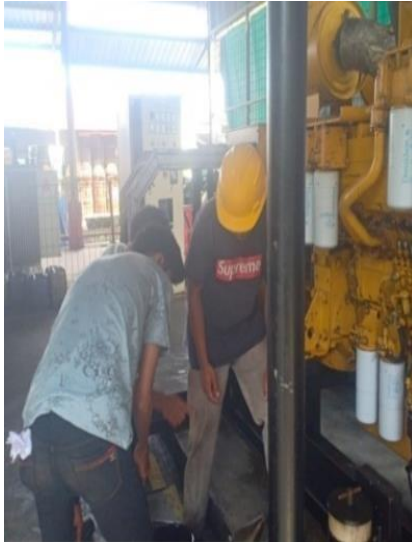
Gambar 2.41 Kegiatan penambahan oli pada unit dua (Sumber: PT. Megapower Makmur Tbk, 2022)
