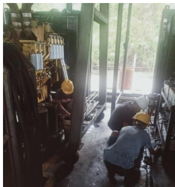
Gambar 2.34 Kegiatan membersihkan limbah oli dibawah mesin (Sumber: PT. Megapower Makmur Tbk, 2022)
