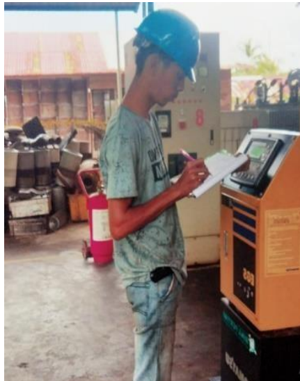
Gambar 2.22 Kegiatan monitoring KWH setiap jamnya (Sumber: PT. Megapower Makmur Tbk, 2022)
