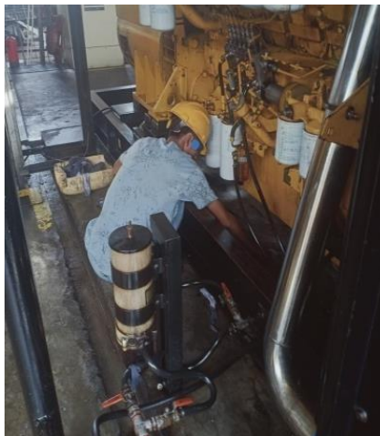
Gambar 2.2 Kegiatan membersihkan limbah oli di bawah mesin (Sumber: PT. Megapower Makmur Tbk, 2022)
