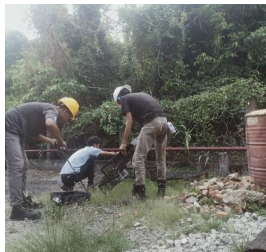
Gambar 2.28 Kegiatan membersihkan cover radiator unit tiga (Sumber: PT. Megapower Makmur Tbk, 2022)
