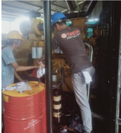
Gambar 2.16 Kegiatan penambahan oli pada unit tujuh (Sumber: PT. Megapower Makmur Tbk, 2022)
