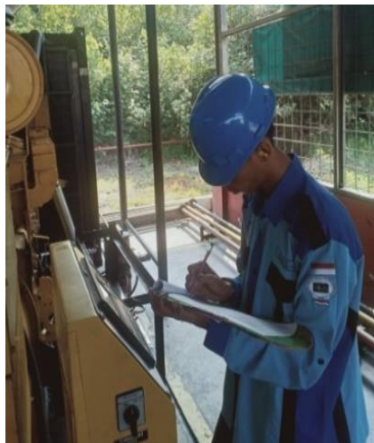
Gambar 2.26 Kegiatan monitoring KWH setiap jamnya (Sumber: PT. Megapower Makmur Tbk, 2022)
