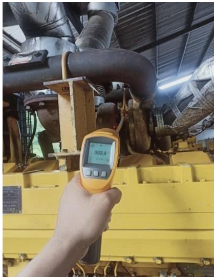
Gambar 2.32 Kegiatan monitoring KWH setiap jamnya (Sumber: PT. Megapower Makmur Tbk, 2022)
