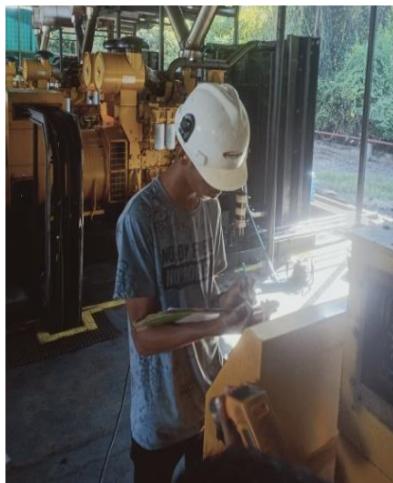
Gambar 2.7 Kegiatan monitoring KWH setiap jamnya (Sumber: PT. Megapower Makmur Tbk, 2022)
