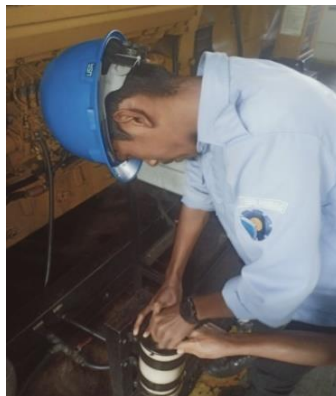
Gambar 2.39 Kegiatan mengganti filter oli (Sumber: PT. Megapower Makmur Tbk, 2022)
