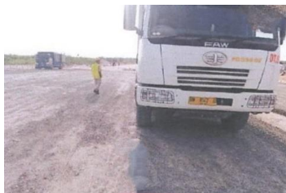
Gambar 4.18 Dokumentasi Persiapan Dump Truck Yang Telah Diisi Material
