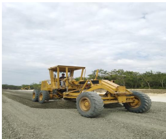
Gambar 4.7 Penghamparan Base A oleh Alat Berat Motor Grader
