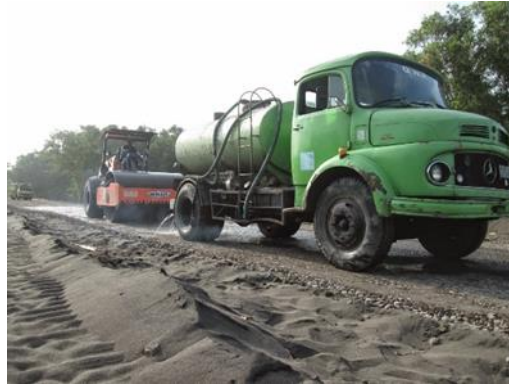
Gambar 4.9 Pekerjaan Penyiraman Base
