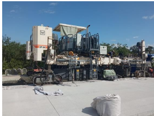
Gambar 3.10 Pekerjaan Rigid
