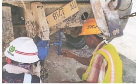
Gambar 4.11 Dokumentasi Uji CBR Lapangan
