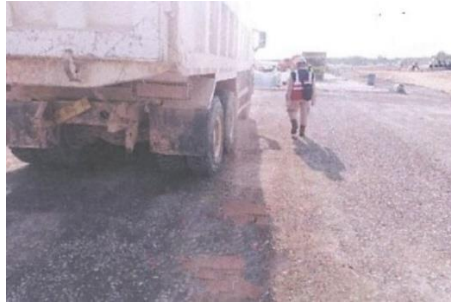
Gambar 4.19 Dokumetasi Dump Truck Melakukan Tes Profrolling
