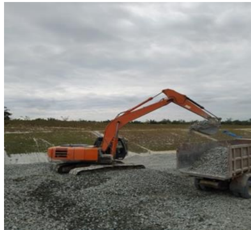
Gambar 4.6 Pengangkutan Base A oleh Alat Berat Ekskavator
