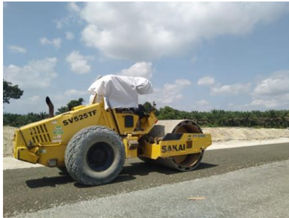
Gambar 4.10 Pematatan Base B Oleh Alat Berat Vibratory Roller
