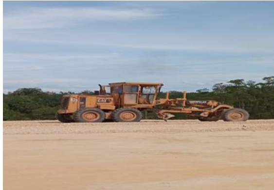
Gambar 4.8 Pekerjaan Penyiapan Badan Jalan
