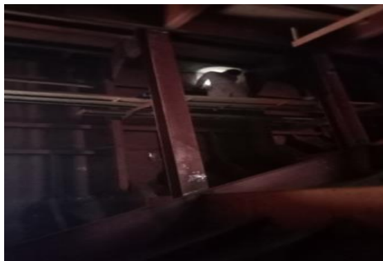
Gambar 2.64 Inspection Di Area Tangki
