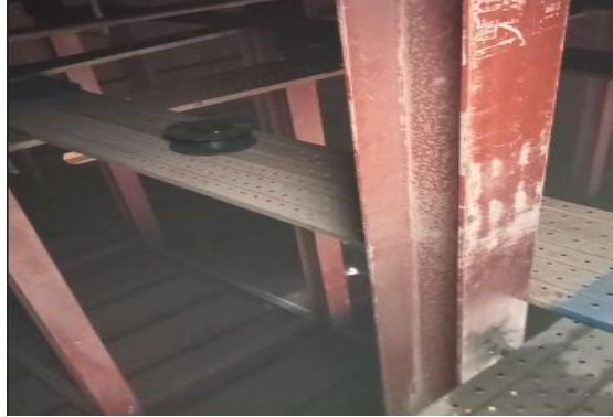
Gambar 2.65 Inspection di Area Tangki
