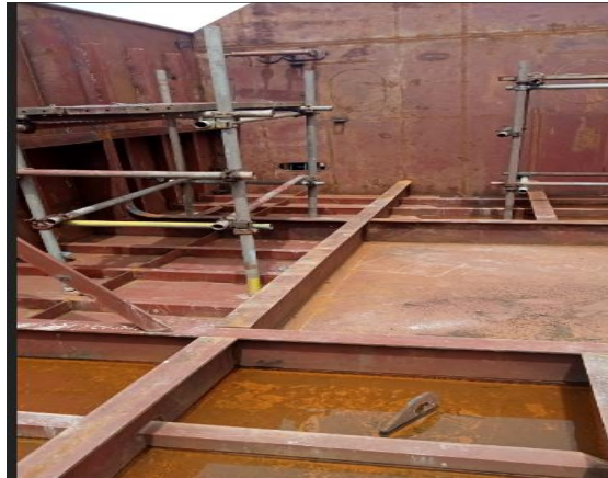
Gambar 2.47 Pemasangan Profil dan Material
