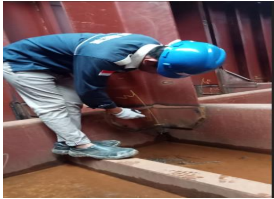
Gambar 2.63 Inspection Di Area Tangki
