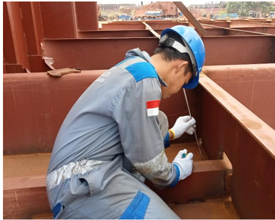
Gambar 2.60 Inspection Di Area Bottom Kapal Barge
