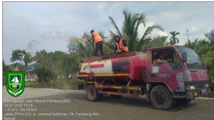
gambar 3.18 penyiraman agregat kelas A Sumber: dokumentasi lapangan, 2022
