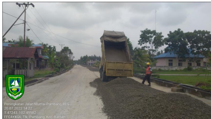
gambar 3.15 mobilisasi agregat kelas A
