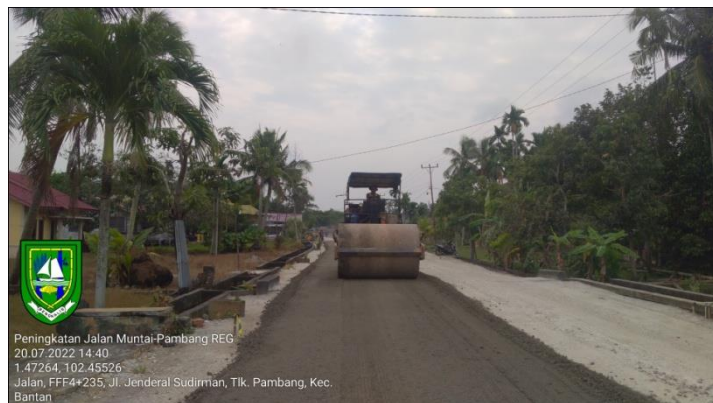
gambar 3.17 pemadatan agregat kelas A
