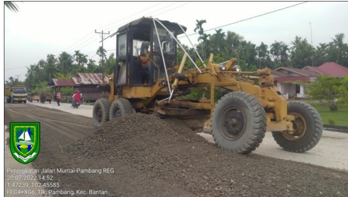
gambar 3.16 penghamparan agregat kelas A
