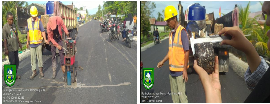
gambar 3.13 pengujian core drill
