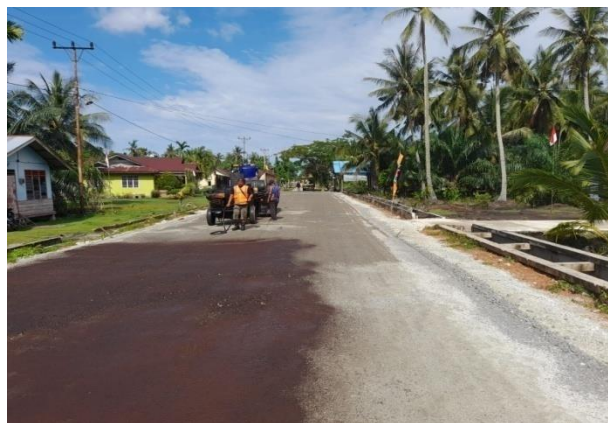
gambar 3.10 penyiraman prime coat
