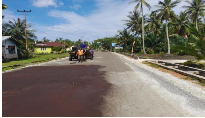
Gambar 3.21 penyemprotan prime coat
