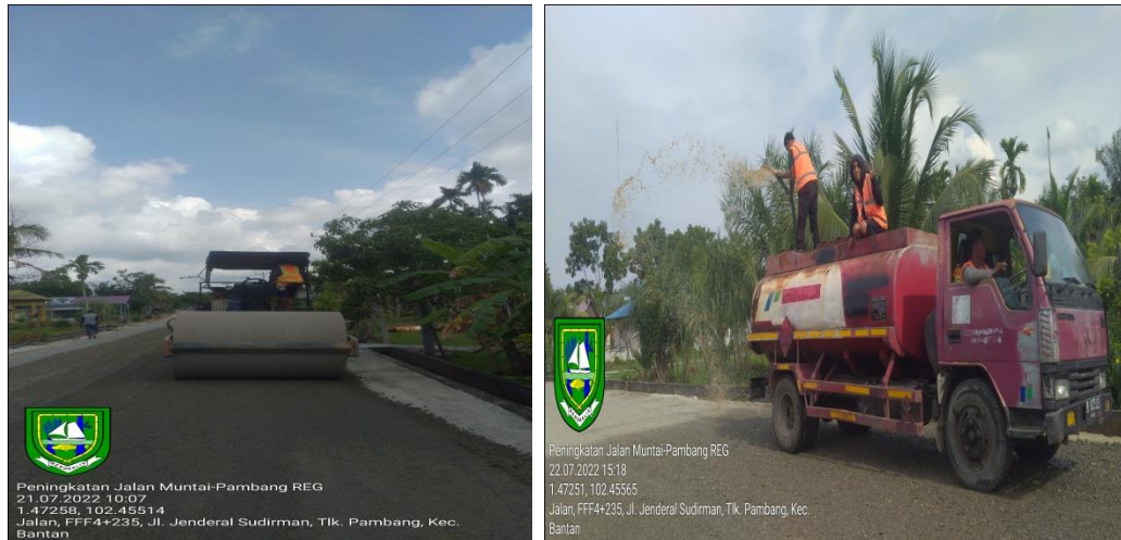
gambar 3.7 pemadatan dan penyiraman base A
