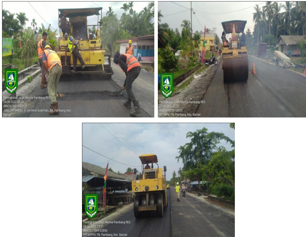
gambar 3.12 penghamparan, pematatan awal dan pematatan akhir aspal
