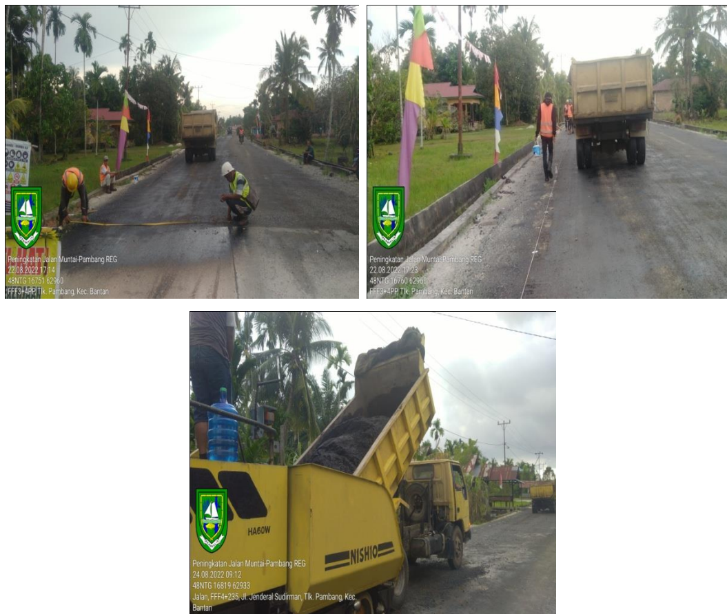
gambar 3.11 pengukuran, pematokan/acuan dan mobilisasi AC-BC
