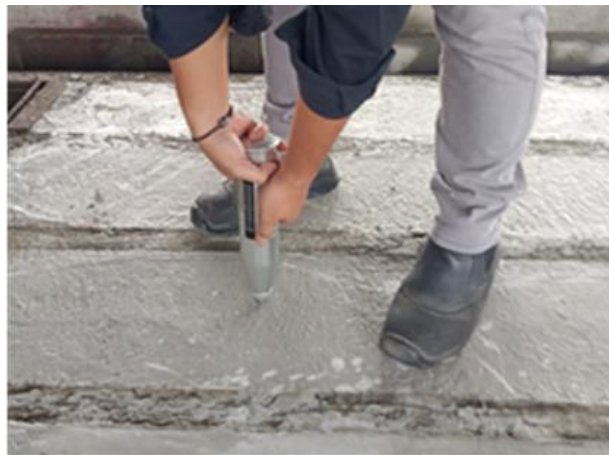
Gambar 3.14 Pengujian hammer test square pile Sumber: Dokumentasi KP, Tahun 2022
