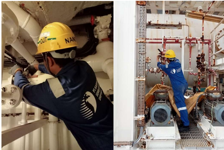
Gambar 2.44 Pemasangan tag number pada pipa di main deck dan engine room
