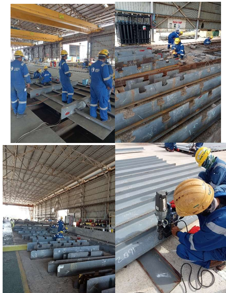
Gambar 2.46 Proses fabrikasi di area kerja yang telah ditentukan
