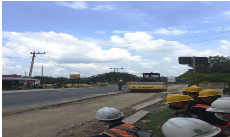
Gambar 3.9 Pekerjaan Pematatan
