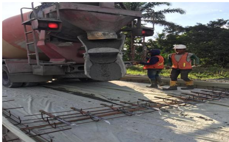
Gambar 3.10 Pekerjaan Penghamparan Concrete
