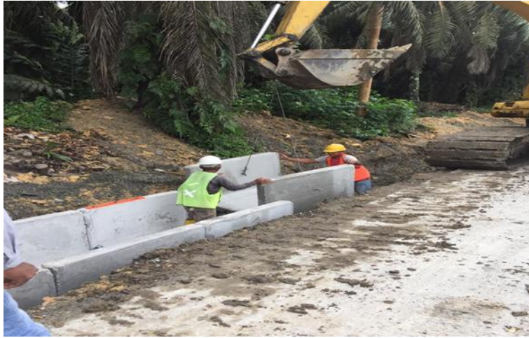
Gambar 3.14 Pekerjaan Pemasangan U-ditch
