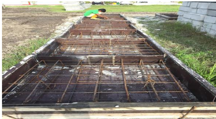
Gambar 3.12 Pekerjaan Pembesian U-ditch
