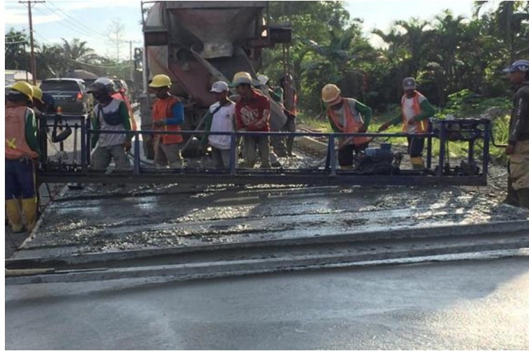
Gambar 3.11 Pekerjaan Pemerataan Finishing
