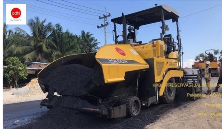
Gambar 3.7 Pekerjaan Penghamparan AC-WC
