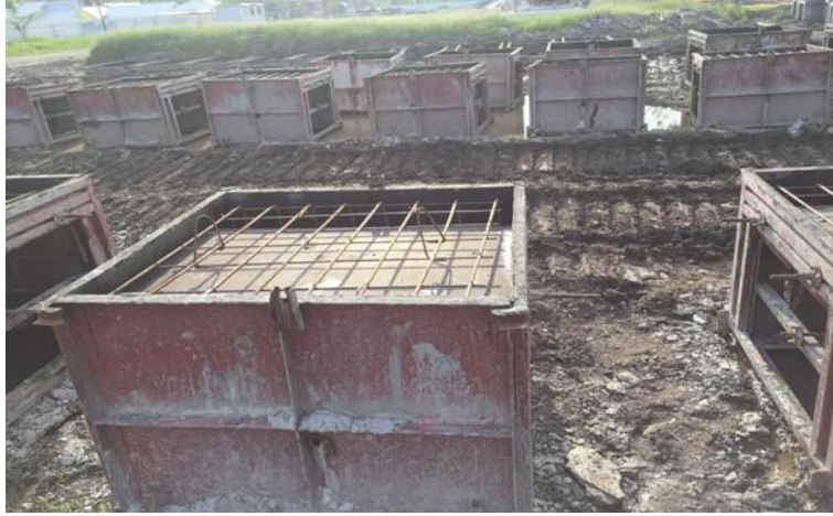
Gambar 3.13 Pekerjaann Pengecoran U-ditch
