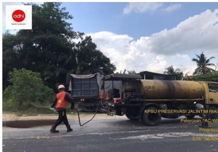
Gambar 3.6 Pekerjaan Tackout
