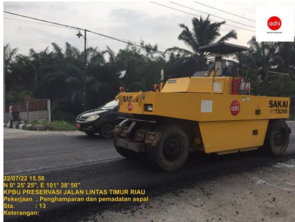
Gambar 4.8 Pepadatan Dengan Menggunakan Pneumatic Tyre Roller
