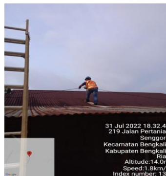
Gambar 2.40 Menyambung kabel sr yang putus (Sumber: PT. Adra Gemilang 2022)
