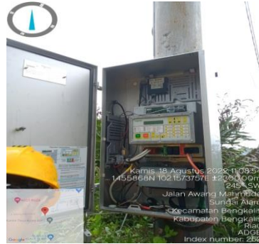
Gambar 2.53 Mengcloskan RC yang trip (Sumber: PT. Adra Gemilang 2022)
