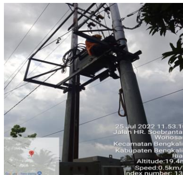
Gambar 2.38 Pemasangan kabel grounding (Sumber: PT. Adra Gemilang 2022)
