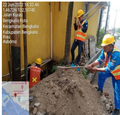
Gambar 2.16 Penggalian tanah untuk kedudukan kabel SKTM (Sumber: PT. Adra Gemilang 2022)
