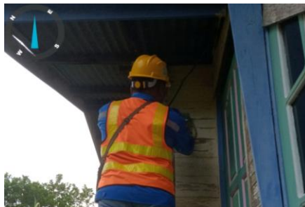
Gambar 3.11 Memasukkan Kode CT( clear tamper ) (Sumber: PT. Adra Gemilang 2022)
