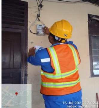
Gambar 3.9 Mengecek gangguan periksa (Sumber: PT. Adra Gemilang 2022)
