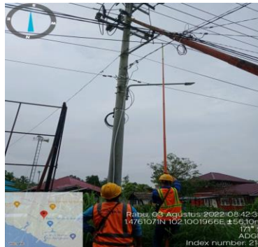
Gambar 2.43 Penggantian fuse link yang putus (Sumber: PT. Adra Gemilang 2022)
