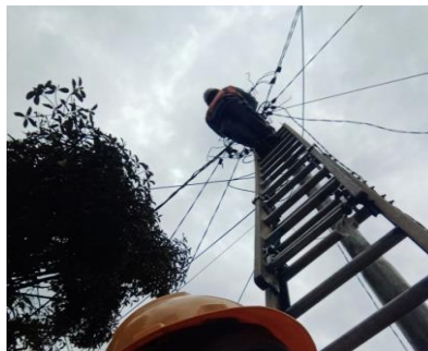
Gambar 2.23 Penyambungan kabel sr) (Sumber: PT. Adra Gemilang 2022)
