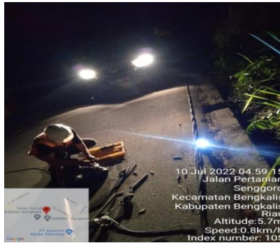
Gambar 2.29 Penyambungan Kabel Skutr (Sumber: PT. Adra Gemilang 2022)
