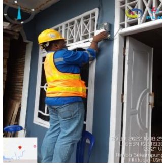
Gambar 2.35 Mengganti MCB( Miniature Circuit Breaker ) ( Sumber: PT. Adra Gemilang 2022 )
