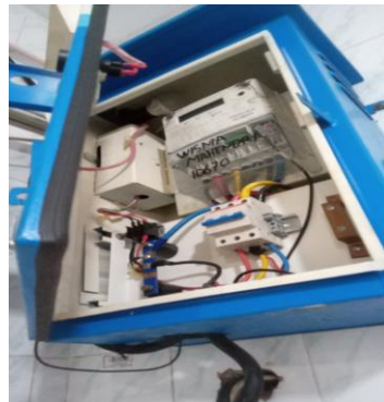
Gambar 2.41 Pemadaman bergilir (Sumber: PT. Adra Gemilang 2022)
