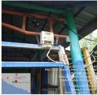
Gambar 2.48 Mengganti MCB ( Miniature Circuit Breaker ) (Sumber: PT. Adra Gemilang 2022)
