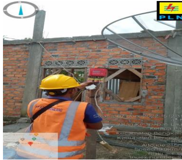
Gambar 2.5 (Menganti kwh meter sementara di rumah pelanggan) (Sumber: PT. Adra Gemilang 2022)
