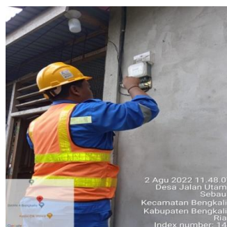
Gambar 2.42 Mengganti MCB( Miniature Circuit Breaker ) (Sumber: PT. Adra Gemilang 2022)
