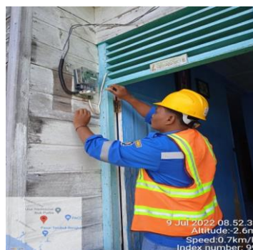
Gambar 2.28 Mengganti MCB ( Miniature Circuit Breaker ) (Sumber: PT. Adra Gemilang 2022)
