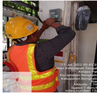
Gambar 2.33 Mengganti MCB(Miniature Circuit Breaker) (Sumber: PT. Adra Gemilang 2022)
