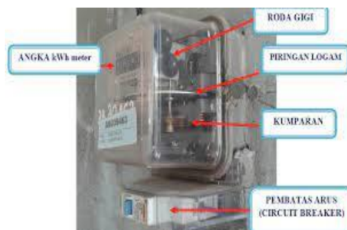
Gambar 3.2 Bagian KWH Meter Analog (Sumber. Internet 2022 )
