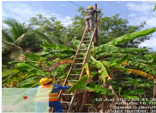
Gambar 2.8 Memindah kan kabel SR (Sumber: PT. Adra Gemilang 2022)
