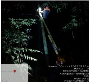
Gambar 2.22 Mengatasi gangguan los kontak (Sumber: PT. Adra Gemilang 2022)
