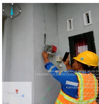
Gambar 2.58 Penggantian kWh Meter Sementara / Meter Gami (Sumber: PT. Adra Gemilang 2022)
