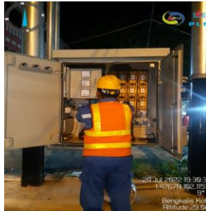
Gambar 2.37 Pemadaman bergilir (Sumber: PT. Adra Gemilang 2022)
