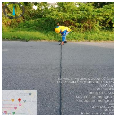
Gambar 2.49 Penyambungan kabel SR yang putus (Sumber: PT. Adra Gemilang 2022)
