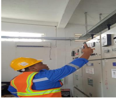
Gambar 2.15 Melakukan pengecekan beban feeder (Sumber: PT. Adra Gemilang 2022)
