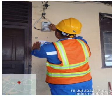
Gambar 2.31 Memasukan kode kct di rumah pelanggan (Sumber: PT. Adra Gemilang 2022)
