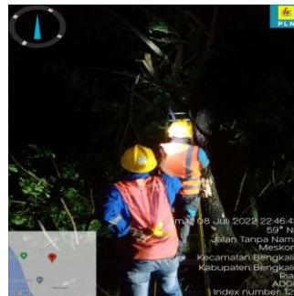
Gambar 2.27 Perbaikan kabel JTM yang tertimpa pohon (Sumber: PT. Adra Gemilang 2022)
