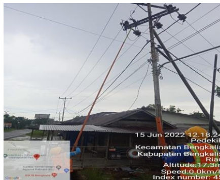
Gambar 2.11 Penggantian fuse link yang putus (Sumber: PT. Adra Gemilang 2022)
