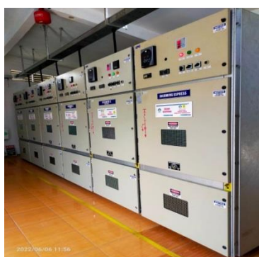
Gambar 2.59 Pengecekan beban federer (Sumber: PT. Adra Gemilang 2022)
