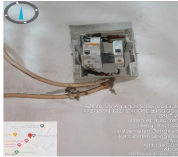
Gambar 2.55 Mengganti MCB milik pelanggan yang terbakar (Sumber: PT. Adra Gemilang 2022)
