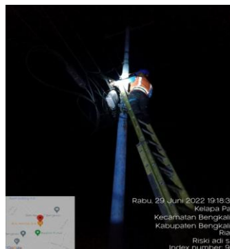
Gambar 2.21 Mengatasi gangguan los kontak (Sumber: PT. Adra Gemilang 2022)
