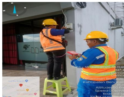
Gambar 2.14 Mengganti kwh meter dami (Sumber: PT. Adra Gemilang 2022)
