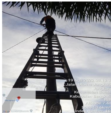
Gambar 2.54 Menggatasi kabel SR yang kendor (Sumber: PT. Adra Gemilang 2022)
