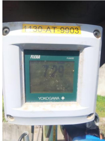
Gambar 2. 6 perawatan dan kalibrasi liquid analyzer
