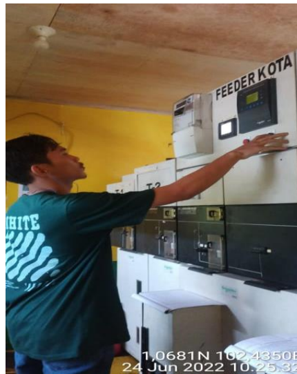
Gmbar 2.3 Penormalan engine dan feeder saat terjadi Trip dan BO
