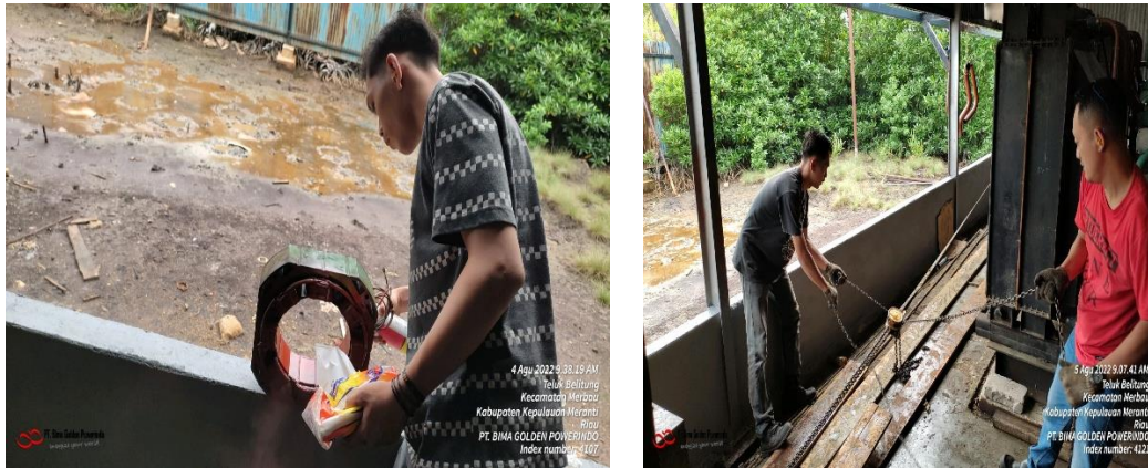
Gamabr 2.11 pemindahan generator engine E#3 ke generator engine E#1
