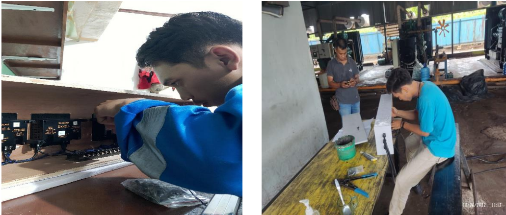
Gamabr 2.5 Perakitan monitor Metering pada Feeder Mengkirau
