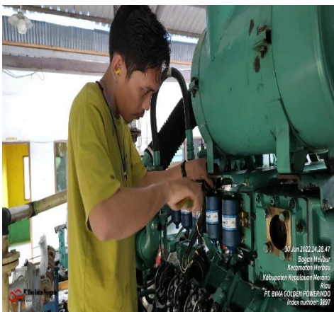
Gamabr 2.10 PM 500 pada engine E#10 dan Cleaning filter udara
