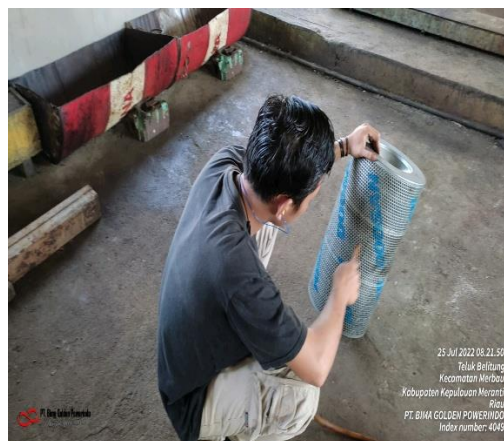
Gamabr 2.10 PM 500 pada engine E#10 dan Cleaning filter udara
