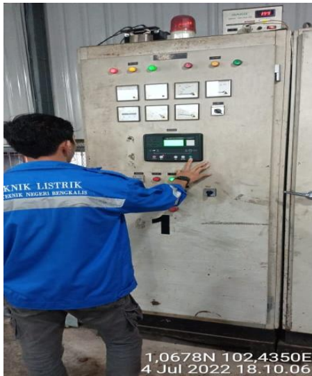
Gmbar 2.3 Penormalan engine dan feeder saat terjadi Trip dan BO
