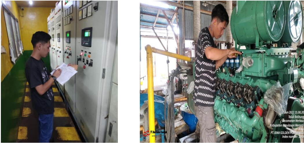
Gambar 2.1 Pengambilan data beban pada panel sinkron dan PM 500 pada engine E#7
