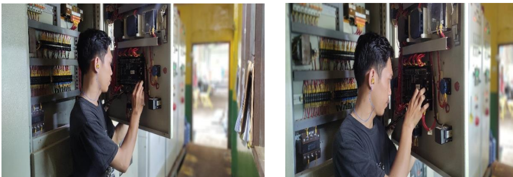
Gamabr 2.6 memprogram dan memasang DSE pada panel sinkront
