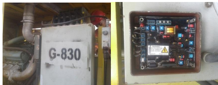
Gambar8 Pemeliharaan emergency genset
