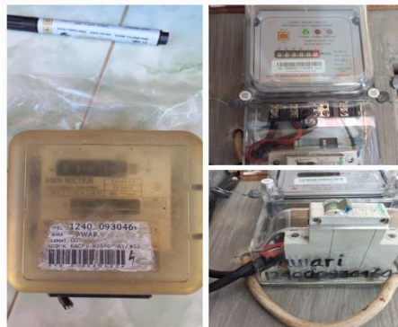
Gambar 2.10 Penggantian KWH Meter Atas nama Hawari Sumber: (Dokumentasi, 2022)
