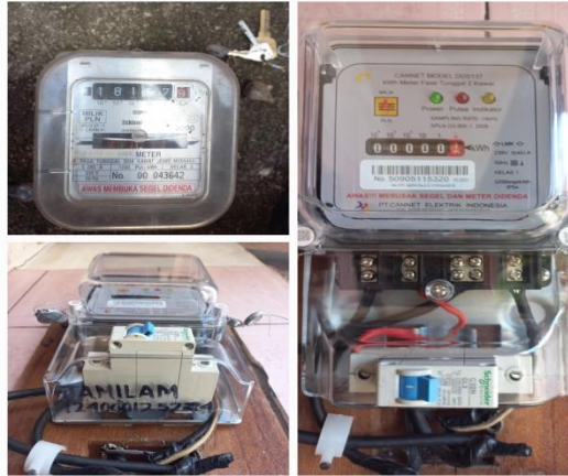
Gambar 2.17 Penggantian KWH Meter Atas nama Jamilam Sumber: (Dokumentasi, 2022)
