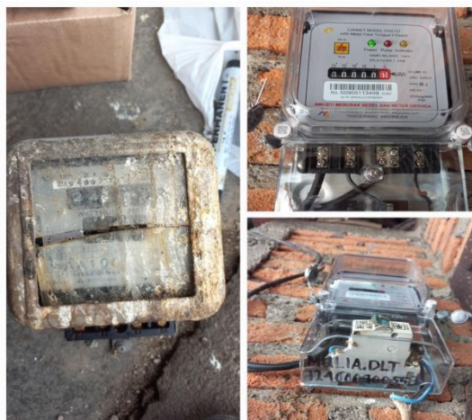
Gambar 2.18 Penggantian KWH Meter Atas nama Mulia Dalimunte Sumber: (Dokumentasi, 2022)
