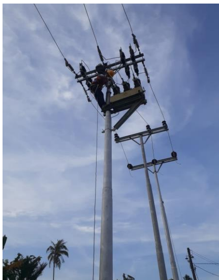
Gambar 2.21 Pembangunan Jaringan Tegangan Menengah Sumber: (Dokumentasi, 2022)
