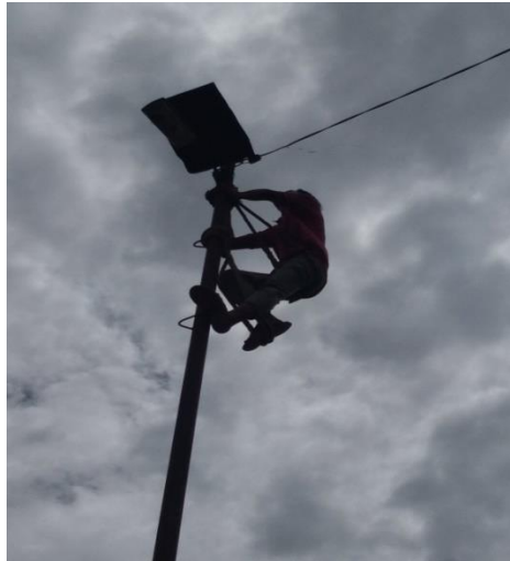
Gambar 2.6 Pemasangan Lampu Jalan Sumber: (Dokumentasi, 2022)
