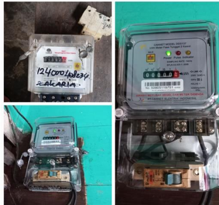
Gambar 2.14 Penggantian KWH Meter Atas nama Jakaria Sumber: (Dokumentasi, 2022)
