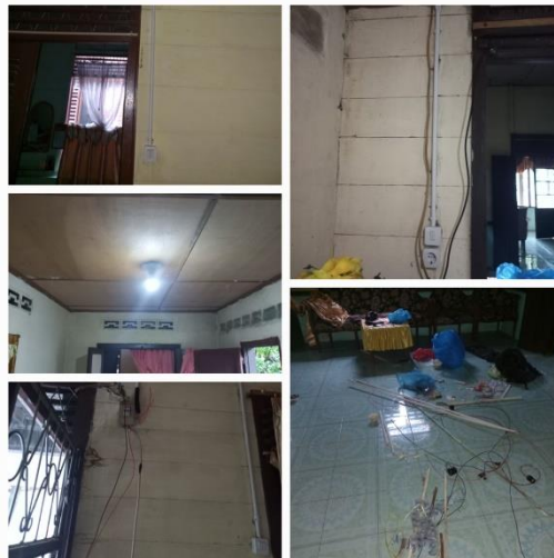
Gambar 2.3 Pemasangan Instalasi sebuah rumah di Desa Sigalangan Sumber: (Dokumentasi, 2022)
