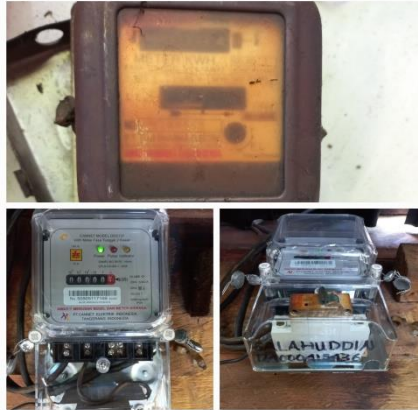
Gambar 2.11 Penggantian KWH Meter Atas nama Salahuddin Harahap Sumber: (Dokumentasi, 2022)
