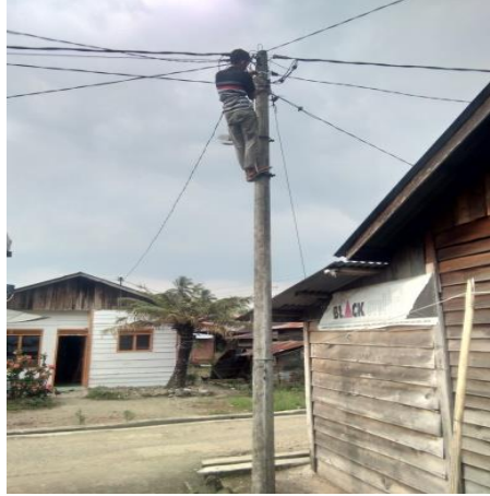
Gambar 2.4 Penyambungan kabel ACSR Sumber: (Dokumentasi, 2022)
