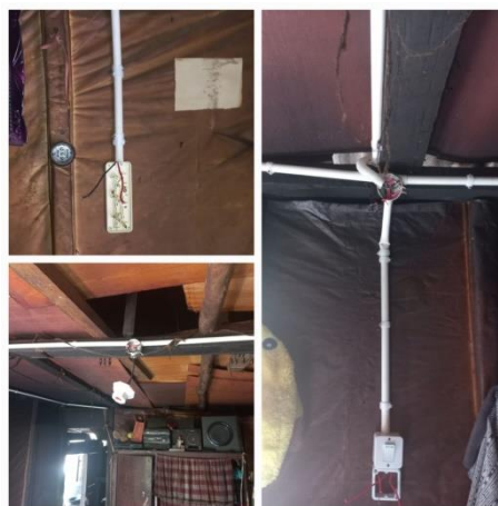
Gambar 2.1 Pemasangan Instalasi di Desa Pasar Lama Sumber: (Dokumentasi, 2022)
