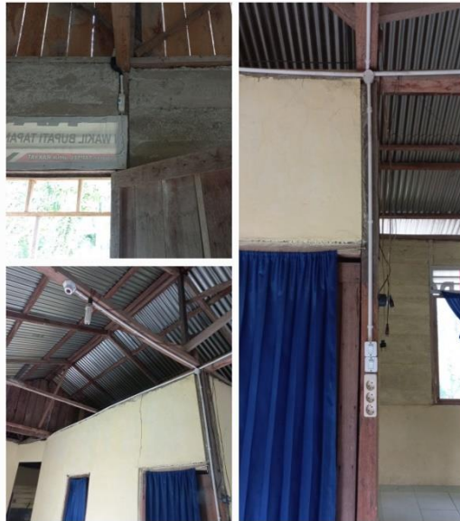
Gambar 2.2 Pemasangan Instalasi di Desa Pintu Padang Sumber: (Dokumentasi, 2022)
