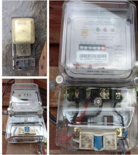
Gambar 2.13 Penggantian KWH Meter Atas nama Akhad Zubeir Sumber: (Dokumentasi, 2022)
