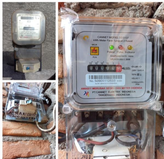
Gambar 2.12 Penggantian KWH Meter Atas nama Asran Lubis Sumber: (Dokumentasi, 2022)
