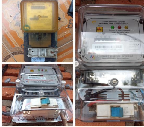
Gambar 2.15 Penggantian KWH Meter Atas nama Torkis Sumber: (Dokumentasi, 2022)
