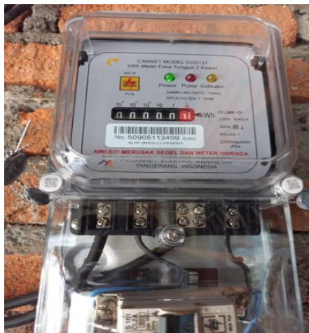
Gambar 2.5 Pemasangan KWH Meter Sumber: (Dokumentasi, 2022)
