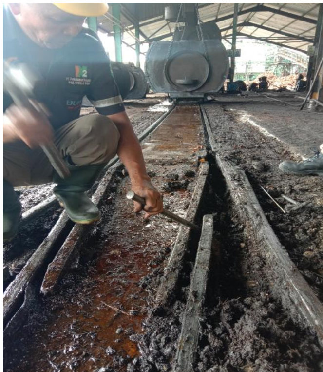
Gambar 3. 6 Perbaikan Rel Lori
