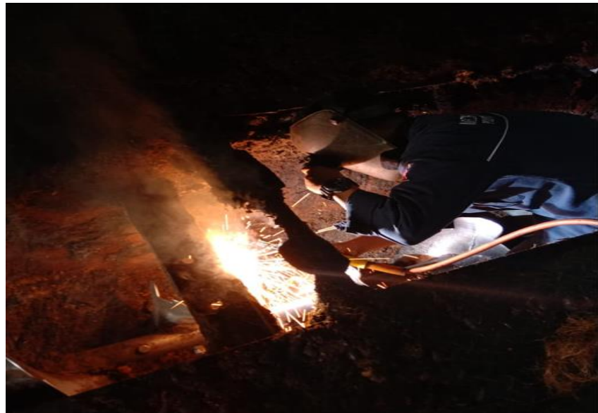
Gambar 3. 2 Perbaikan gantungan cake breacer
