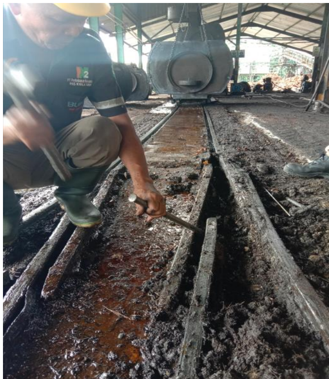
Gambar 3. 6 Perbaikan Rel Lori
