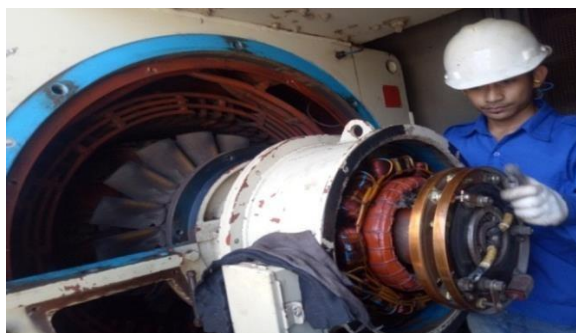
Gambar 3.7 Eksitasi tipe brushless Sumber : dokumentasi
