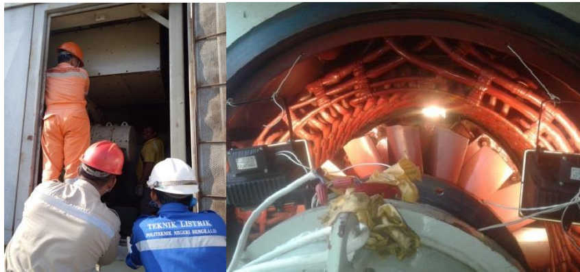
Gambar 2.5 Pemeliharaan generator turbin (Sumber : Dokumentasi)
