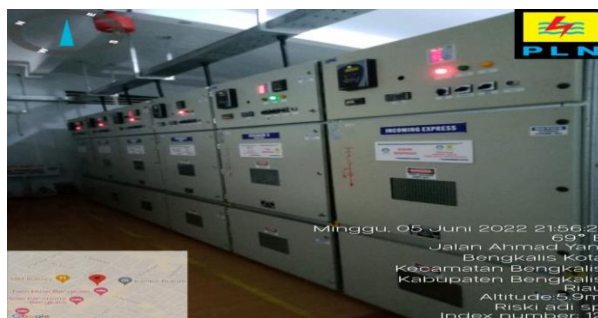
Gambar2.3 Pengecekan eviden beban feder
