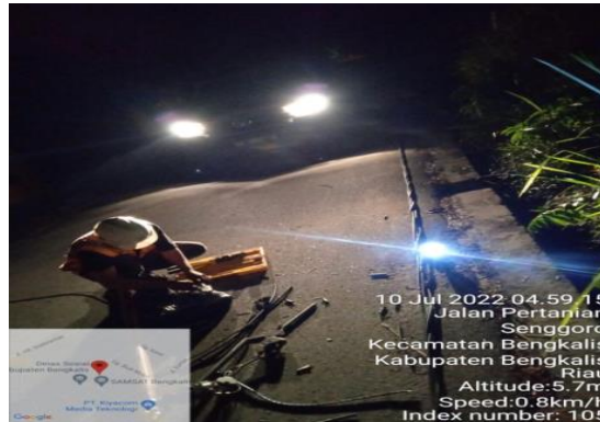
Gambar 2.25 penyambungan kabel SKU yang putus (Sumber: PT. Adra Gemilang 2022)
