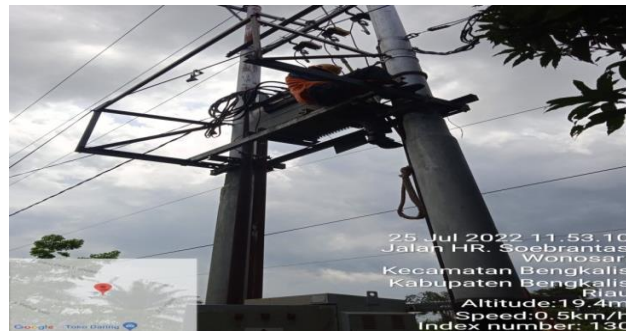
Gambar 2.35 Pemasangan kabel grounding
