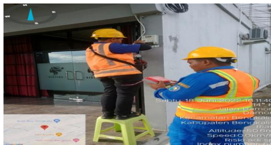
Gambar 2.12 Pergantian kwh meter pelanggan yang rusak dengan kwh meter sementara\kwh meter dumi
