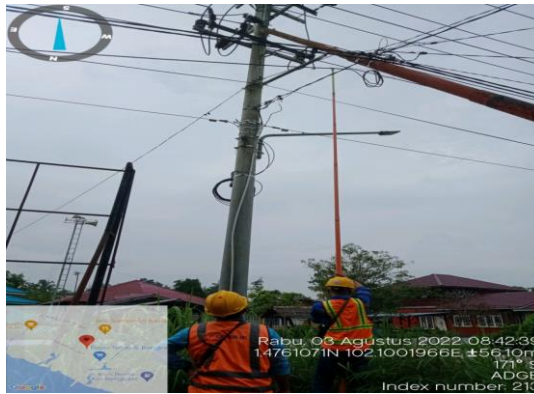
Gambar 2.41 Penggantian fuse link \ FCO (fuse cut out) yang putus.
