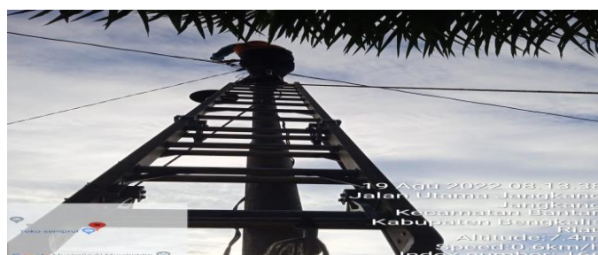
Gambar 2.52 Mengatasi kabel SR yang kendor
