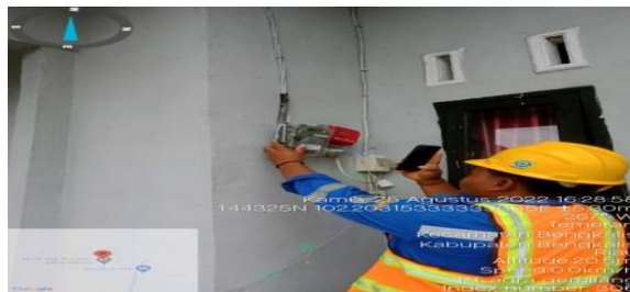
Gambar 2.56 Penggantian kWh meter sementara / meter dami
