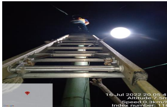
Gambar 2.29 Mengatasi gangguan pelanggan los kontak di tiang listrik (Sumber: PT. Adra Gemilang 2022)
