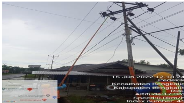
Gambar 2.9 Melakukan pergantian Fuse link yang putus (Sumber: PT. Adra Gemilang 2022)
