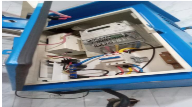
Gambar 2.39 Pemadaman bergilir (Sumber: PT. Adra Gemilang 2022)
