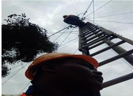
Gambar 2.19 Penyambungan kabel SR yang putus (Sumber: PT. Adra Gemilang 2022)
