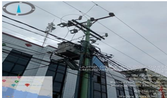
Gambar 2.43 Penggantian fuse link \ FCO (fuse cut out) yang putus (Sumber: PT. Adra Gemilang 2022)
