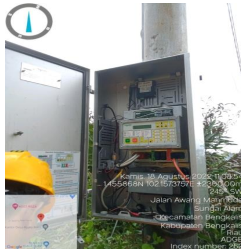
Gambar 2.51 Mengatasi gangguan RC ( Recloser )
