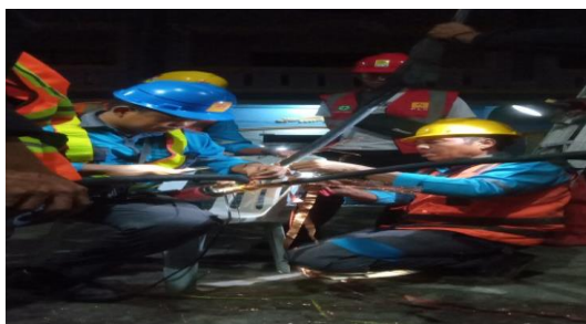
Gambar 2.14 Pemasangan kabel SKTM (Sumber: PT. Adra Gemilang 2022)
