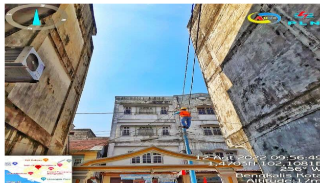
Gambar 2.48 Mengatasi gangguan los contact fasa di rumah pelanggan
