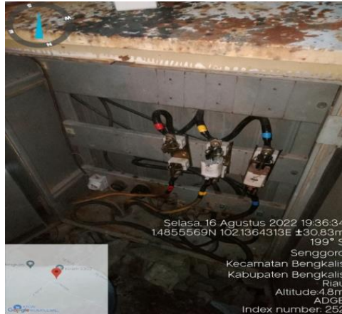
Gambar 2.49 Mengganti NH fuse pada gardu listrik
