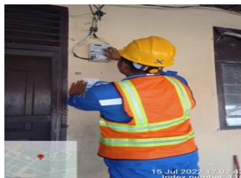
Gambar 2.28 Memasukan kode kct di rumah pelanggan (Sumber: PT. Adra Gemilang 2022)
