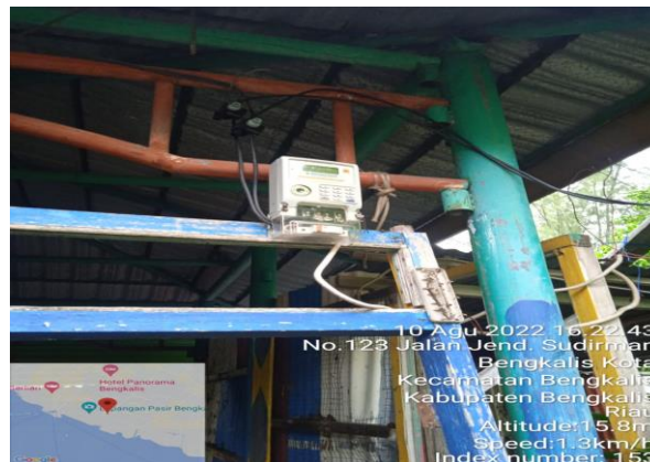
Gambar 2.46 Mengganti MCB pelanggan (Sumber: PT. Adra Gemilang)
