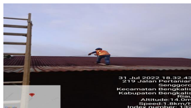
Gambar 2.38 Penyambungan kabel SR (Sumber: PT. Adra Gemilang 2022)
