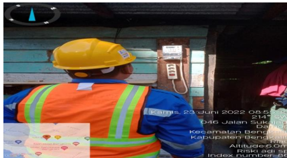
Gambar 2.15 Mengatasi gangguan pelanggan los kontak
