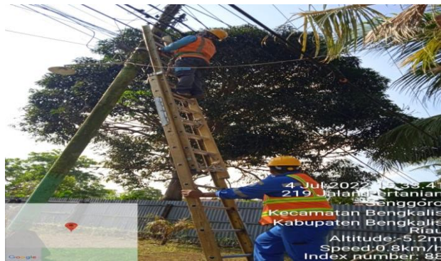
Gambar 2.21 Mengatasi gangguan los kontak
