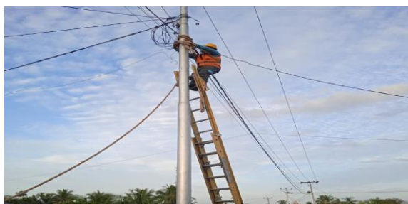
Gambar 2.26 Mengatasi kabel SR yang kendor (Sumber: PT. Adra Gemilang 2022)
