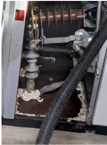
Gambar 2.14 Memasang Pertinax
