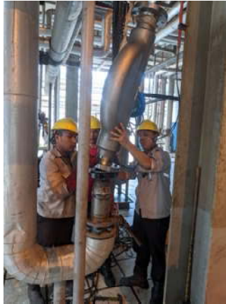
Gambar 2.12 Memasang Flow Meter
