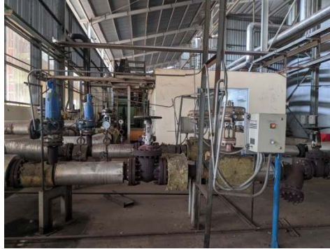
Gambar 2.6 PRV 30 bar to 16 bar
