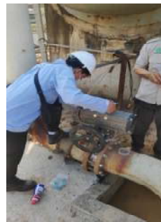
Gambar 2.9 Memasang Tubing Konektor
