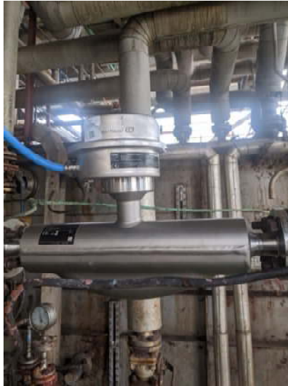
Gambar 2.16 Memasang Flow Meter
