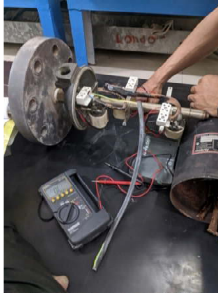
Gambar 2.10 Memperbaiki Level Kontrol
