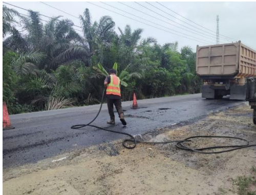
Gambar 4.15 Penyemprotan Tack Coat (Lapis Perekat) (Sumber: Dokumentasi Lapangan Kerja Praktek 2022)
