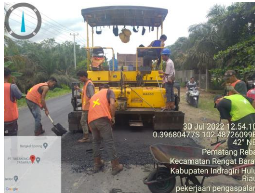
Gambar 3.7 Penghamparan Laston Lapis Aus ( AC-WC_{NR} ) (Sumber: Dokumentasi Lapangan Kerja Praktek 2022)
