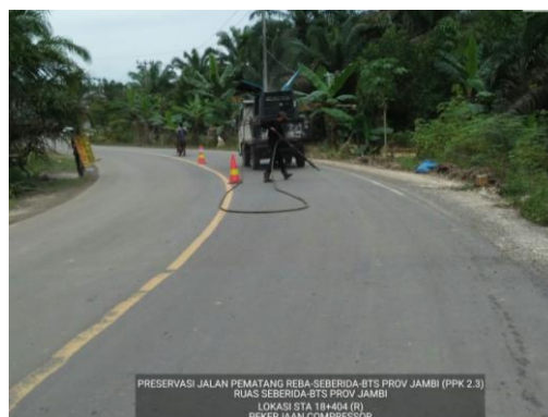
Gambar 4.14 Pekerjaan Air Compressor (Sumber: Dokumentasi Lapangan Kerja Praktek 2022)
