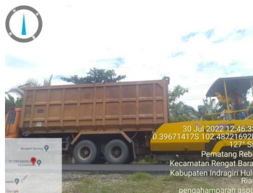
Gambar 4.16 Mobilisasi Laston Lapis Aus (AC-WC NR ) (Sumber: Dokumentasi Lapangan Kerja Praktek 2022)
