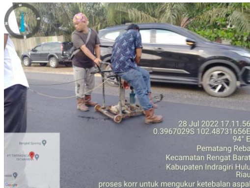
Gambar 4.23 Core Drill Test Laston Lapis Aus ( AC-WC_{NR} ) (Sumber: Dokumentasi Lapangan Kerja Praktek 2022)
