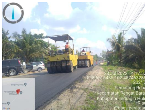
Gambar 4.22 Pematatan Menggunakan Pneumatic Tired Roller (Sumber: Dokumentasi Lapangan Kerja Praktek 2022)
