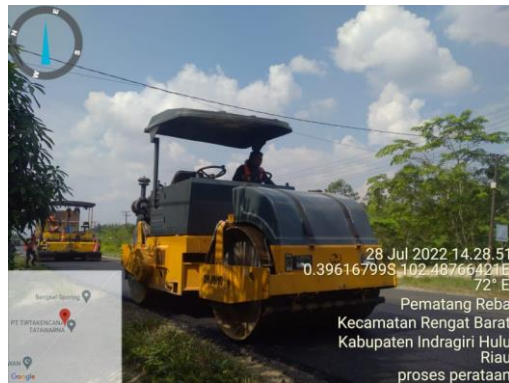
Gambar 3.9 Pematatan Menggunakan Tandem Roller (Sumber: Dokumentasi Lapangan Kerja Praktek 2022)
