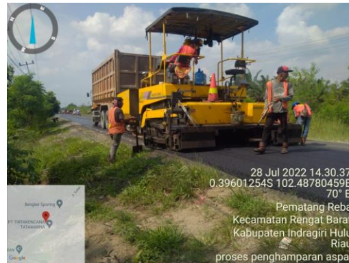
Gambar 4.5 Asphalt Finisher (Sumber: Dokumentasi Lapangan Kerja Praktek 2022)
