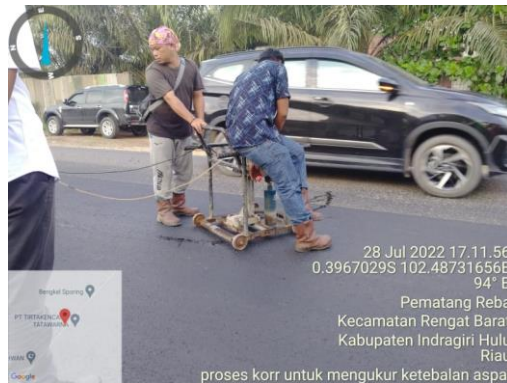
Gambar 3.11 Core Drill Test Laston Lapis Aus (AC-WC NR ) (Sumber: Dokumentasi Lapangan Kerja Praktek 2022)
