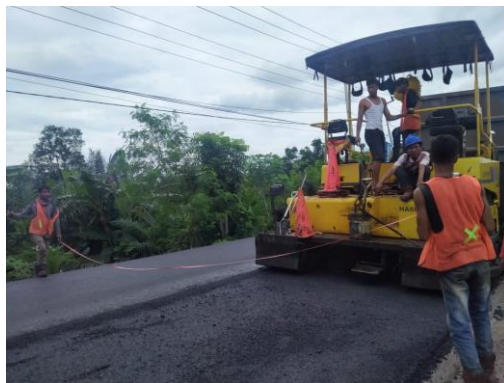
Gambar 3.8 Pengecekan Lebar Laston Lapis Aus ( AC-WC_{NR} ) (Sumber: Dokumentasi Lapangan Kerja Praktek 2022)
