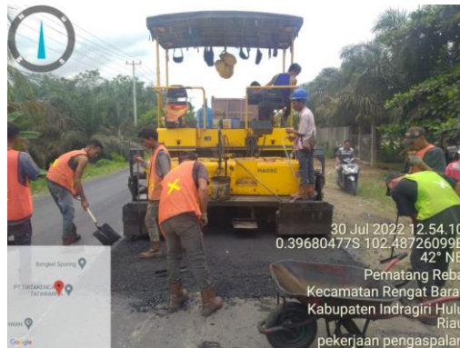
Gambar 4.19 Penghamparan Laston Lapis Aus (AC-WC NR ) (Sumber: Dokumentasi Lapangan Kerja Praktek 2022)
