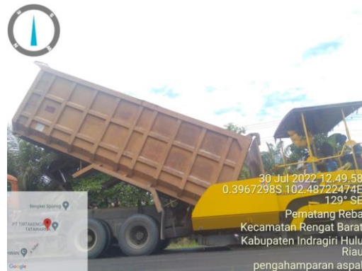
Gambar 4.17 Proses Masuk Laston Lapis Aus (AC-WC NR ) ke dalam Asphalt Finisher (Sumber: Dokumentasi Lapangan Kerja Praktek 2022)
