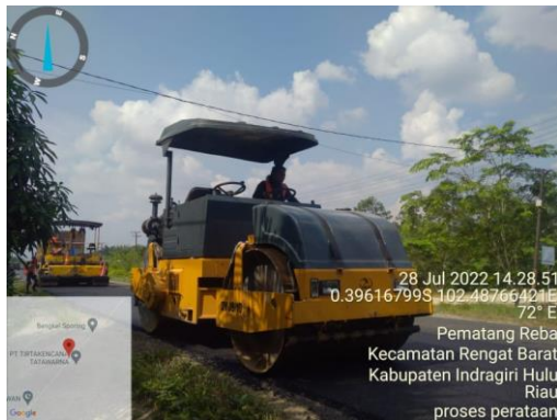
Gambar 4.21 Pematatan Menggunakan Tandem Roller (Sumber: Dokumentasi Lapangan Kerja Praktek 2022)
