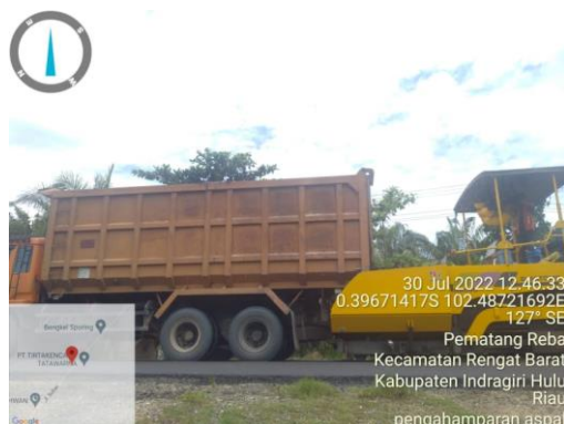
Gambar 3.4 Mobilisasi Laston Lapis Aus (AC-WC NR ) (Sumber: Dokumentasi Lapangan Kerja Praktek 2022)
