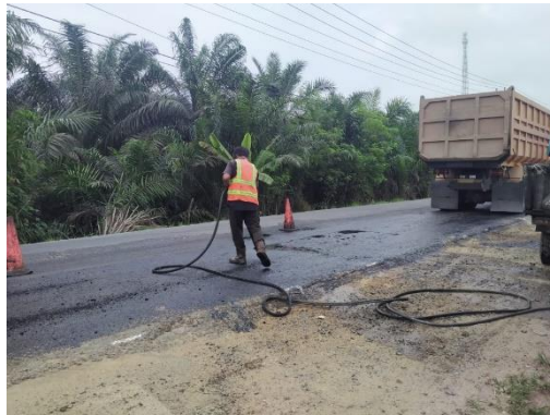
Gambar 3.1 Penyemprotan Tack Coat (Lapis Perekat) (Sumber: Dokumentasi Lapangan Kerja Praktek 2022)
