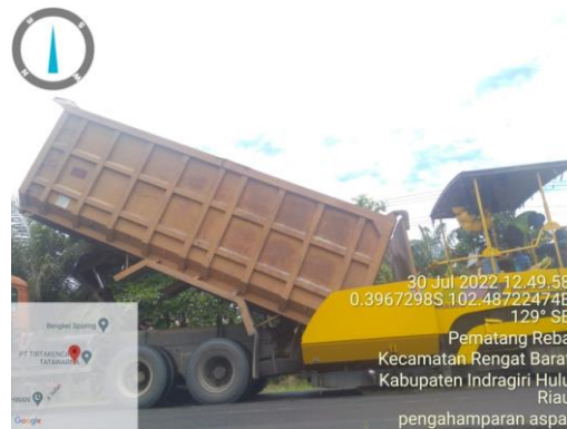
Gambar 3.5 Proses Masuk Laston Lapis Aus ( AC-WC_{NR} ) ke dalam Asphalt Finisher (Sumber: Dokumentasi Lapangan Kerja Praktek 2022)
