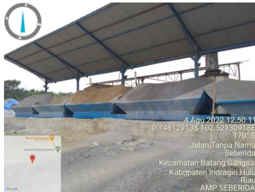
Gambar 3.2 Persiapan Material di dalam Colt Bin (Sumber: Dokumentasi Lapangan Kerja Praktek 2022)
