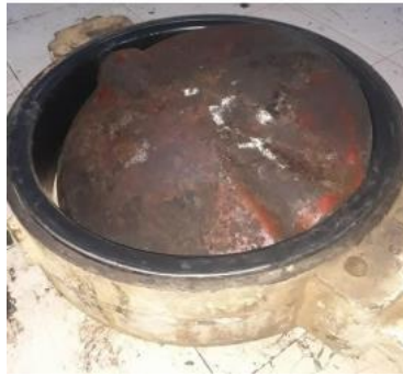
Gambar 4. 18 Memasang Rubber Liner dengan Rapat Sumber : Data Olahan 2022
