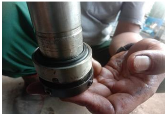
Gambar 4.7 Penggantian Oring dan Mechanical Seal yang baru
