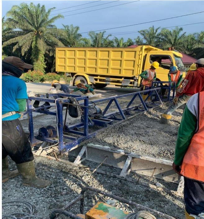
Gambar 4.12. Perataan Menggunakan Mesin Screed Beton
