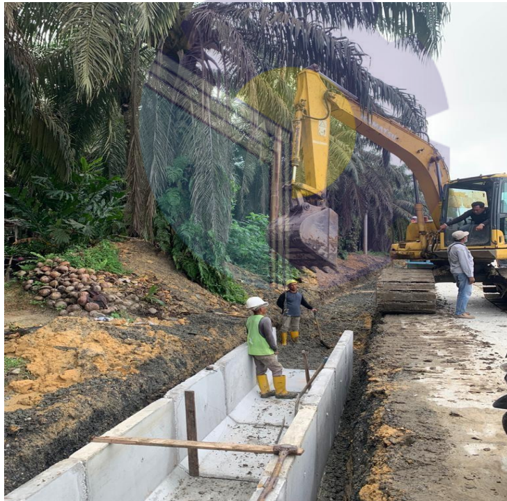
Gambar 3.16 Pekerjaan Saluran U-Ditch
