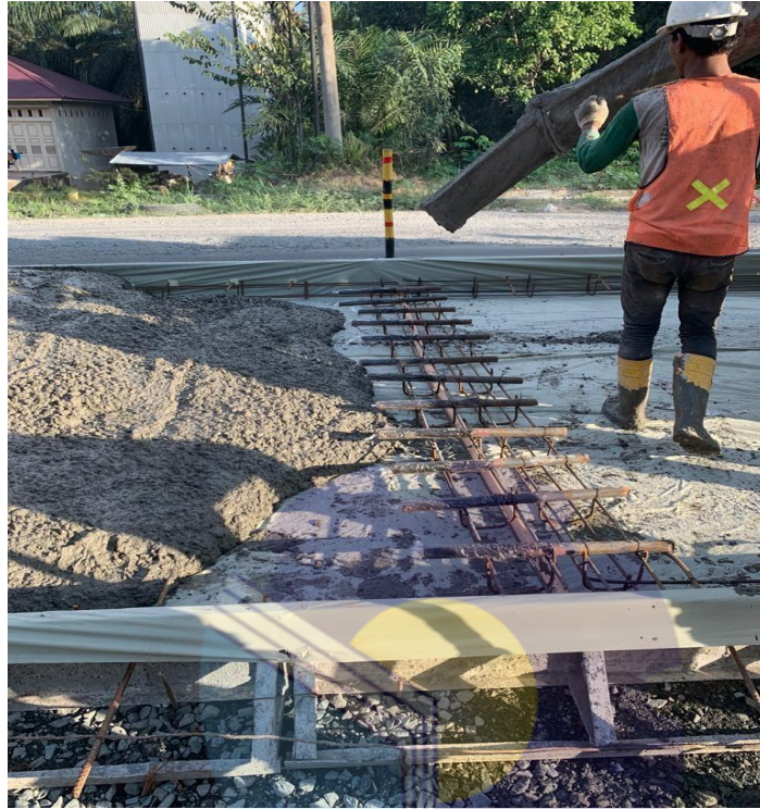
Gambar 3.15 Pekerjaan Pengecoran Beton Sumber : Dokumentasi Kerja Praktek, 2022
