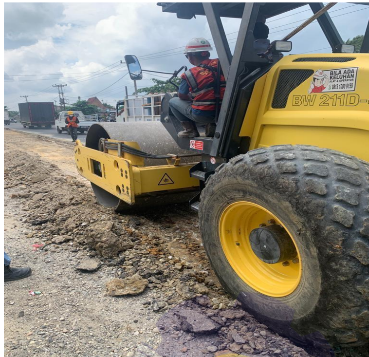
Gambar 3.10 Pekerjaan Pemasangan Bahu Jalan Sumber : Dokumentasi Kerja Praktek, 2022
