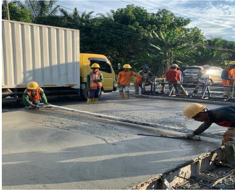
Gambar 4.14. Perataan Menggunakan Roskam Kayu
