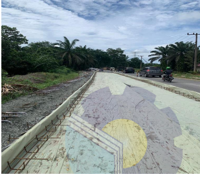
Gambar 3.13 Pekerjaan Pemasangan Terpal
