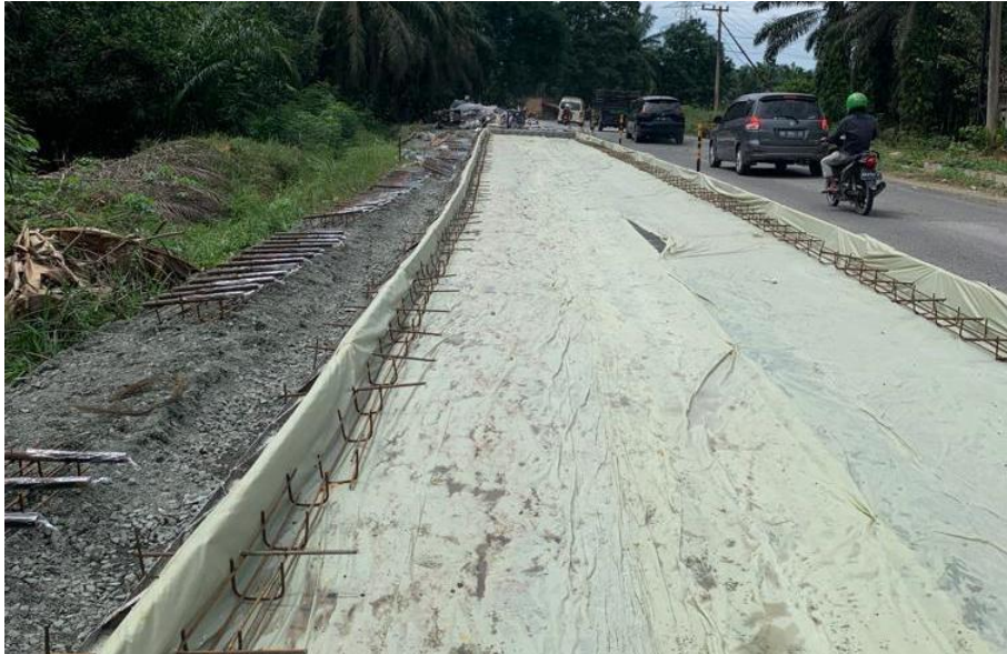
Gambar 4.9. Pemasangan Tulangan Tie Bar
