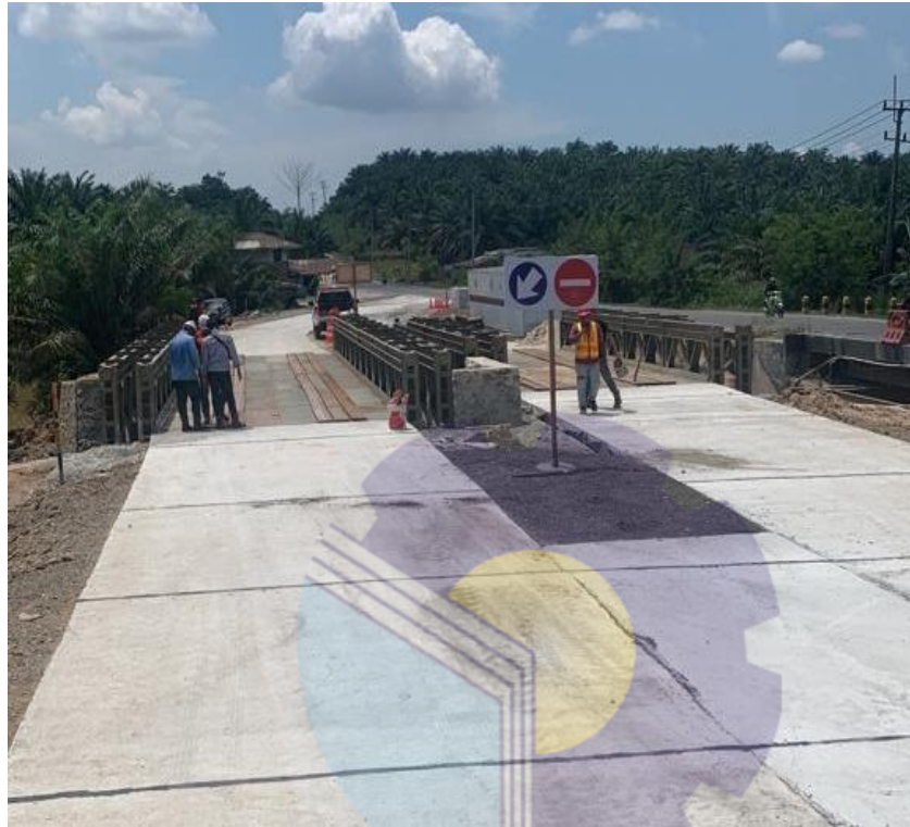
Gambar 3.17 Pekerjaan Rekonstruksi Jembatan Kerinci Kecil
