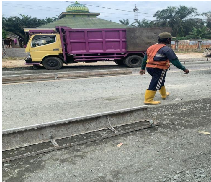
Gambar 3.11 Pekerjaan Pemasangan Bekisting Badan Jalan
