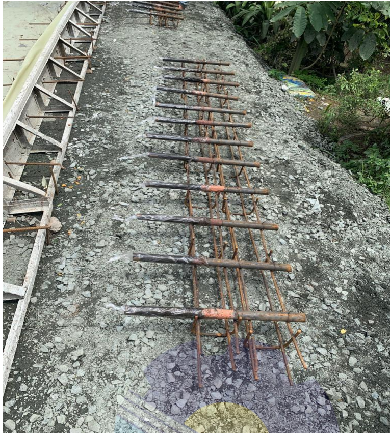
Gambar 3.14 Pekerjaan Pemasangan Tulangan Dowel
