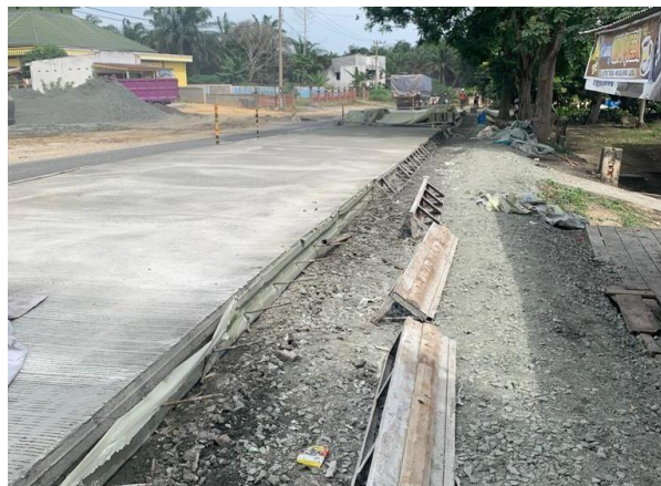
Gambar 4.15. Pembongkaran Bekisting
