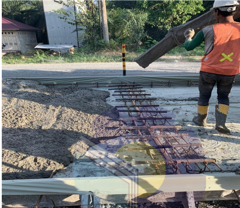
Gambar 4.10. Penghamparan Campuran Beton Sumber : Dokumen Kerja Praktek, 2022
