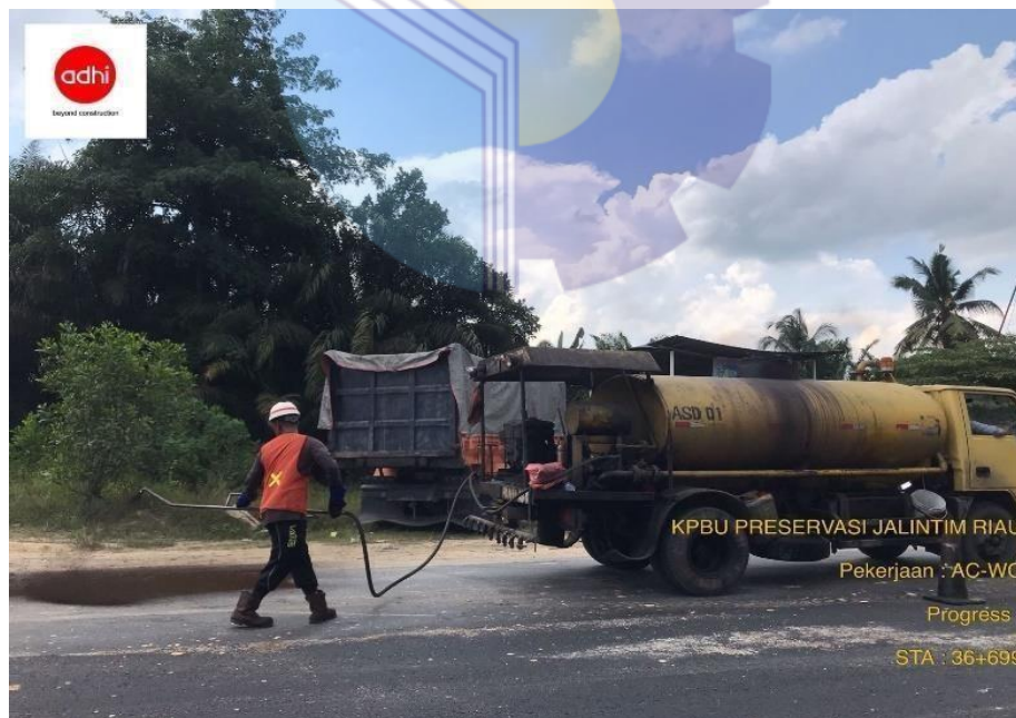
Gambar 3.6 Pekerjaan Penyemprotan Lapis Perekat( TackCoat ) Sumber : Dokumentasi Kerja Praktek, 2022
