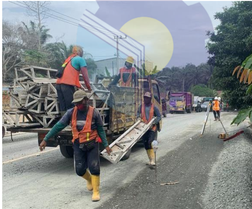
Gambar 4.5. Pemasangan Bekisting Sumber : Dokumen Kerja Praktek, 2022
