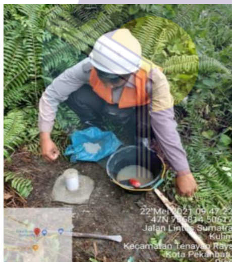
Gambar 4.1. Pembentukan Titik BM Pengukuran
