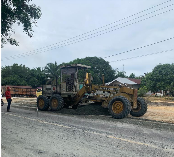
Gambar 3.9 Pekerjaan Penimbunan base Sumber : Dokumentasi Kerja Praktek, 2022
