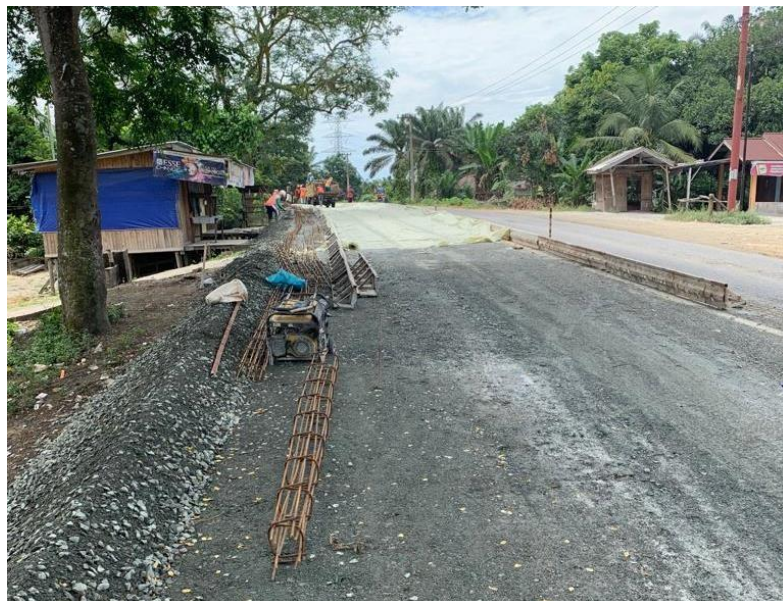
Gambar 4.6. Pemasangan Bekisting Sumber : Dokumen Kerja Praktek, 2022
