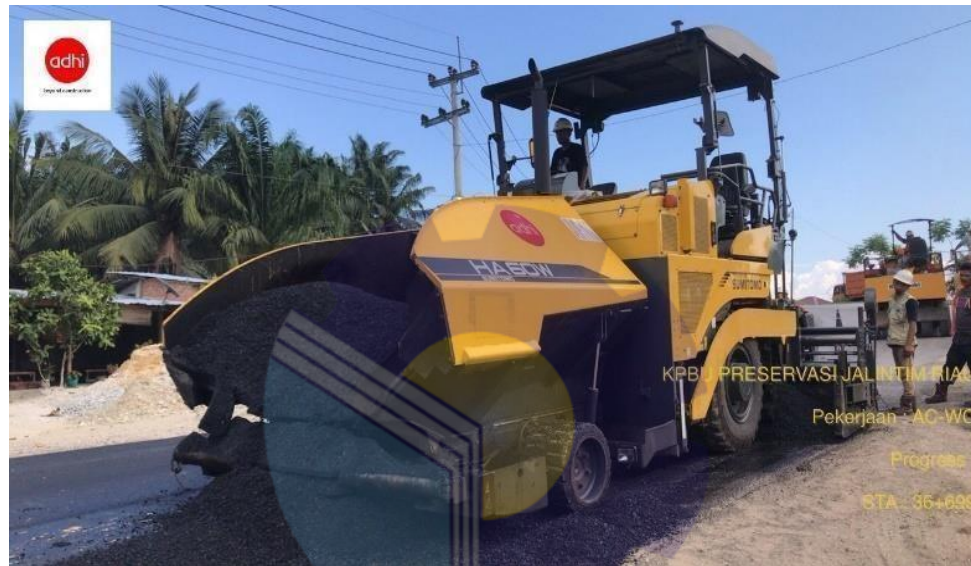
Gambar 3.7 Pekerjaan Penghamparan AC-WC Sumber : Dokumentasi Kerja Praktik, 2022
