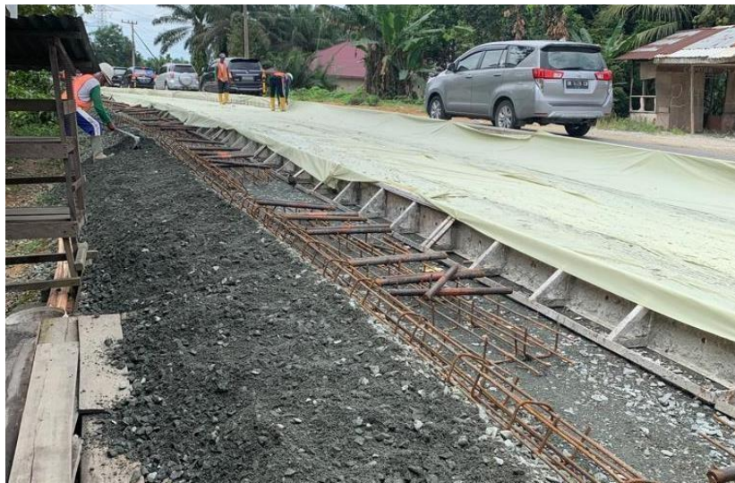
Gambar 4.7. Pemasangan Terpal Plastik
