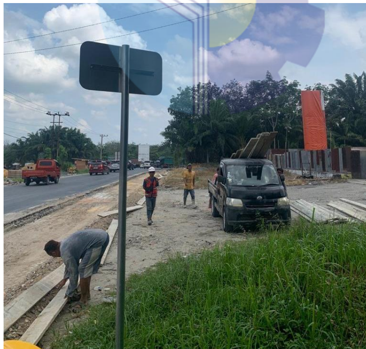
Gambar 3.12 Pekerjaan Pemasangan Bekisting Bahu Jalan
