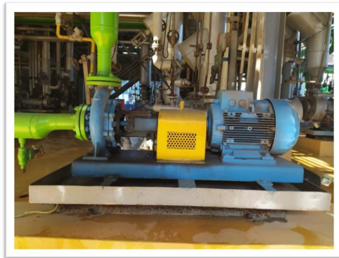
Gambar 4.1 Pompa Sentrifugal
