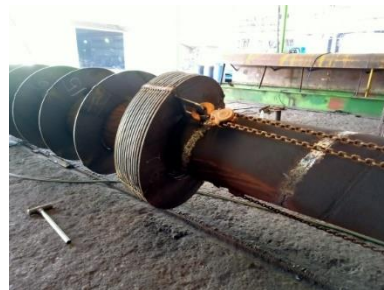
Gambar 4. 21 Pemasangan Daun Screw
