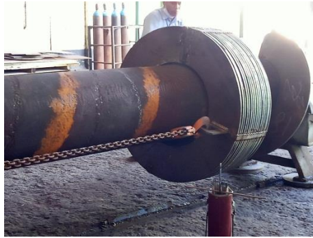
Gambar 4. 17 Pemasangan Daun Screw Conveyor
