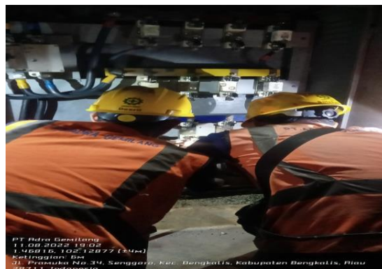
Gambar 2.36 Penggantian NH FUSE (Sumber: PT. Adra Gemilang 2022)
