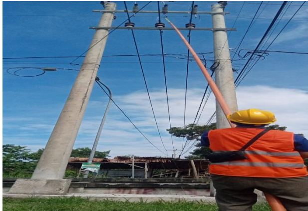
Gambar 2.32 Penggantian FCO ( Fuse Cut Out ) (Sumber: PT. Adra Gemilang 2022)
