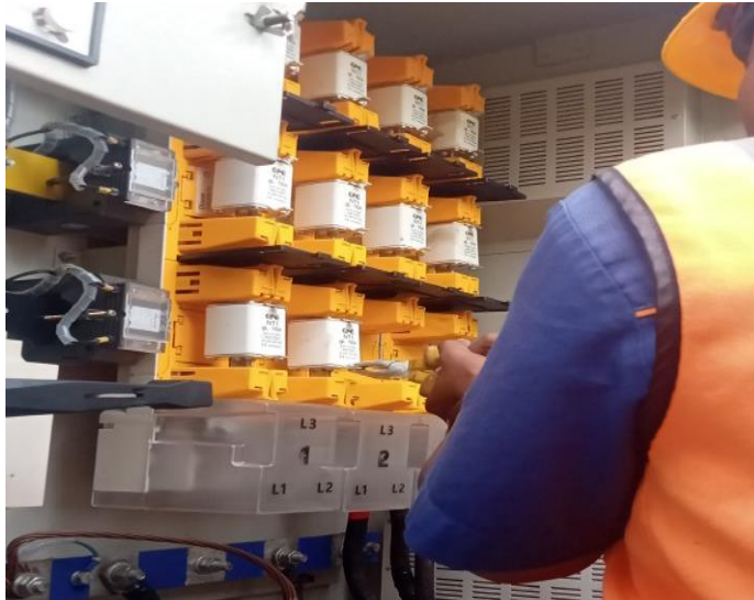
Gambar 2.48 Mengganti NH FUSE (Sumber: PT. Adra Gemilang 2022)
