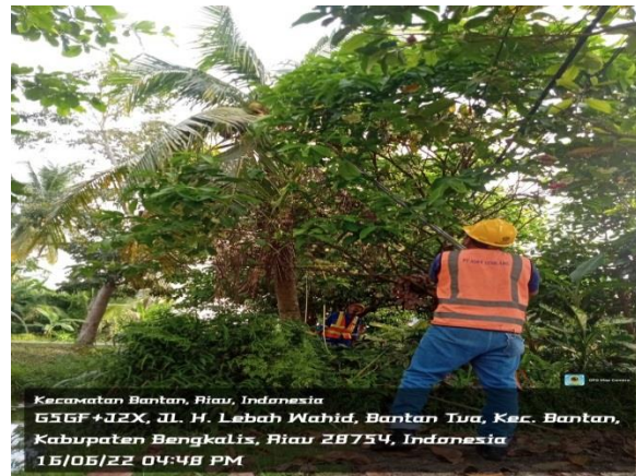
Gambar 2.7 Pemangkasan Jaringan Tegangan Menengah
