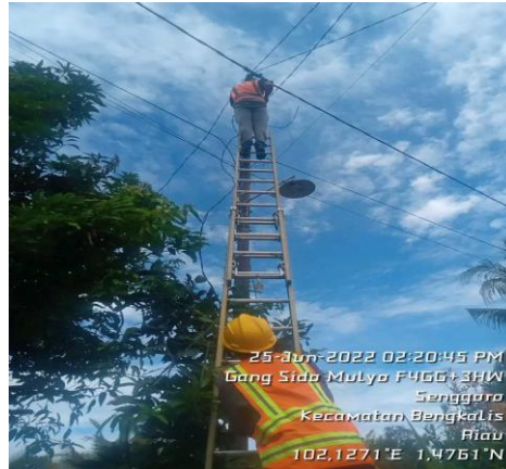
Gambar 2.13 Memperbaiki Kabel SR Kendor (Sumber: PT. Adra Gemilang 2020)
