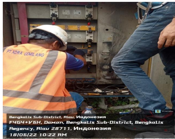
Gambar 2.9 Inspeksi Gardu Distribusi (Sumber: PT. Adra Gemilang 2022)
