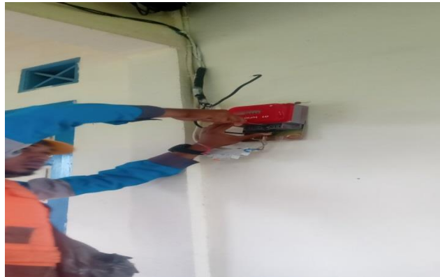
Gambar 2.29 Penggantian kwh meter sementara (Sumber: PT. Adra Gemilang 2022)
