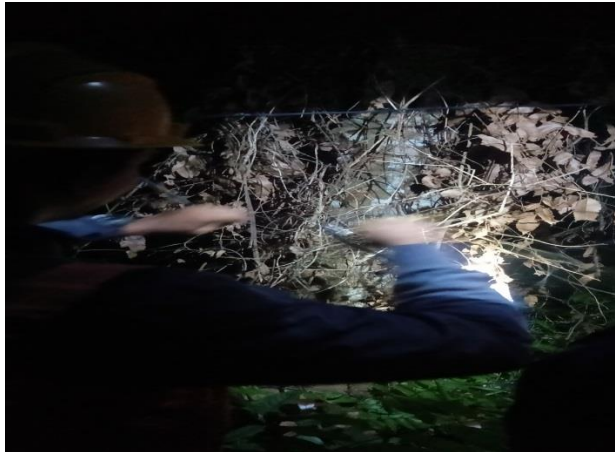
Gambar 2.30 Memperbaiki kabel SR putus (Sumber: PT. Adra Gemilang 2022)
