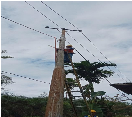
Gambar 2.31 Memperbaiki kabel TM putus (Sumber: PT. Adra Gemilang 2022)
