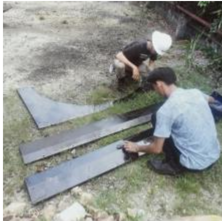
Gambar 2.12 Kegiatan membersihkan cover radiator unit empat (Sumber: PT. Megapower Makmur Tbk. 2022)
