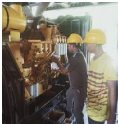
Gambar 2.33 Kegiatan mengganti filter oli (Sumber: PT. Megapower Makmur Tbk. 2022)
