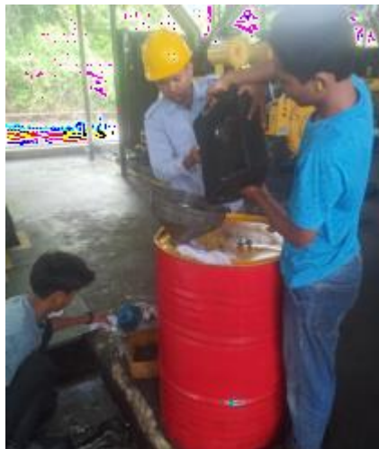
Gambar 2.27 Kegiatan membersihkan saluran oli (Sumber: PT. Megapower Makmur Tbk. 2022)
