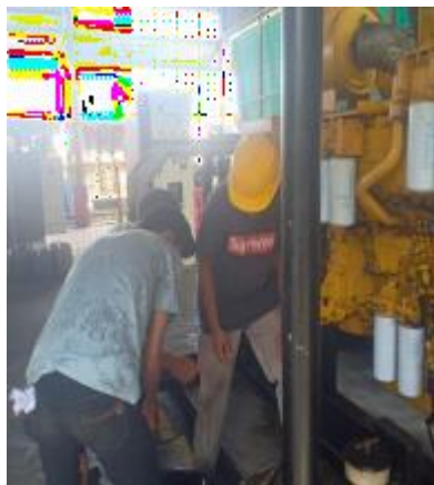
Gambar 2.38 Kegiatan penambahan oli pada unit dua (Sumber: PT. Megapower Makmur Tbk. 2022)
