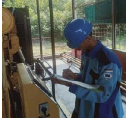
Gambar 2.26 Kegiatan monitoring KWH setiap jamnya (Sumber: PT. Megapower Makmur Tbk. 2022)
