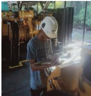
Gambar 2.7 Kegiatan monitoring KWH setiap jamnya (Sumber: PT. Megapower Makmur Tbk. 2022)
