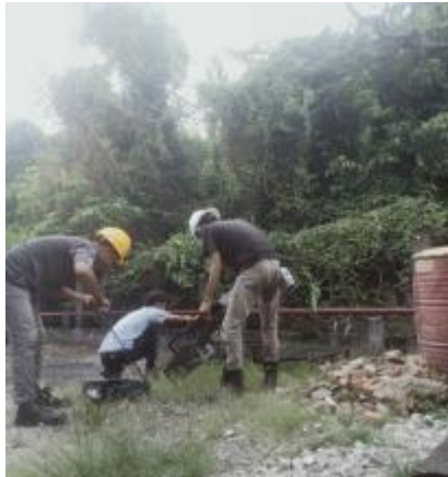
Gambar 2.28 Kegiatan membersihkan cover radiator unit tiga (Sumber: PT. Megapower Makmur Tbk. 2022)
