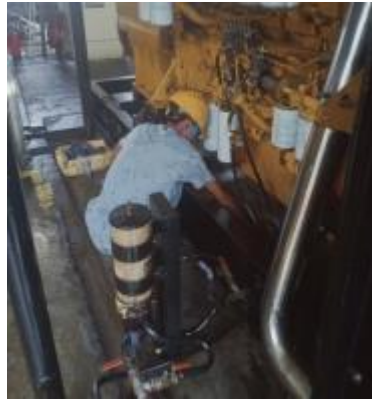
Gambar 2.2 Kegiatan membersihkan limbah oli di bawah mesin (Sumber: PT. Megapower Makmur Tbk. 2022)
