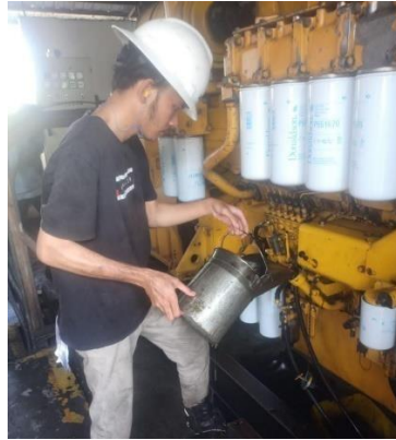
Gambar 2.41 Kegiatan penambahan oli (Sumber: PT. Megapower Makmur Tbk. 2022)
