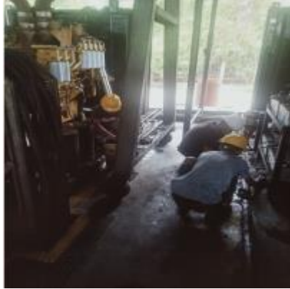
Gambar 2.34 Kegiatan membersihkan limbah oli dibawah mesin dan saluran oli (Sumber: PT. Megapower Makmur Tbk. 2022)
