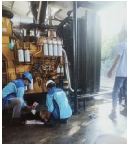
Gambar 2.6 Kegiatan membersihkan limbah oli di bawah mesin (Sumber: PT. Megapower Makmur Tbk. 2022)
