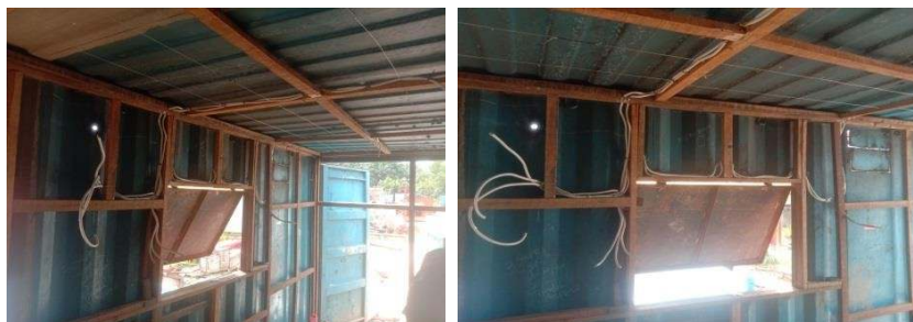
Gambar 2. 17: Pemasangan instalasi listrik. (Sumber: Dokumentasi 2022)
