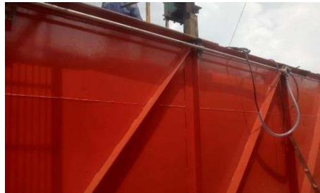
Gambar 2. 19: Pemasangan instalasi lampu Sorot.. (Sumber: Dokumentasi,2022)
