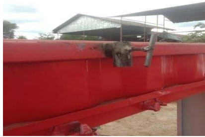
Gambar 2. 11: Membuat breket lampu sorot dan pemangan lampu sorot. (Sumber: Dokumentasi 2022)
