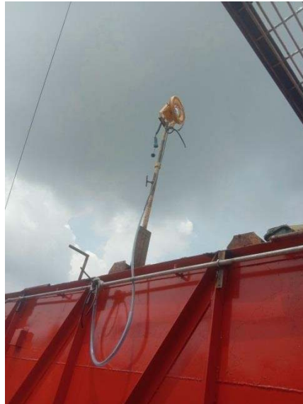
Gambar 2.22 : Pemasangan lampu sorot di tangki. (Sumber: Dokumentasi 2022)
