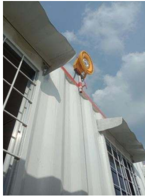
Gambar 2. 24: Pemasangan Lampu Sorot.
