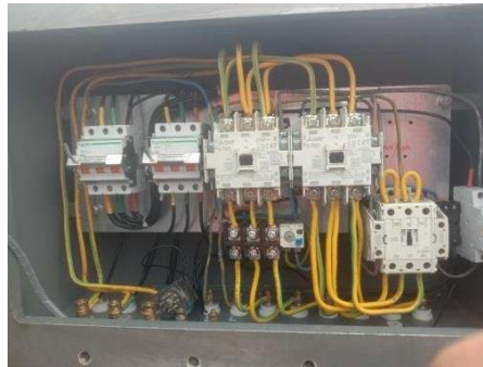
Gambar 2. 21: Merangkai Panel Listrik Star Delta. (Sumber: Dokumentasi 2022)
