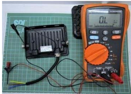
Gambar 3.17: Mengukur Kontinuitas Jalur setiap kabel Ke Bodi Lampu Sorot. (Sumber : s-gala.com)
