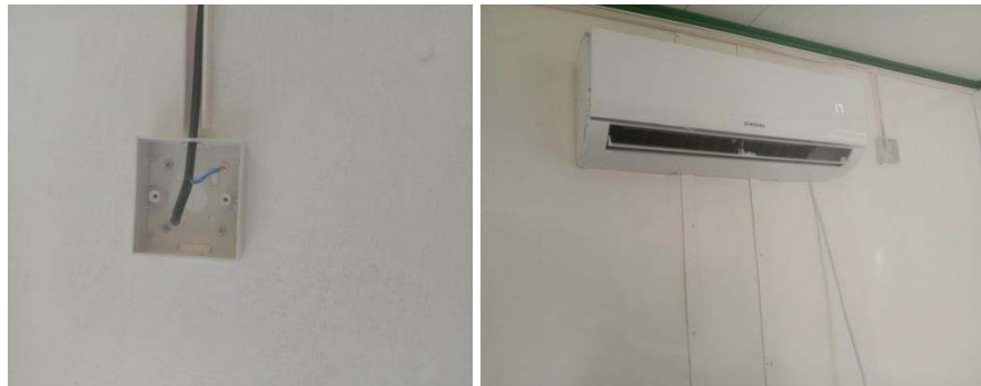
Gambar 2. 1 :Instalasi listrik dan pemasangan 2 unit Ac (Sumber: Dokumentasi 2022)
