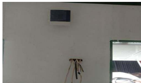
Gambar 2. 23: Pemasangan instalasi listrik ruangan. (Sumber: Dokumentasi 2022)
