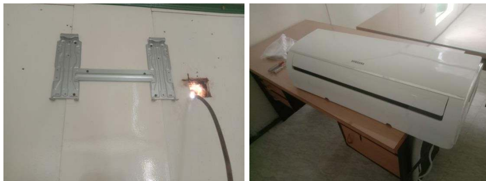
Gambar 2. 2: Instalasi listrik dan pemasangan 2unit Ac (Sumber:Dokumentasi 2022)
