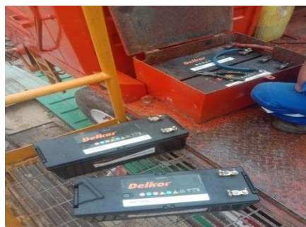
Gambar 2. 18: Memasang batrai 24V di menara Rig . (Sumber: Dokumentasi,2022)
