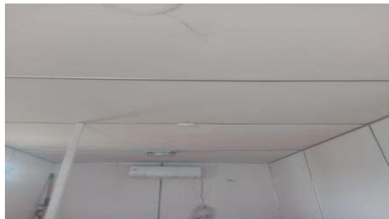
Gambar 2. 8 Menginstalasi lampu ruangan dan pemasangan lampu sorot. (Sumber: Dokumentasi 2022)
