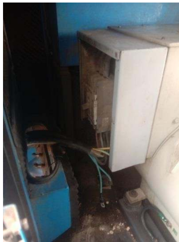
Gambar 2. 20 Memasang Control Panel Gengset. (Sumber: Dokumentasi 2022)
