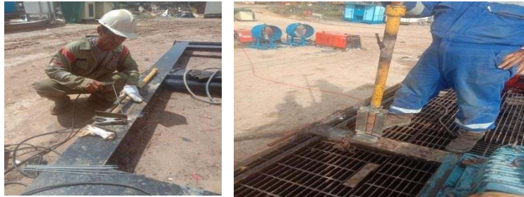
Gambar 2. 15: Membuat dan memasang breket lampu sorot di tanki. (Sumber: Dokumentasi 2022)
